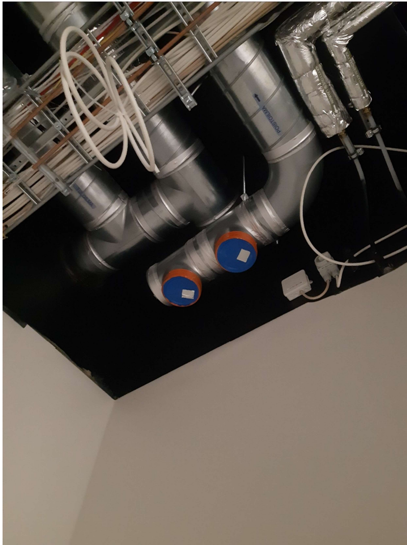
Kuva 13. Blowerproof liquid ja kanavien teippaukset.
