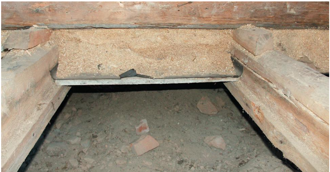
Kuva 2. Purettu sahanpurueristeinen vanha rossipohja. Eristeenä sahanpuru, aluslautojen päällä tuulensulkuna bitumivuorauspaperi [ Pohjois-Pohjanmaan korjausrakentamiskeskus, 2005 ]
