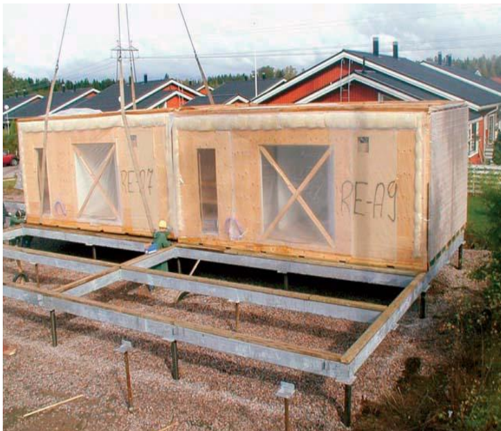
Kuva 9. RR- teräsperustus soveltuu erinomaisesti tilaelementtirakentamiseen [ www.rautaruukki.fi ]
