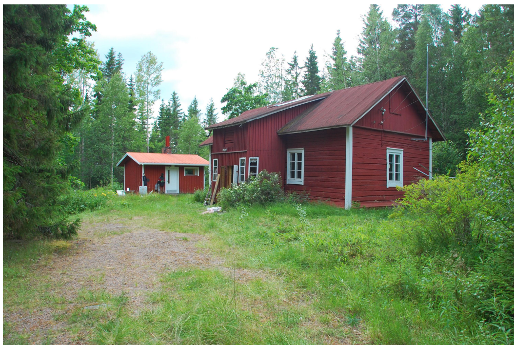
Kuva 1. Julkisivu tieltä katsottuna.
