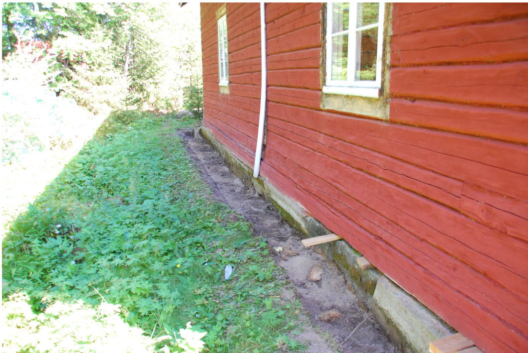
Kuva 2. Pullistuma länsiseinässä.
