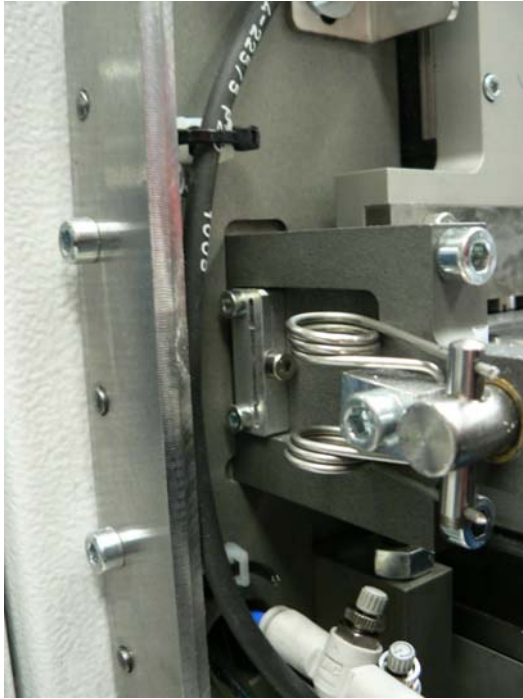
Kuva 29. Alkuperäisen anturoinnin asennuspaikka.
