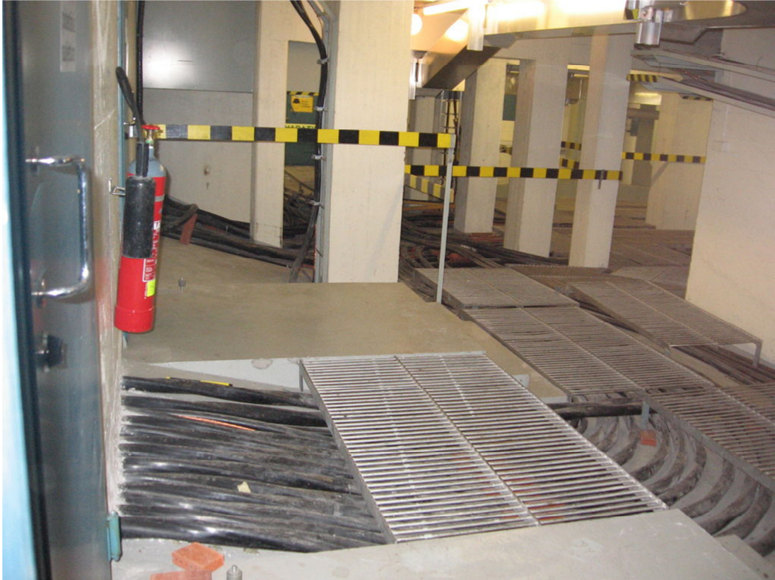
Kuva 3. Suojaamattomat keskijännitekaapelimatot.
