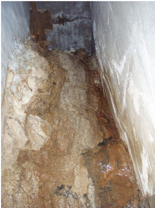
Kuva 8. Kalliotilaan jääneet puurakenteet.
