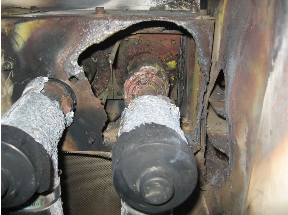
Kuva 5. Tuhoutunut keskijännitekaapelipääte.
