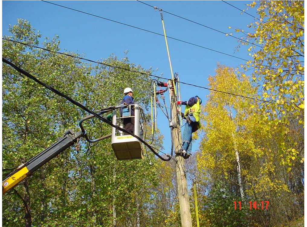
Kuva 5. Multi-Wiski-päätteen kytkeminen avolinjaan
