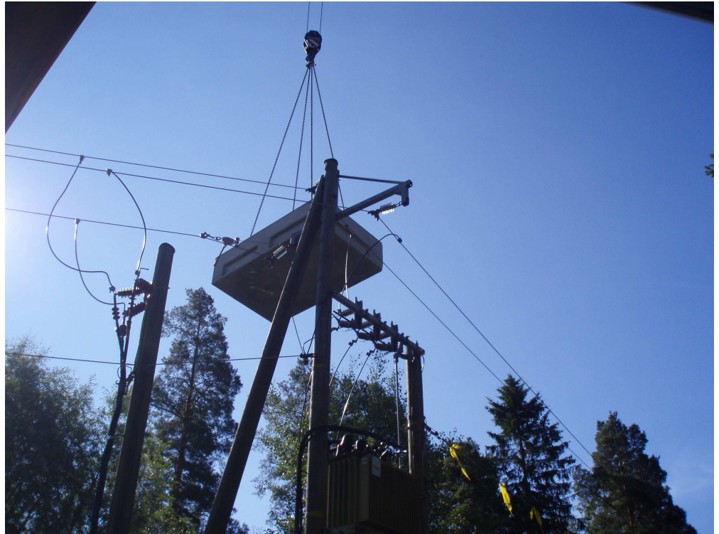
Kuva 2. Muuntajan jalustan nostaminen 20 kV:n linjan yli. Jalustan paino 3,5 tkg.
