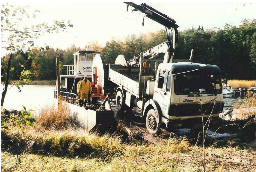
Kuva 3. Wiski-kaapelin toimittaminen lautankyytiin.
