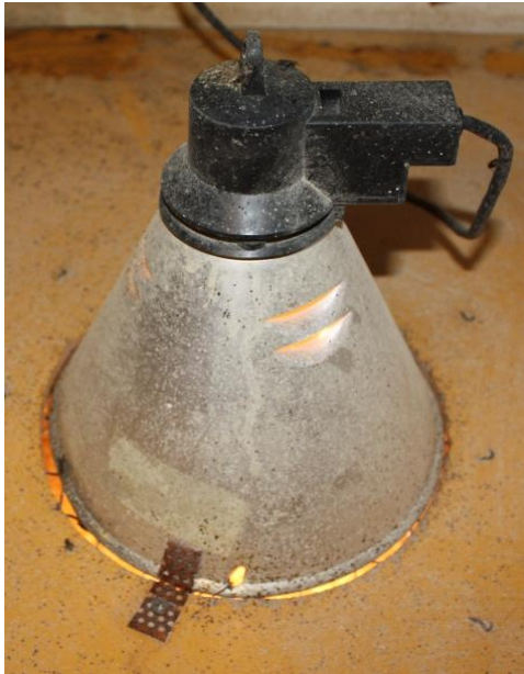
Kuva 2. Lämpölamppu kiinnitettynä ruuvilla porsaspesään.
