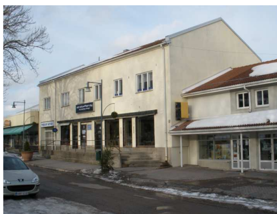
Figur 2. Fotografi av byggnadens fasad
