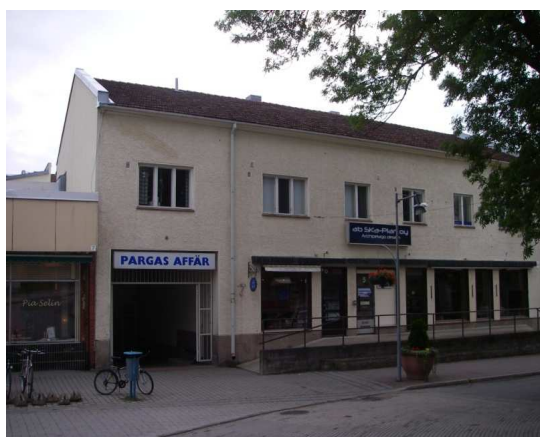
Figur 1. Fotografi av byggnadens fasad
