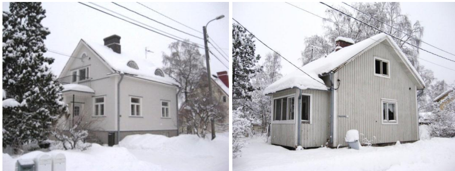
KUVIOT 27 ja 28. Vasemmalla on arvokkaaksi merkitty rakennus vuodelta 1935. Oikealla todennäköisesti autioitunut rakennus, jonka lähes kaikki ikkunat ovat rikki tontilla 4452-5
