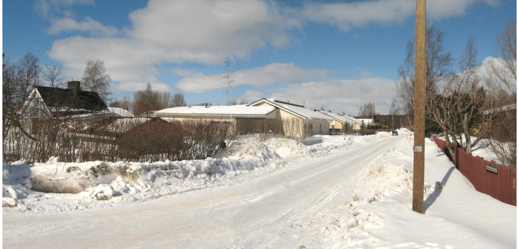
KUVIO 40. Sarvarannankadun alkupää on matalaa ja loivakattoista. Vasemmassa reunassa on vanha rakennus, jonka vieressä uudempaa pientalorakentamista.
