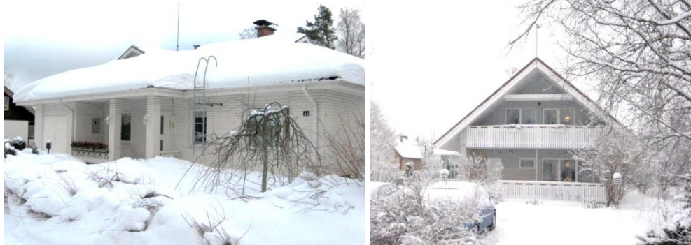
KUVIOT 23 ja 24. Vasemmalla espanjalaistyylinen rakennus, katoksissa ei kuitenkaan ole käytetty kaarevia pilareita. Oikealla alppityylinen omakotitalo
