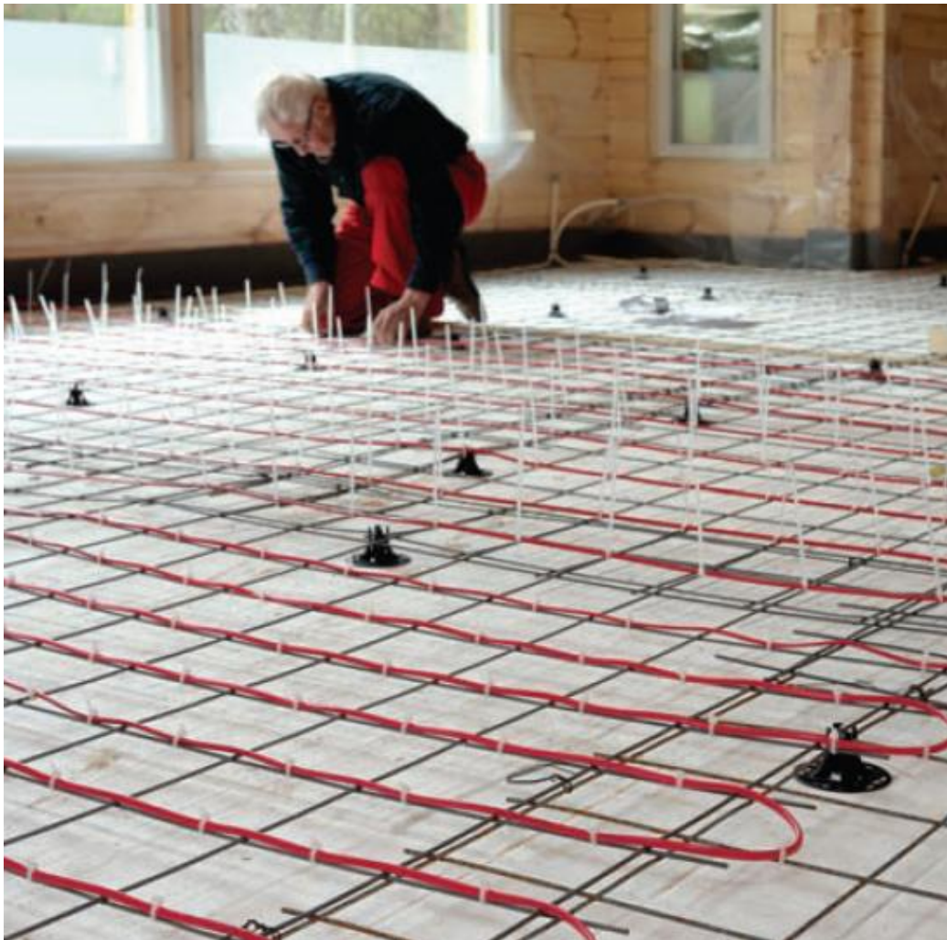
Kuva 2. Sähköisen lattialämmityskaapelin asennus (Ensto)
