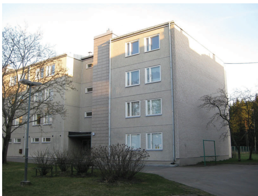
Kuva 19. Hissikuilun sijoittuu rakennukseen huomaamattomasti (As Oy Pormestari 29.4.2009)
