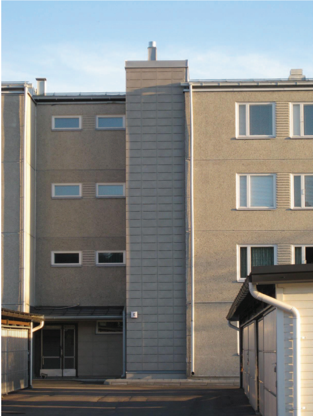
Kuva 13. Kuilun liittyminen rakennukseen (As Oy Pormestari 29.4.2009)
