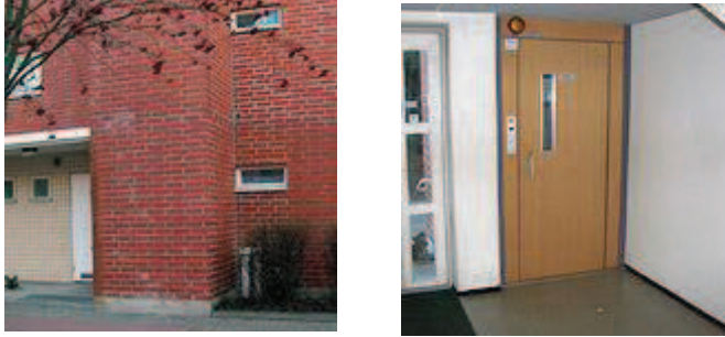
Kuva 5. Betonikuilu (Hissilinja Oy [viitattu 25.4.2009]).
