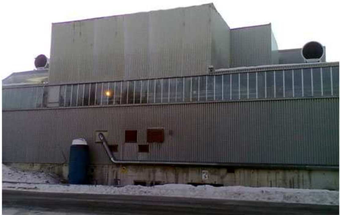
KUVA 2. Lämmöntalteenottojärjestelmät tehtaan katolla
