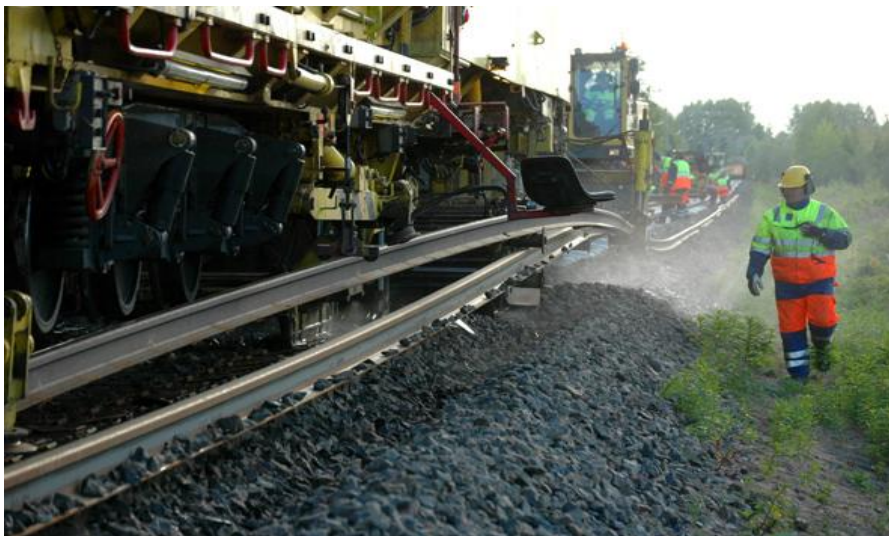
KUVA 6: Kiskonvaihto (Kuva: Leif Rosnell / VR-Yhtymä Oy)
