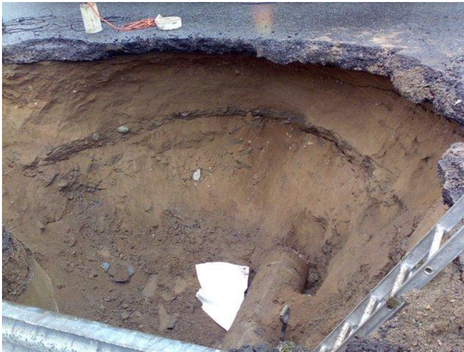
KUVA 1: Sadevesiviemärin vaurion korjaustyöt (Kuva: Heikki Ikonen 2009)
