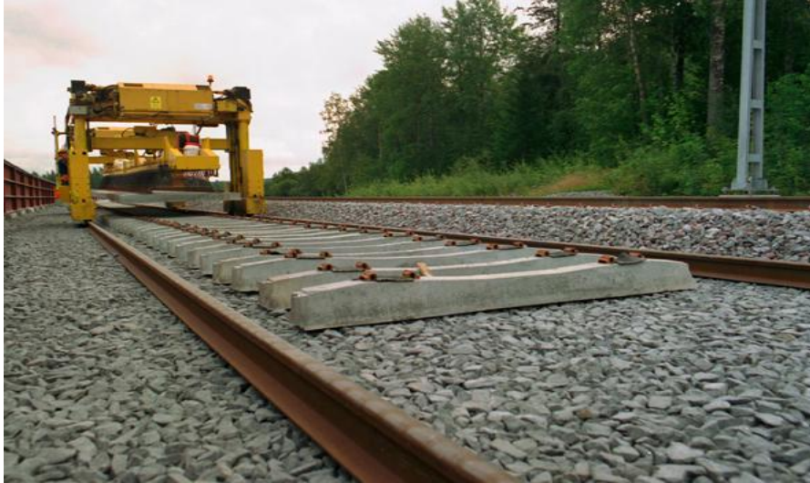
KUVA 5: Ratapölkkyjen vaihto uusiin (Kuva: Leif Rosnell / VR-Yhtymä Oy)
