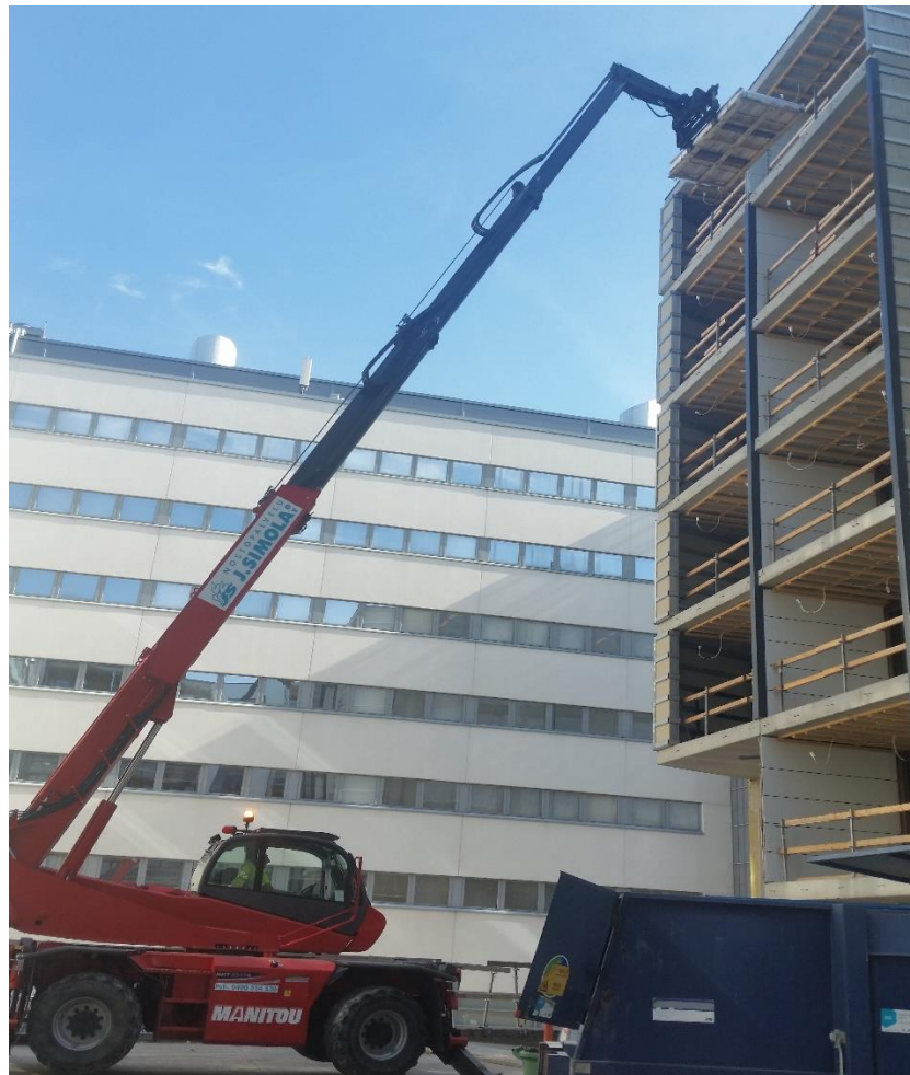
Kuva 15. Levyjen nostoa kurottajalla.
