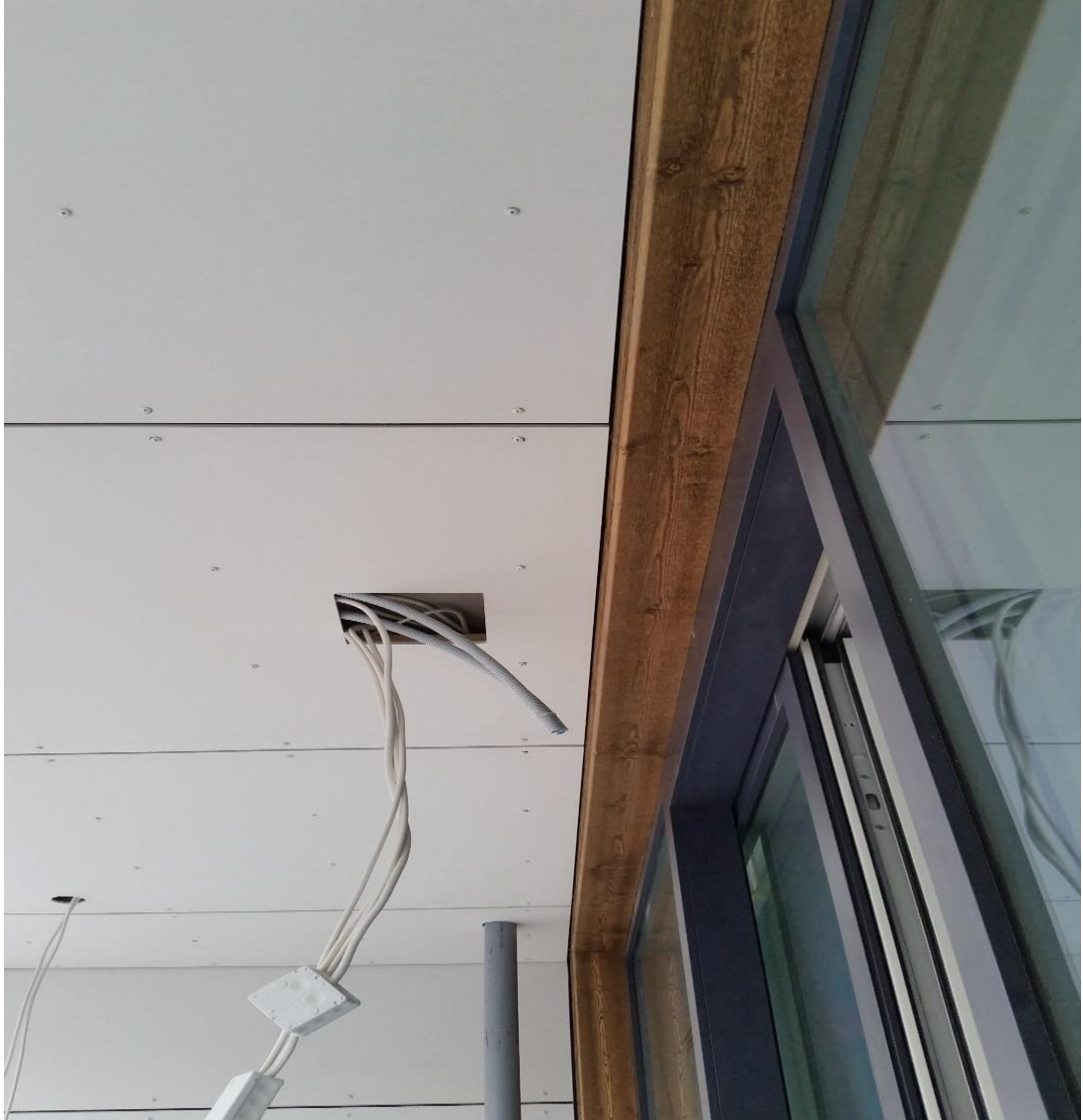
Kuva 17. Kivilevyn ja paneelin yläliittymä.
