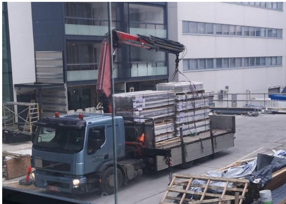
Kuva 14. Kuorman purku sisäpihalle.
