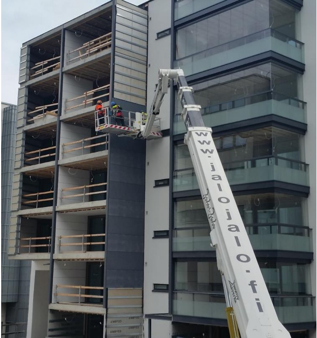
Kuva 16. Levyasennusta nostolava-auton avulla.
