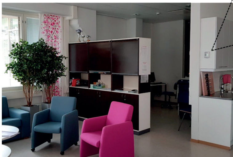
Kuva 2. Huonetilaan asennettu \text{CO}_2 -mittaus (Korpela 2019)
