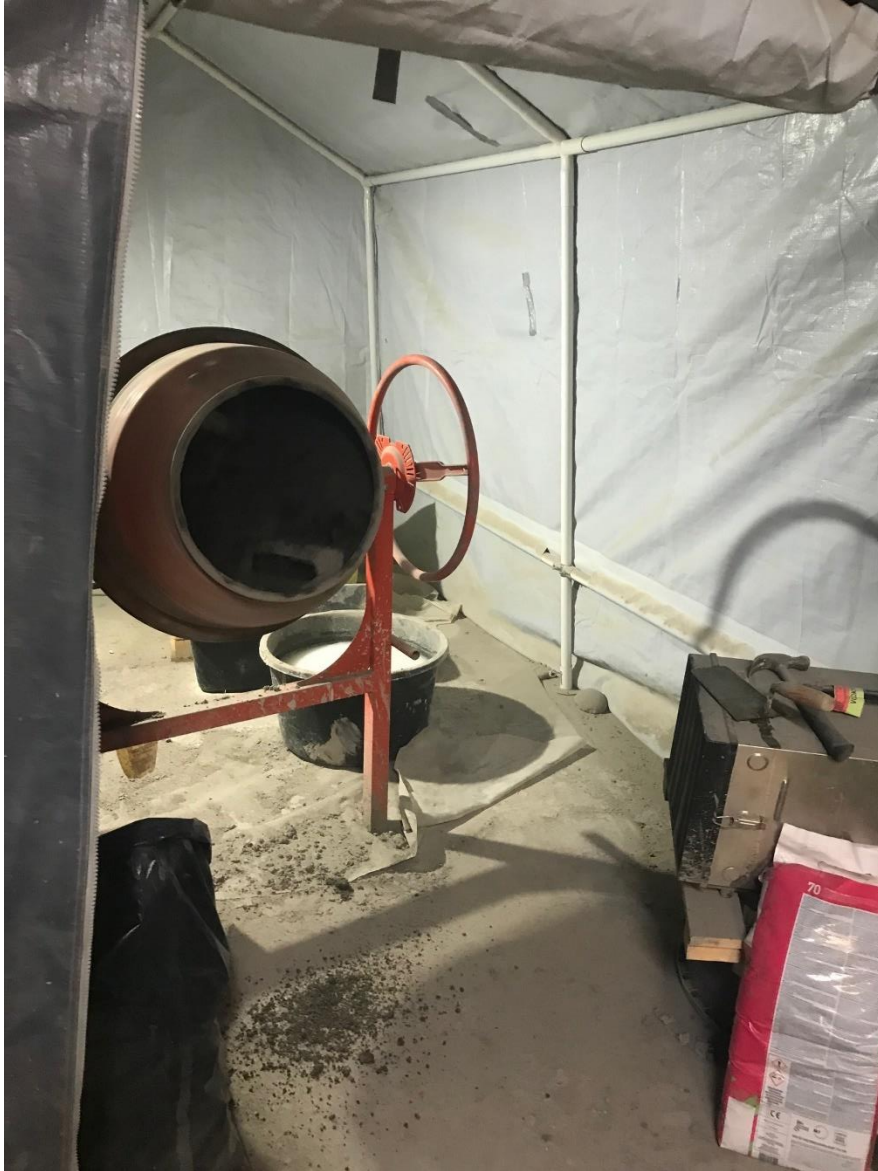
Kuva 4. Laastin sekoittamista varten kasattu pressutelttä. Oikeassa reunassa näkyvällä alipainekoneella hoidetaan pölyntorjuntatoimenpiteet. Telttaa voisi tarvittaessa hyödyntää muissakin, kuin vain muurauslaastin sekoittamista vaativissa töissä.
