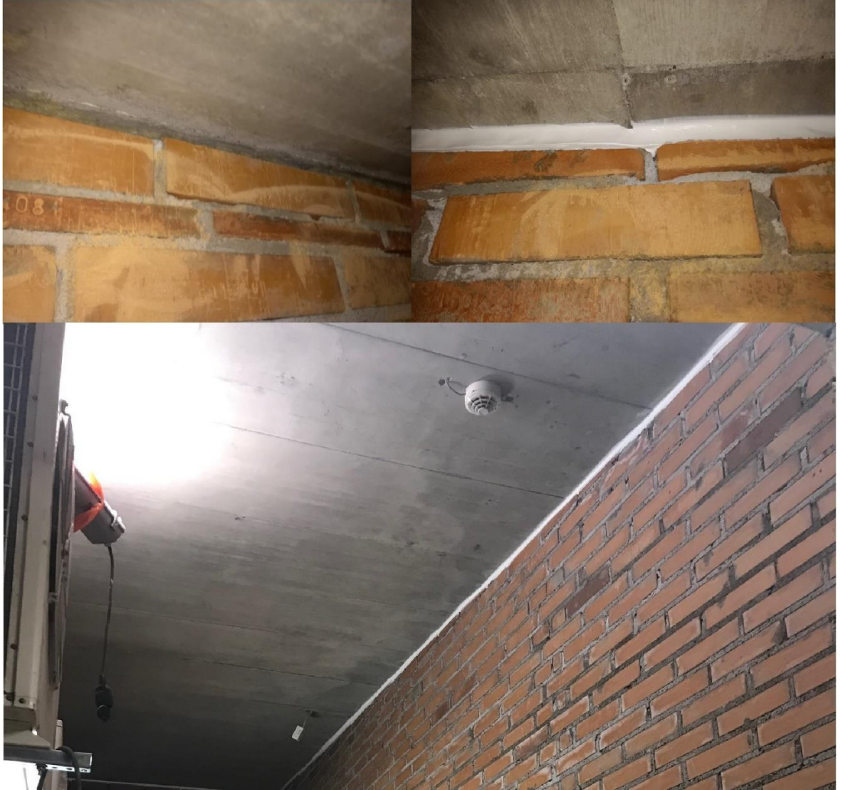
Kuva 11. Tiilen yläpään palokatko palovillalla ja -kitillä.
