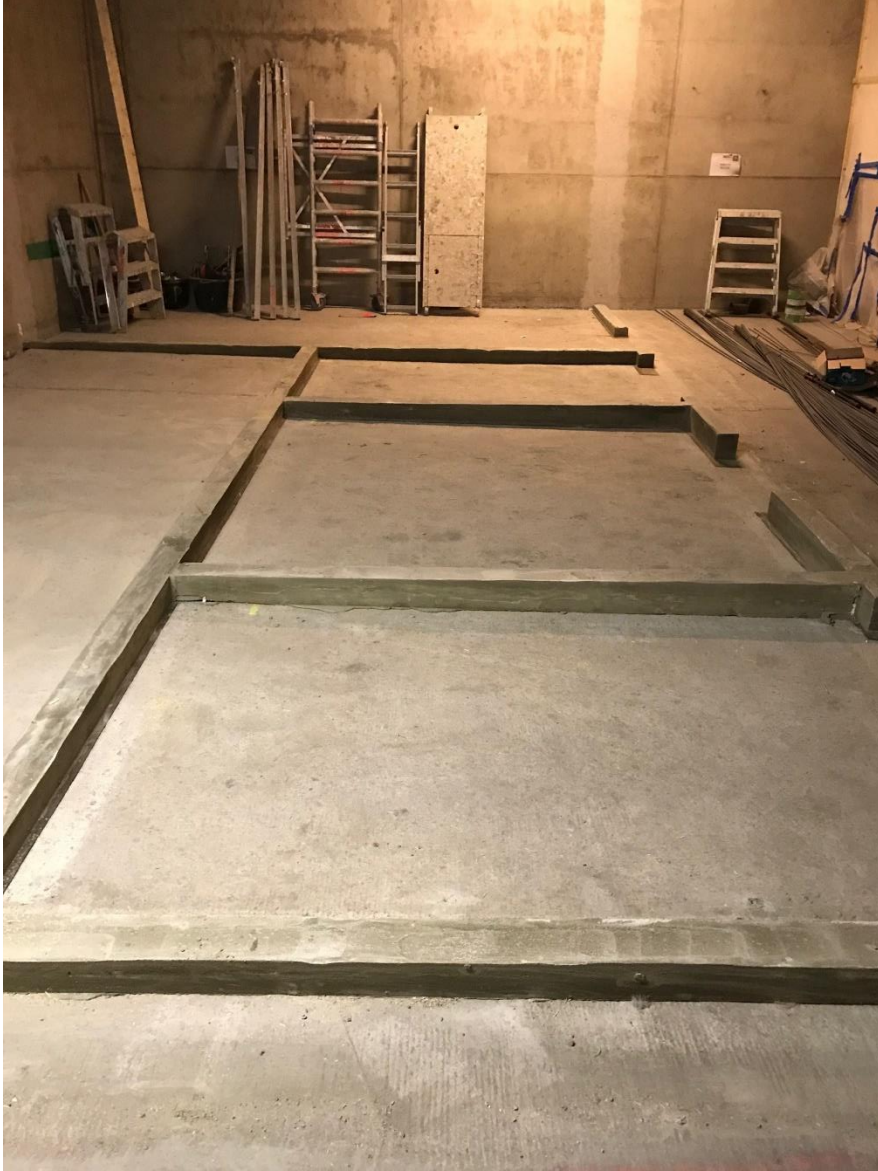
Kuva 7. Valettu sokkeli. Kuvasta näkyy sokkelin korkeuserot etu- ja takareunan välillä.
