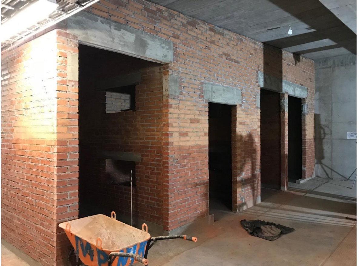
Kuva 10. Valmiiksi muuratut muuntamo- ja sähkötilat.
