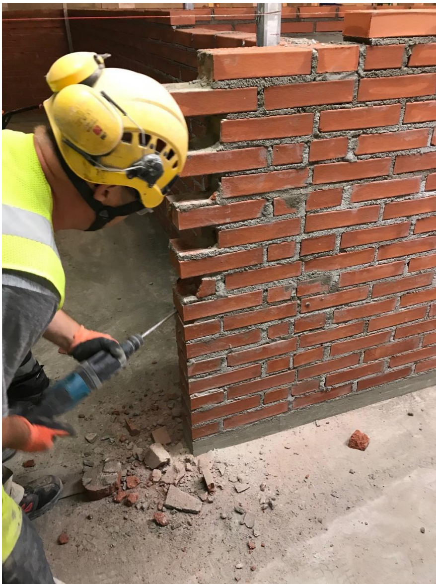
Kuva 12. Oviaukon muutostyö. Ovipielestä poistettiin piikkaamalla joka toisesta tiilivarvasta tiiliä pois, jotta pielen jatkaminen muuraamalla onnistuisi helpommin.
