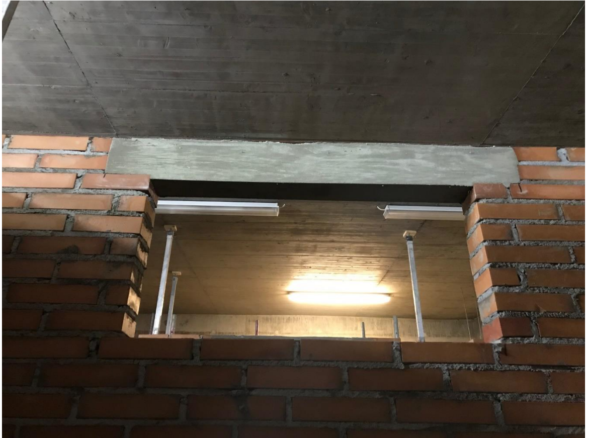
Kuva 9. Ensimmäinen aukon ylityspalkki. Muut aukkojen ylitykset toteutettiin vastaavalla tavalla.
