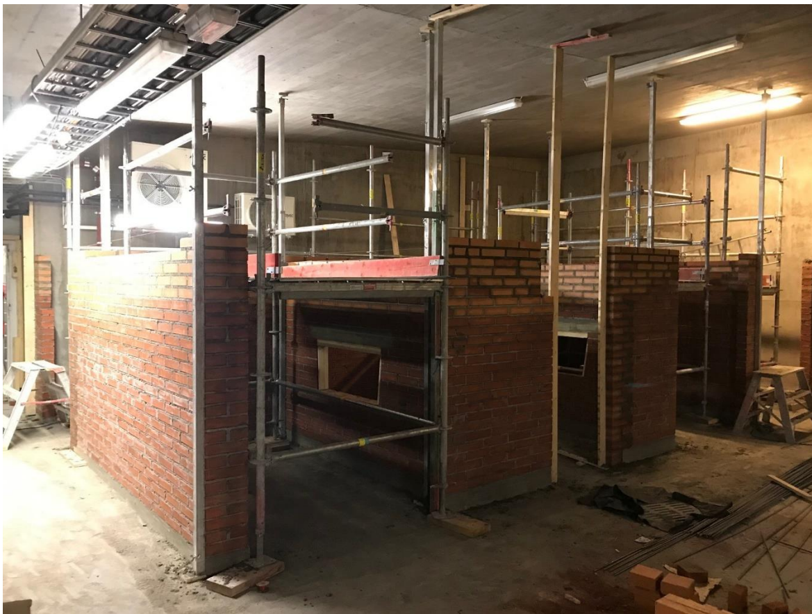
Kuva 14. Muuraustelineiden asennusta. Telineet päätettiin asentaa huoneiden sisälle. Tämä mahdollisti muuraustyön etenemisen huonekohtaisesti joka seinällä.
