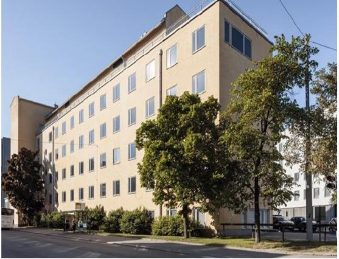
Kuva 1. Haartmaninkatu 1, kohde ennen työmaan aloittamista.
