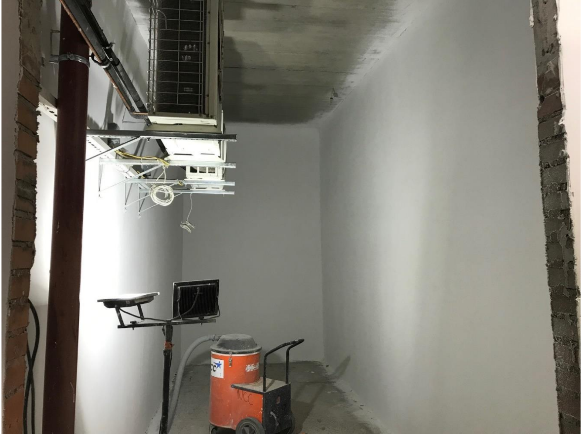
Kuva 15. Seinien tasoitus- ja pohjamaalaus työt käynnissä.
