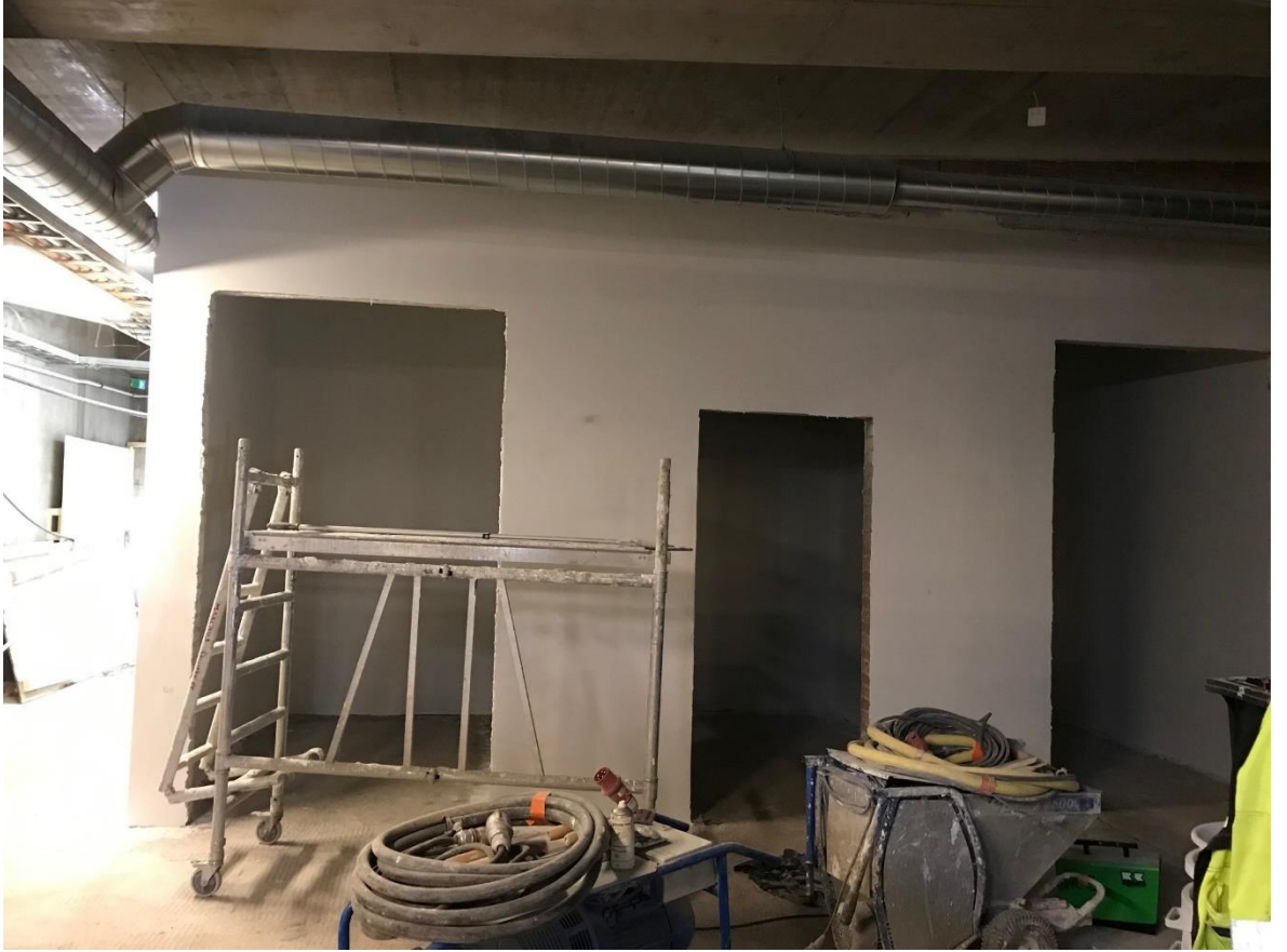
Kuva 16. Seinät tasoitettuna ja maalattuna.
