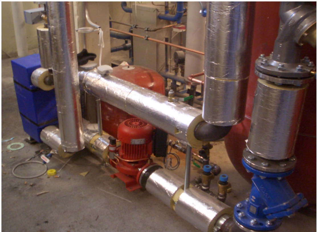
Kuva 1. Lämmönjakohuoneen kaukolämpöasennukset, joissa eristystyöt vielä kesken.
