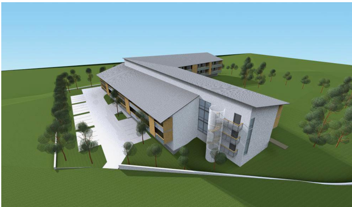
Kuva 1: Minttupuisto -rakennus (Ukonlinna 2009)
