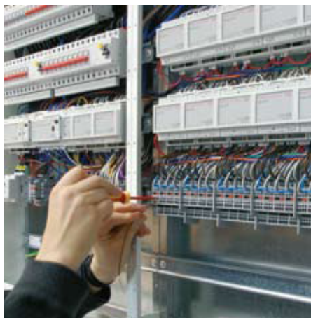
KUVIO 2. IHC-komponentit keskuksen DIN-kiskossa (Elko tuoteluettelo, 2009, 64).
