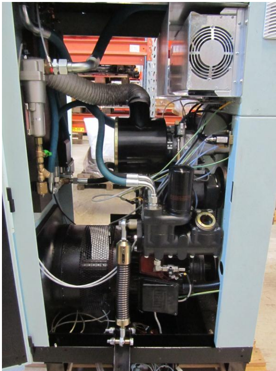
KUVA 1. Kompressorikaapin alkuperäinen rakenne sivusta
