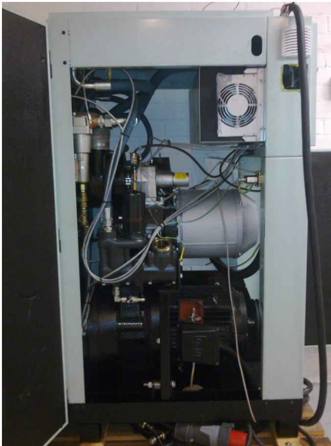
KUVA 11. Kompressorikaappi muutostyön jälkeen
