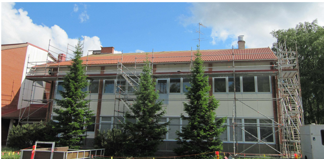
Kuva 3. Telineet kiersivät koko rakennuksen ympäri.
