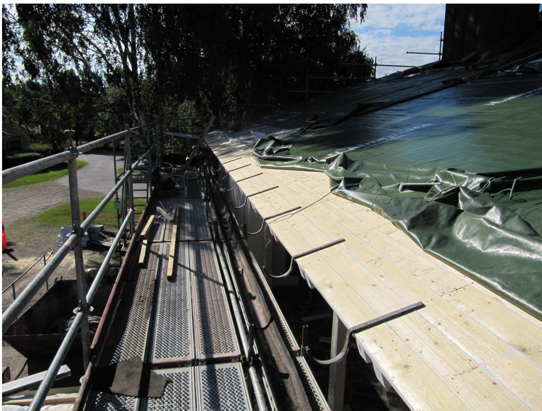
Kuva 2. Sääsuojausta 6 m x 9 m suojapeitteillä
