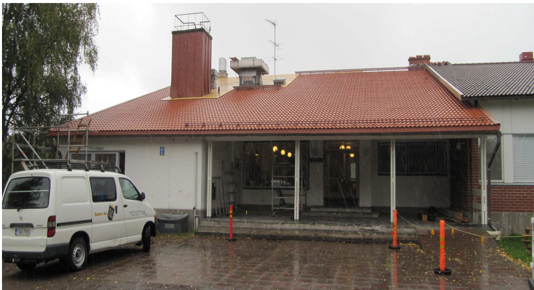
Kuva 7. Lumieste asennettiin pääsisäänkäynnin kohdalle
