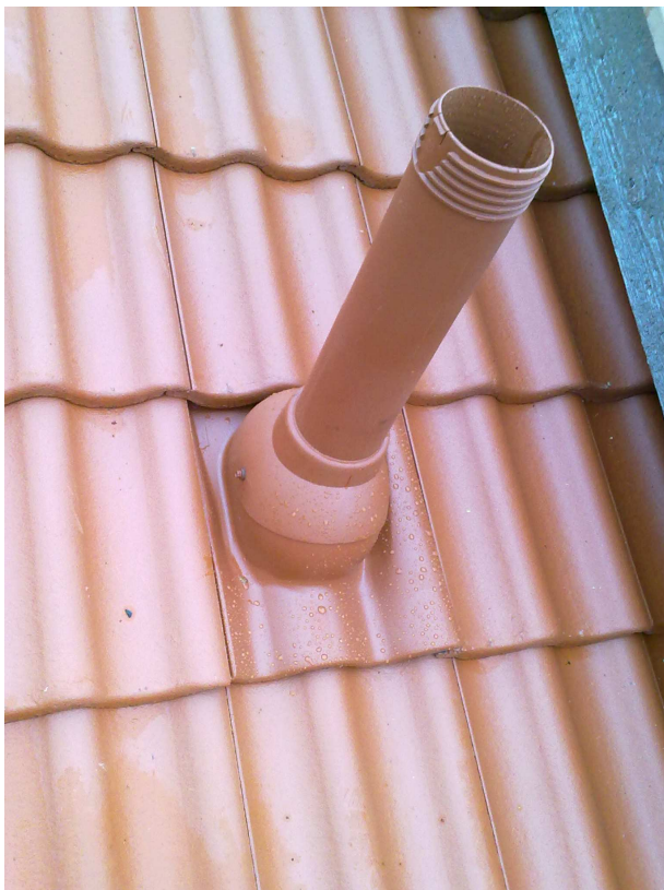
Kuva 10. Lämpivienti ilman putken hattua
