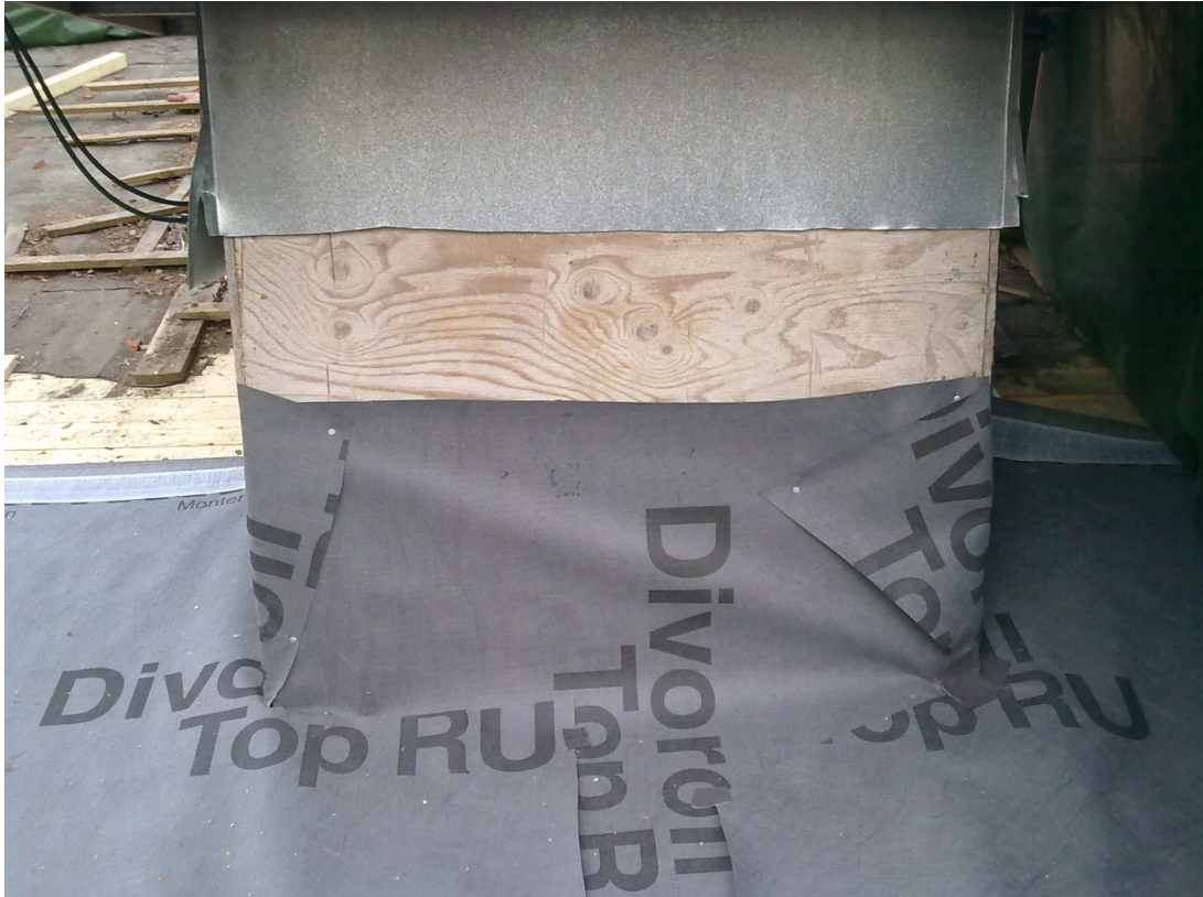
Kuva 9. Saumat taitettiin, jonka jälkeen tiivistettiin liimanauhalla
