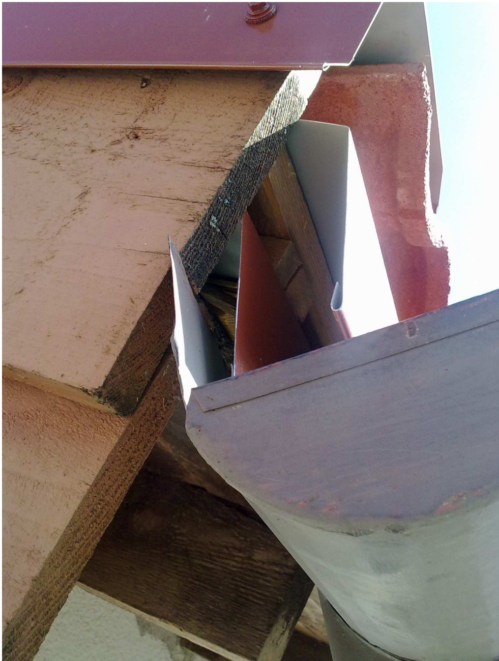
Kuva 4. Räystäään tuuletusratkaisu
