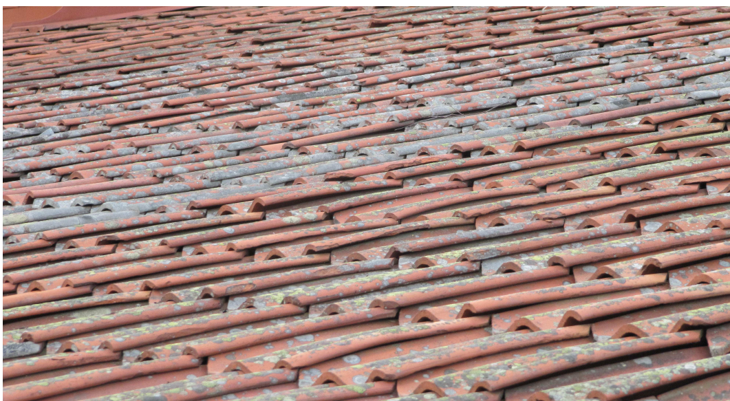
Kuva 1. Savitiilikate oli hapertunut ja osittain painunut alapuolisten rakenteiden lahoamisen vuoksi
