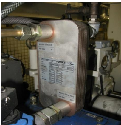
Kuva 11. Levylämmönsiirrin eli jäähdytin
