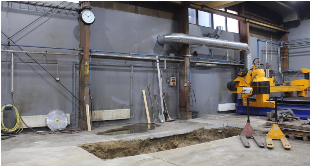
KUVA 22. Pölynpoistolaitte siirrettiin pois tuotantotiloista. Lattiaan tehtiin syvennys uutta Alikon särmäyspuristinta varten. (Samuli Sahi, 2020)
