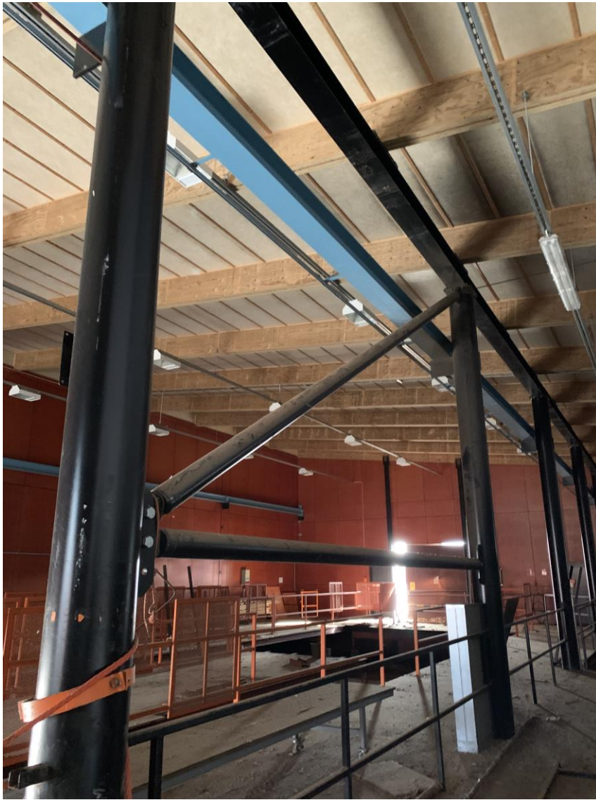
Kuva 11 Liittopilarirunko ja sivuttaistuet nurjautamisen estämiseksi. (Eelis Mahlio 2020)
