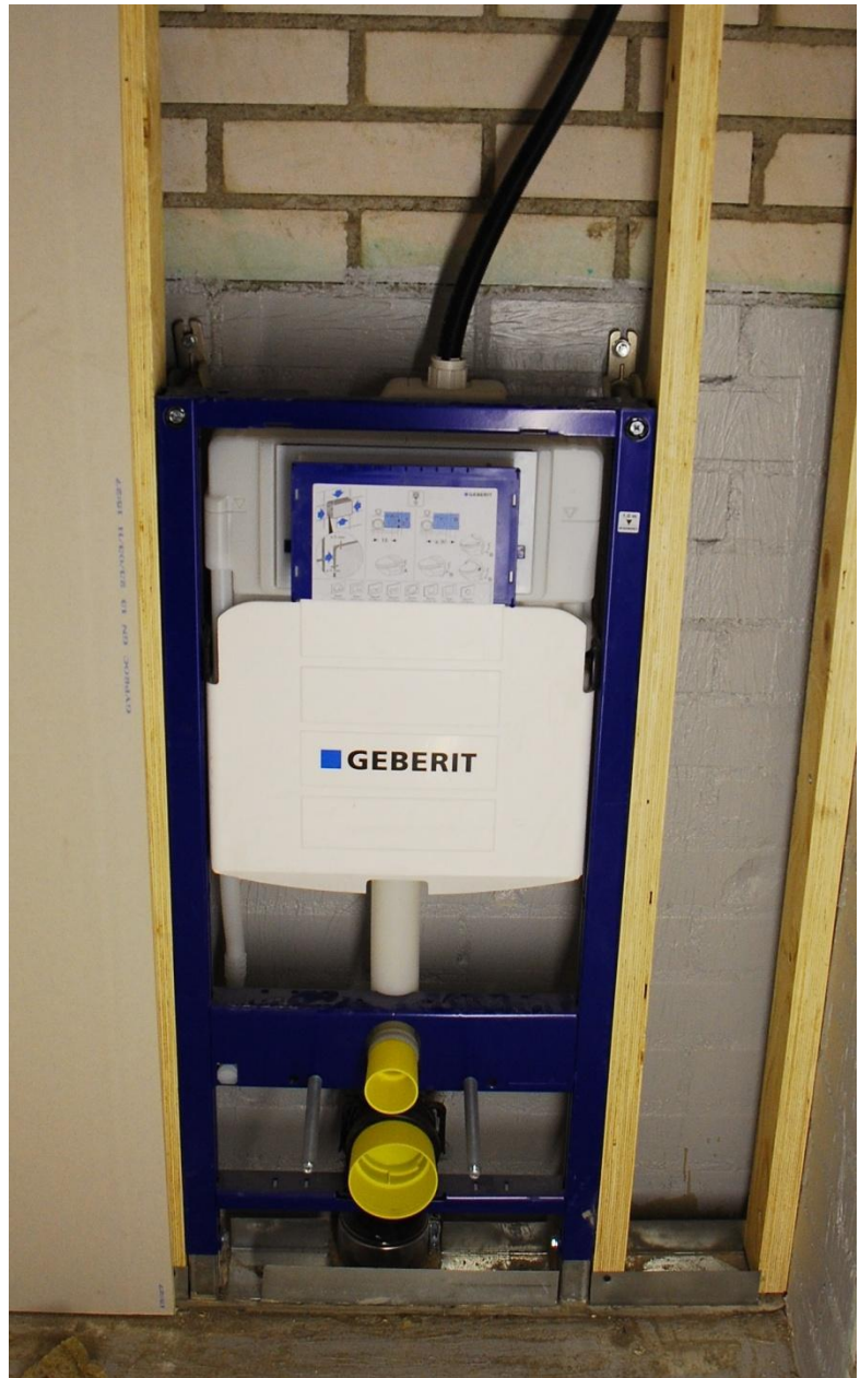
Kuva 4. Esimerkki tukevasti kannakoidusta telineestä
