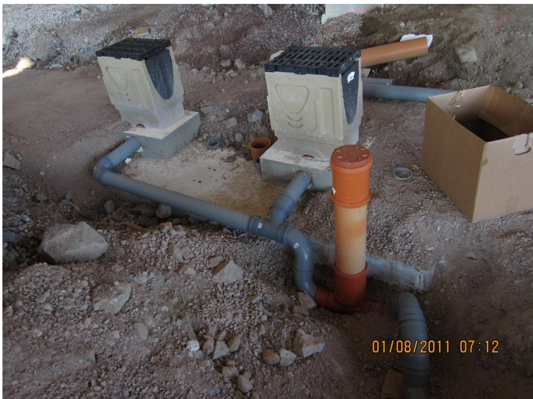
Kuva 3. Viemäriosilla toteutettu vesilukko ja puhdistusyhte
