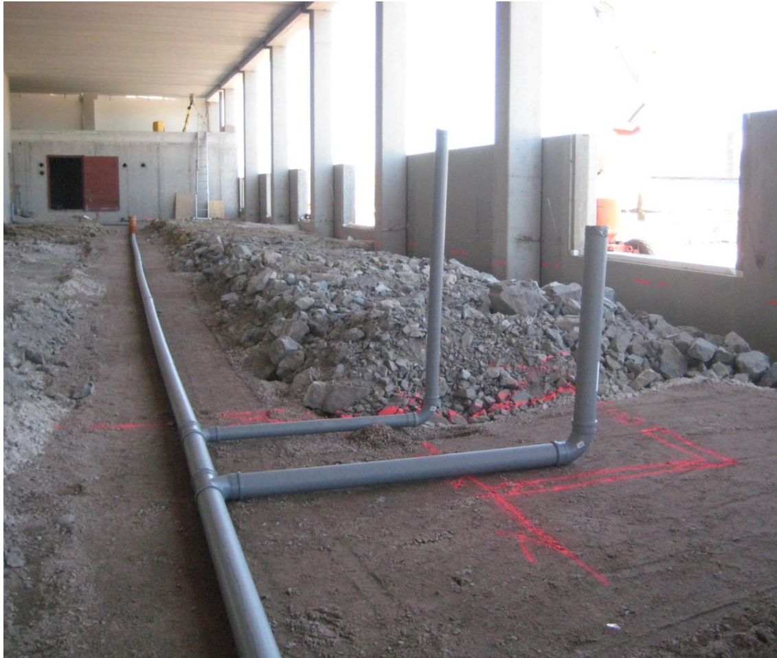
Kuva 1. Maanvaraisen pohjaviemäriin tuenta ja sijainti
