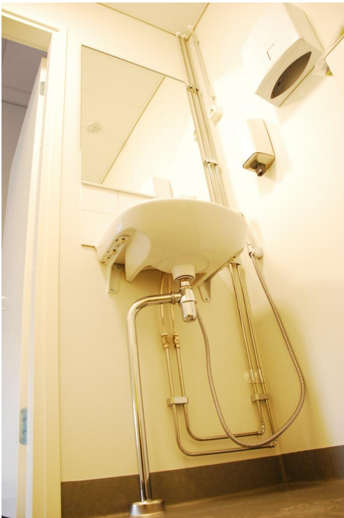
Kuva 2. Vessan kalustuksen tarkastus
