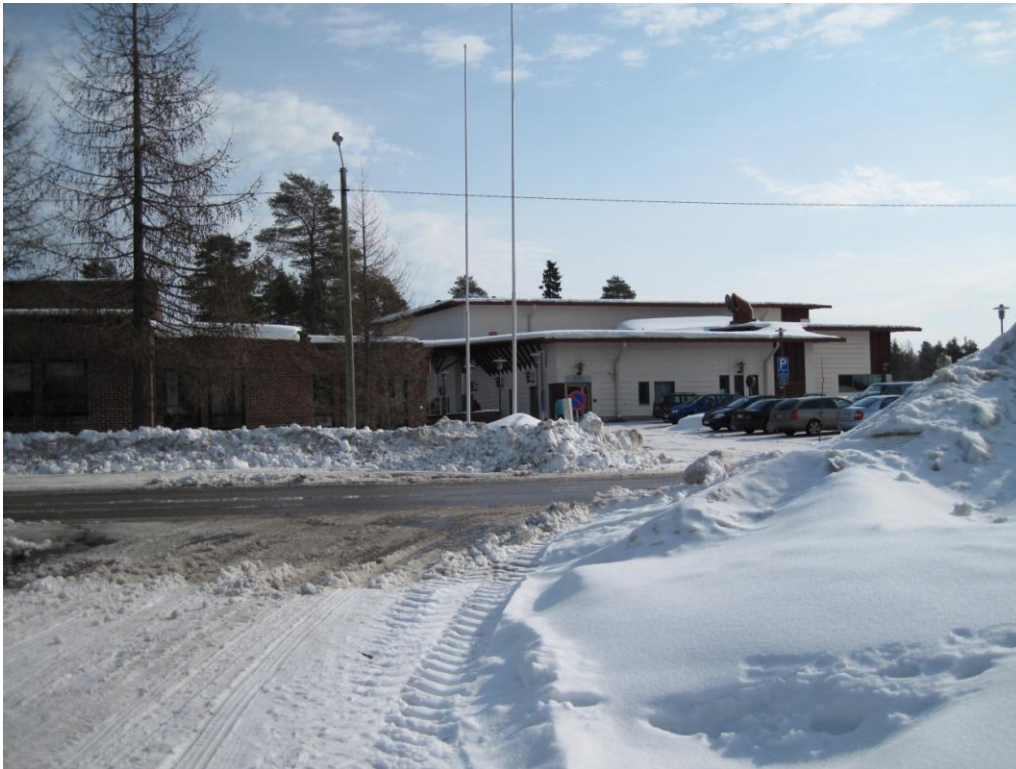
KUVA 16. Pysäköintialueelta puutteellinen yhteys kohteeseen Tuulimyllyntiellä
