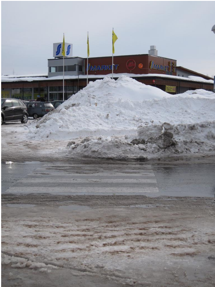
KUVA 13. Suojatien päässä auraamaton kinos
