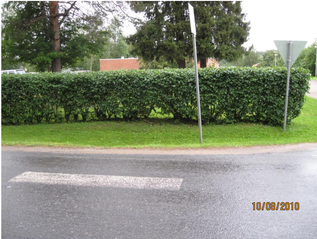
KUVA 22. Suojatie johtaa kohti pensasaitaa ja maalaukset ovat kuluneet
