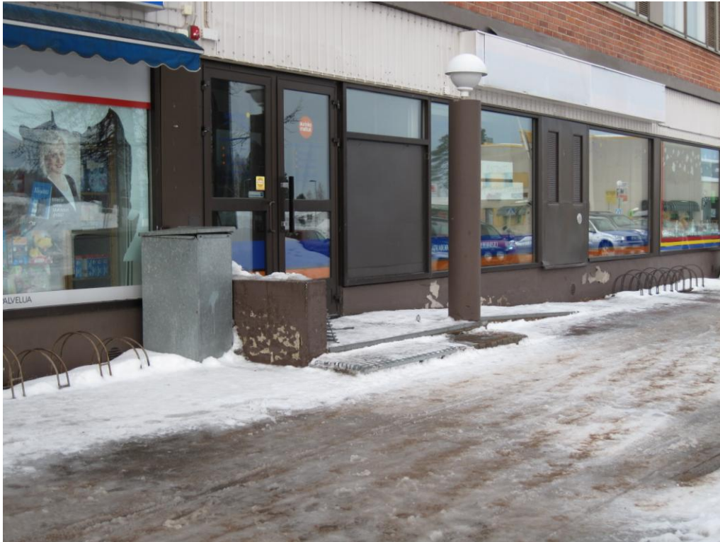
KUVA 11. Käsijohteet puuttuvat ja kunnossapito on puutteellinen
