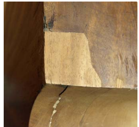
Kuva 24. Valmis viilukorjaus (Artoma 2011).
