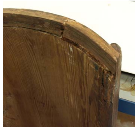
Kuva 31. Valmis korjaus (Artoma 2011).
