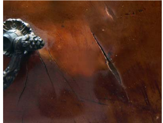
Kuva 16. viilutukseen muodostunut kupru (Artoma 2011).
