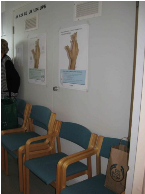
Kuva 4. Sähkökaapin edessä säilytetään tuoleja
