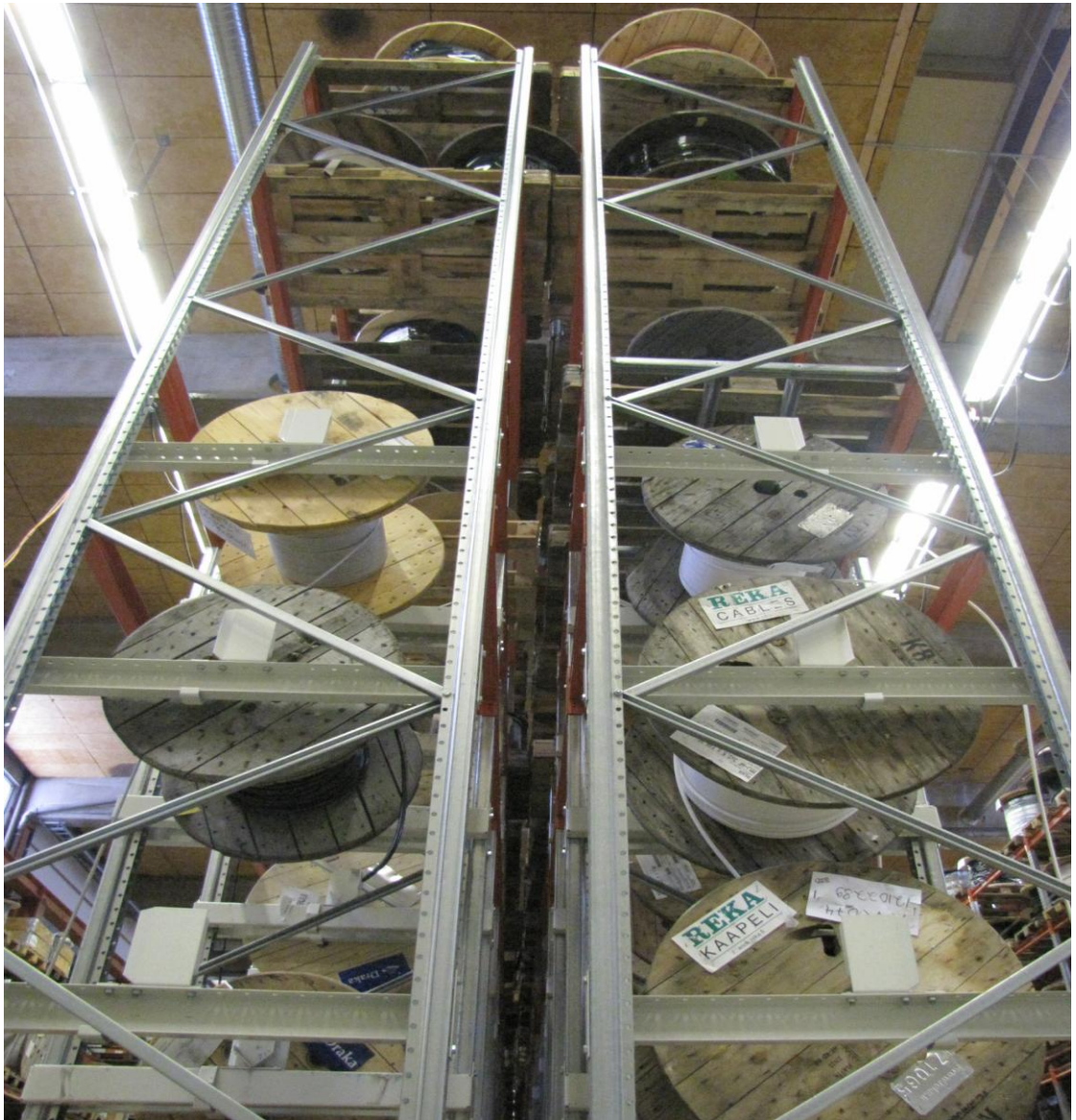
Kuva 7. Vaaratilanne kaapelihallissa. Kela on kahden lavan päällä noin 5 metrin korkeudessa.
