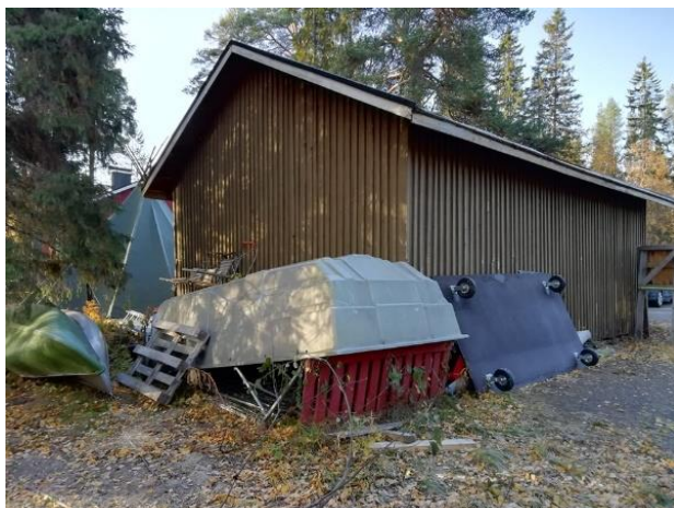
KUVA 3. Varastorakennus takaa (Kokko 2019-10-03).
