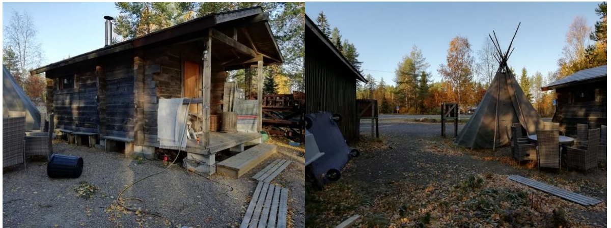
KUVAT 1 JA 2. Syksyllä 2019 otetut kuvat saunarakennuksesta ja sen pihakalusteiden näkösuojana toimivasta kodasta (Kokko 2019-10-03).
