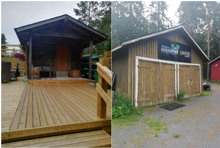
KUVA 9 JA 10. Saunan ilme edestä uuden terassin rakennuksen jälkeen. Oikealla varastorakennuksen etuseinään asennettu mainoskyltti. (Kokko 2020-08-12)
