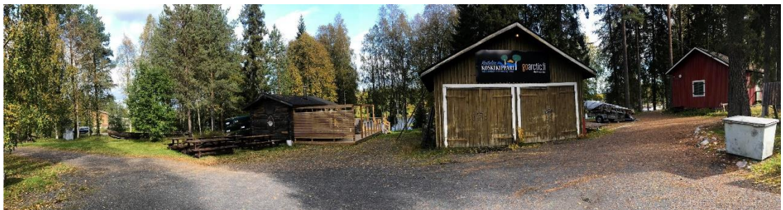
KUVA 6. Panoraama-kuva koko alueesta tien puolelta. Ajotie, sauna, varistorakennus ja kokouskämppä (Toppi 2020-09-17).
