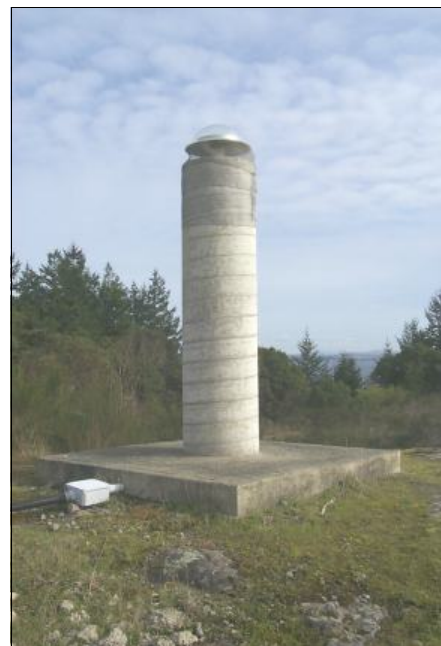
Kuva 22. WCDA-verkon betonipilari (Schmidt ym. 2000).
