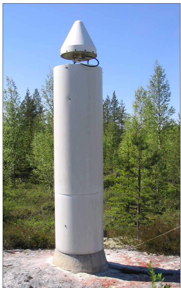
Kuva 4. Romuvaaran GPS-aseman betonipilari (kuva: Koivula).
