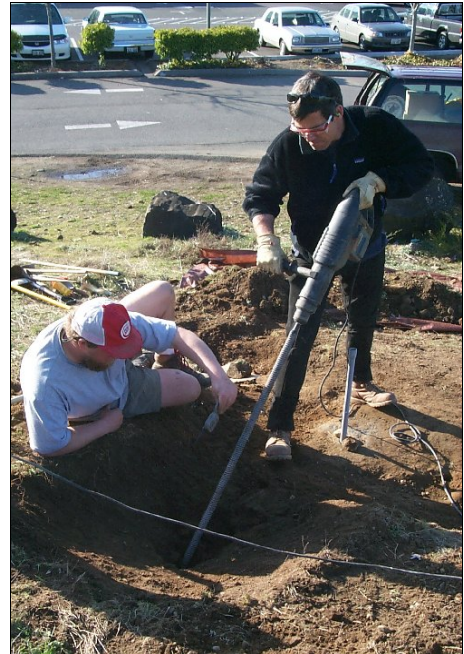
Kuva 20. Reikien porausta (UNAVCO 2009).
