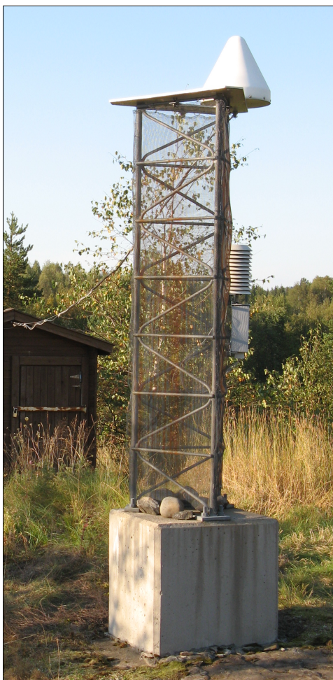
Kuva 3. Joensuun GPS-aseman teräsristikkomasto (kuva: Koivula).
