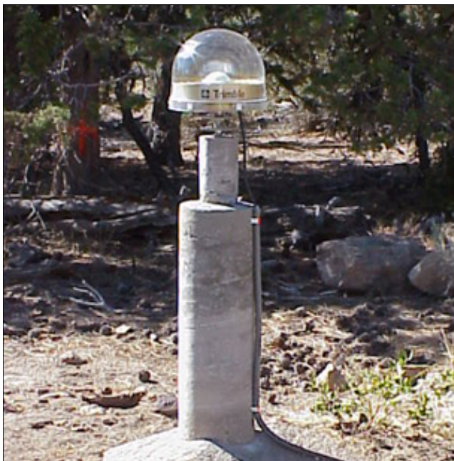
Kuva 21. UNAVCON rakentama betonipilari (UNAVCO Facility).
