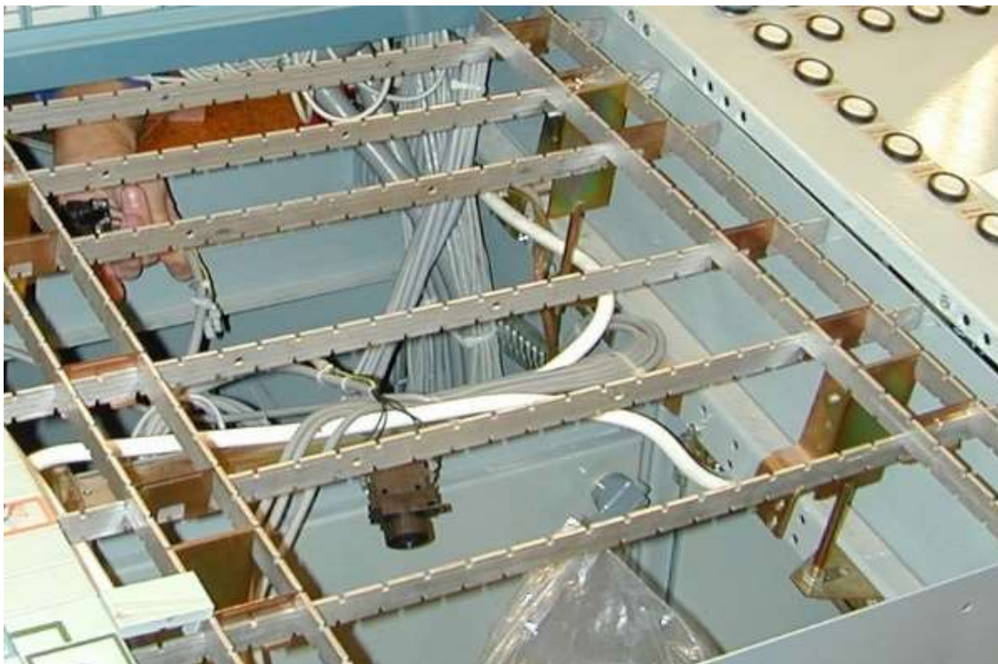
Valokuva 1. Asea mosaiikkirungon rakentelua
