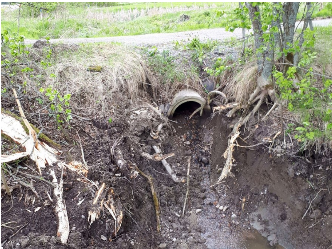
Kuva 7. Y15 tien vanhan rummun alapää ojan perkauksen jälkeen.
