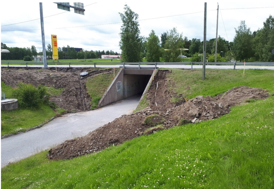
Kuva 22. Alikulku ennen jatkamista Yläneen suunnasta.
