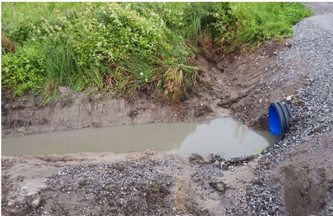
Kuva 8. Y15 tien uuden rummun yläpää vaihdon jälkeen.
