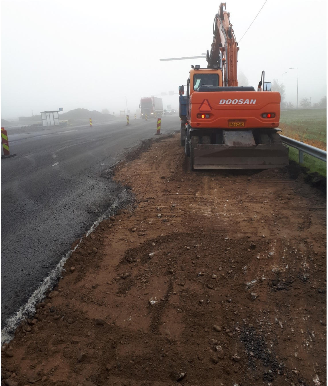
Kuva 34. Ohut asfalttikerros ja murske on poistettu.
