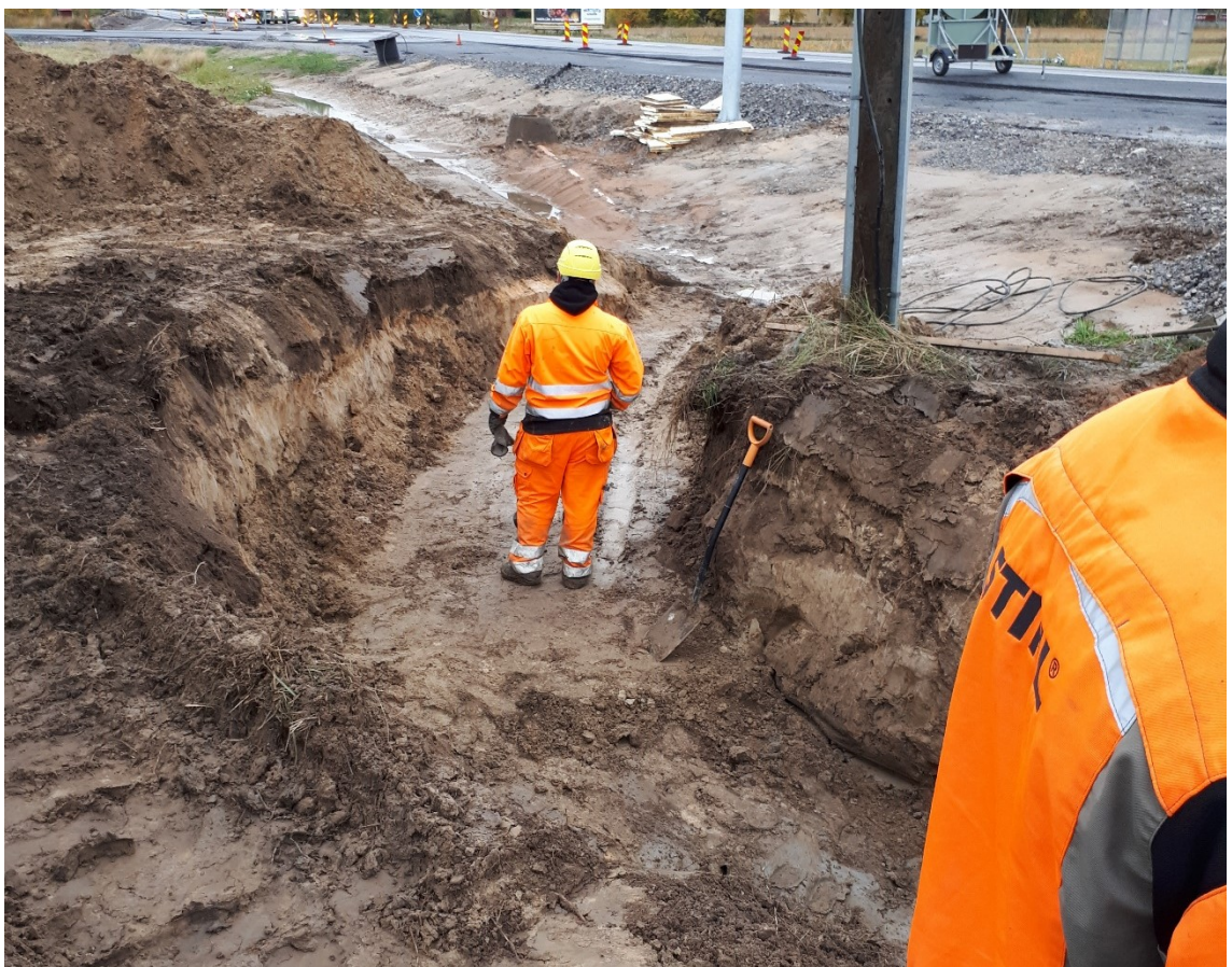
Kuva 25. Uuden purkuputken linja.
