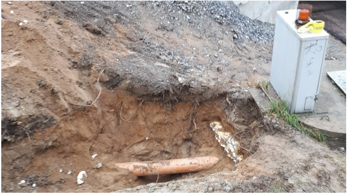
Kuva 24. Pumppaamon vanha purkuputki.
