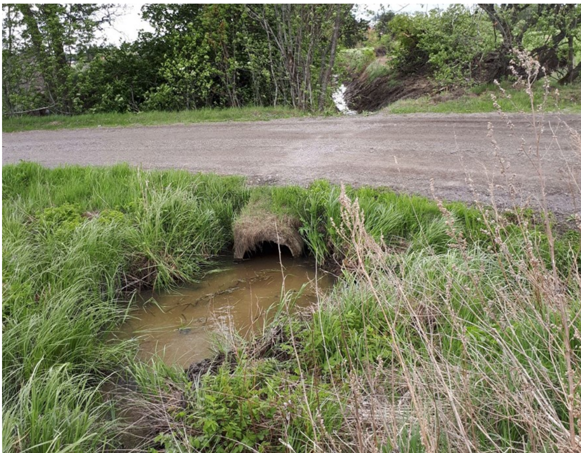
Kuva 6. Y15 tien vanhan rummun yläpää ennen korjausta.
