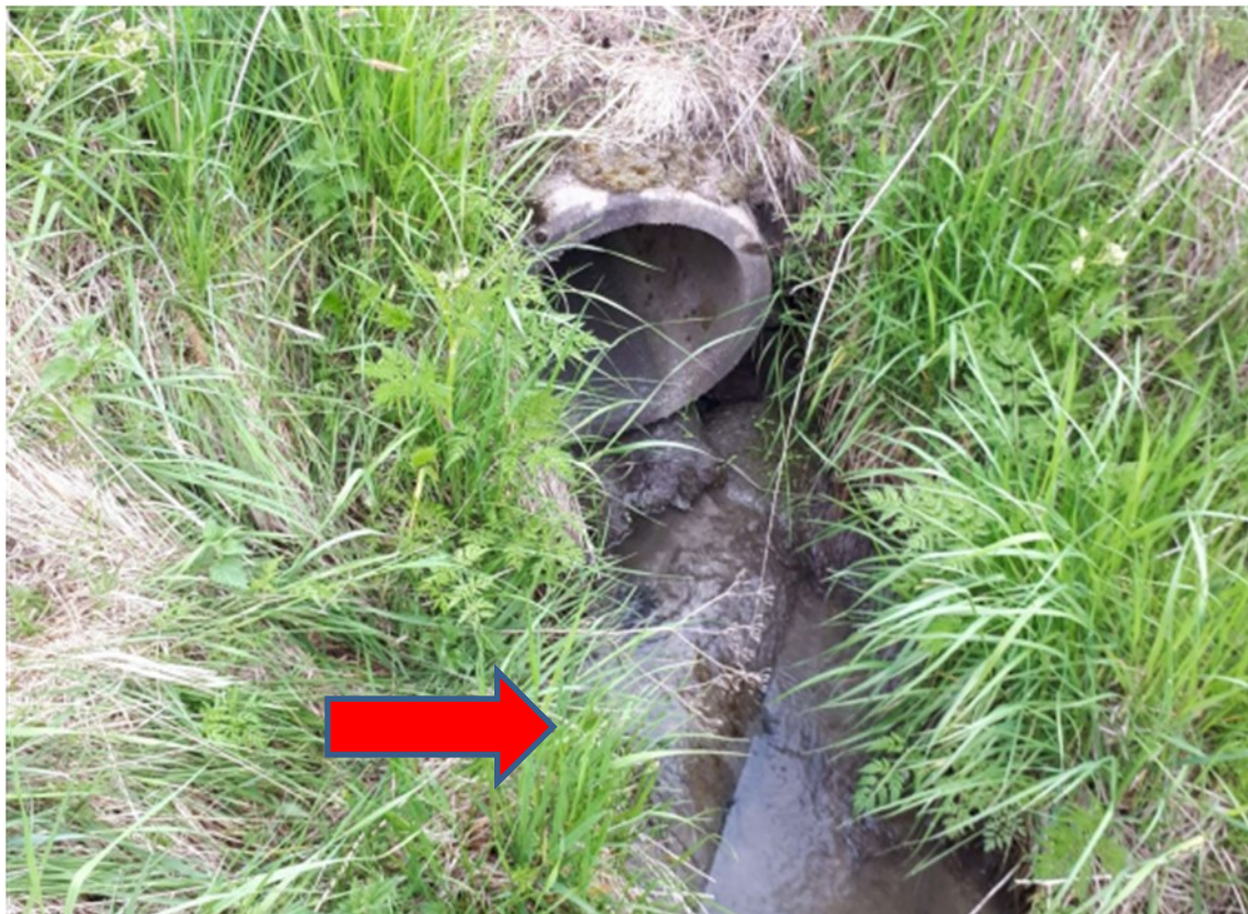
Kuva 11. Maatalousliittymän alapäässä näkyvä kunnan jätevesiviemäriin selkä.
