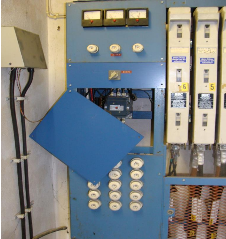
Kuva 2. Kiinteistömuuntamon katuvalokeskus
