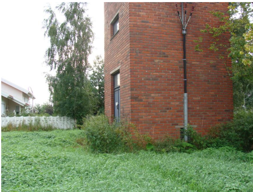
Kuva 3. Tiilimuuntamo
