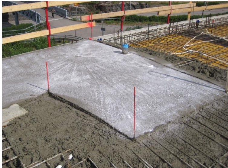
Kuva 6 Kaatolattiat voidaan rajata käsin kulmatappien mukaan
