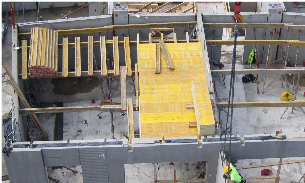
Kuva 1 Holvimuotti kootaan tilakohtaisesti
