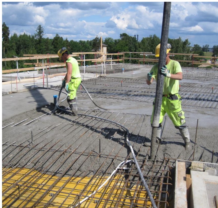
Kuva 7 Rakennebetonia käytetään holvin täyttöön
