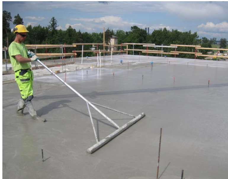
Kuva 8 Valupinta tasataan esimerkiksi varrellisella putkilinjarilla.
