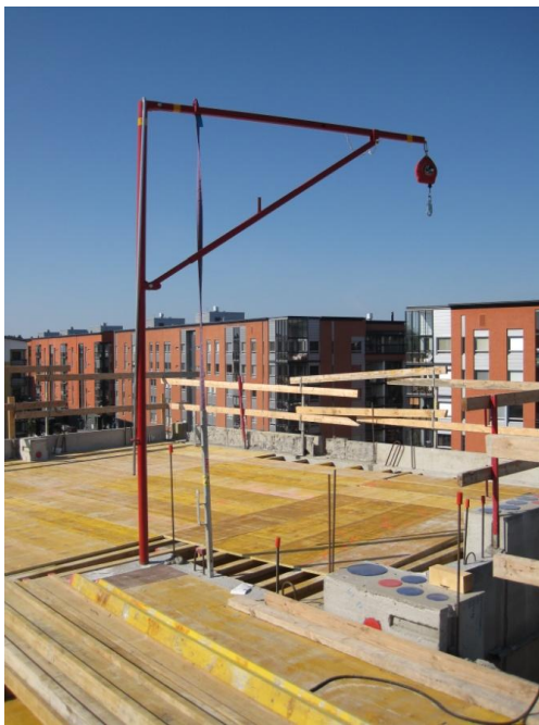
Kuva 14 Taivaskoukku kiinnitetään väliseinäelementin valmiiseen varaukseen.
