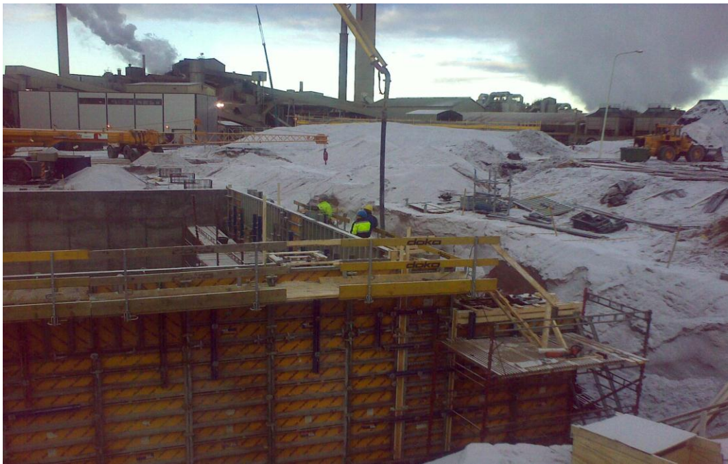
Kuva 4. Kantavan seinän betonointi on käynnissä. Kasettimuotti, lankalämmitys, K30 lämpöluokan nosto +30 °C, ulkolämpötila -2 °C.
