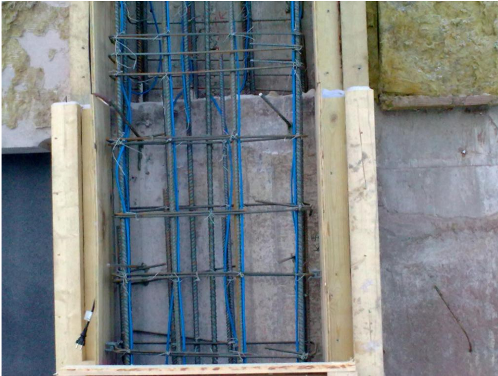
Kuva 5. Satakunnan keskussairaalan vanhan teräsbetonipilarin vahvistuksen lämmitys on toteutettu lämmityskaapelilla.
