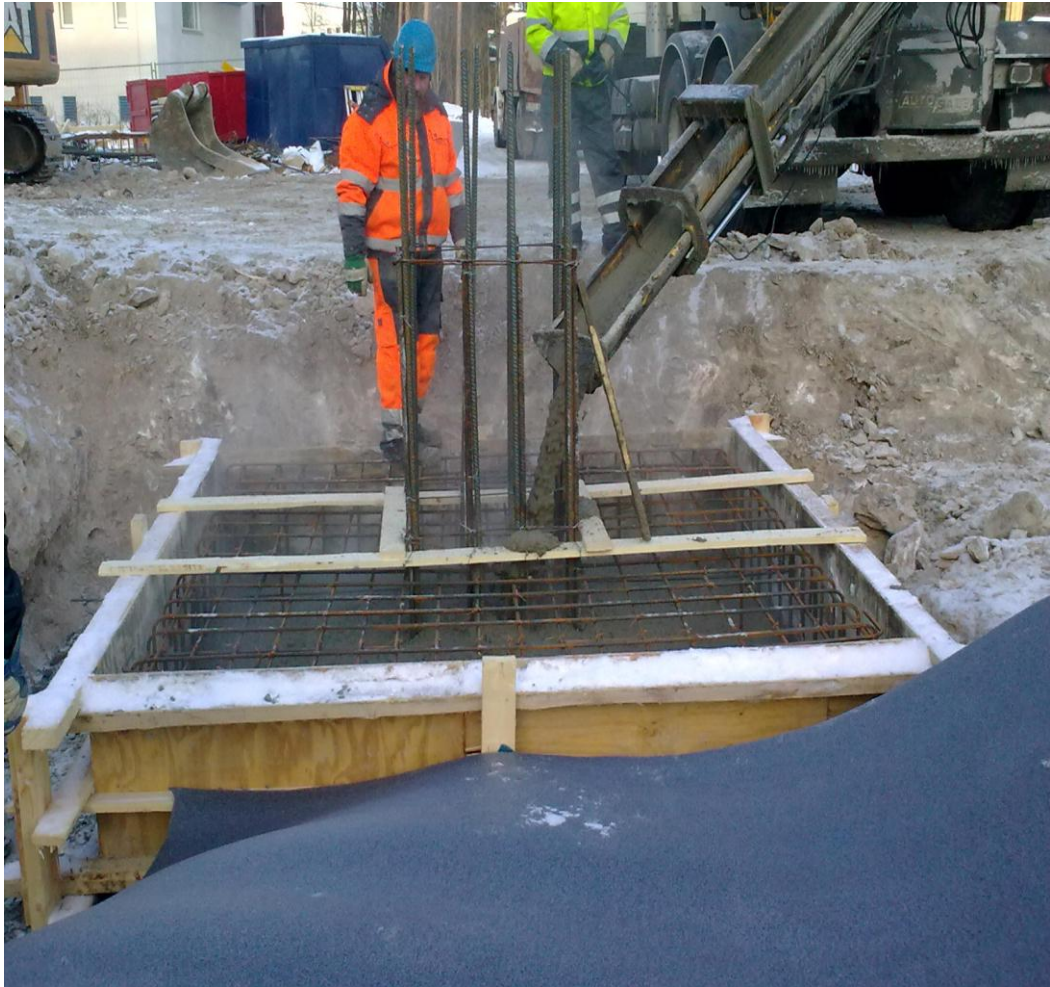
Kuva 3. Satakunnan keskussairaalan työmaalla anturoiden valussa käytettiin lämpöluokan nostoa. Betoni K35 rapid, massan lämpötila +30 °C, ulkolämpötila -20 °C.
