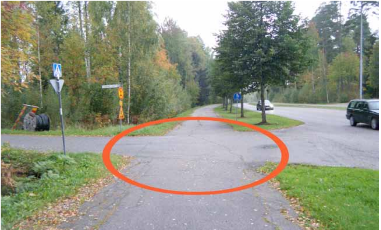
Kuva 57. Pyörätien jatke puuttuu.
