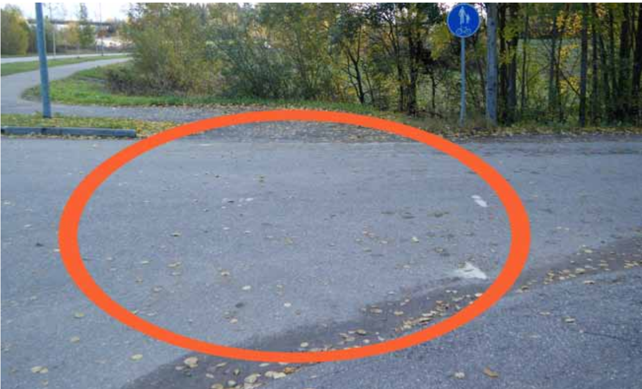
Kuva 152. Pyörätien jatke puuttuu.
