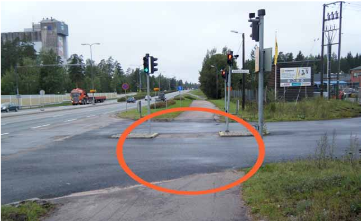
Kuva 22. Pyörätien jatke puuttuu.
