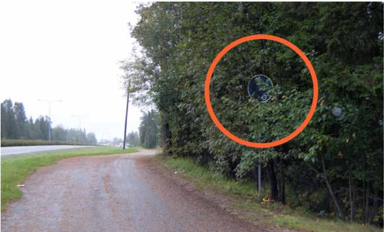
Kuva 26. Kasvillisuus peittää yhdistetyn kevyenliikenteenväylän liikennemerkkin.
