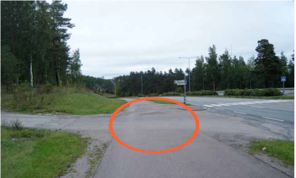
Kuva 21. Pyörätien jatke puuttuu.
