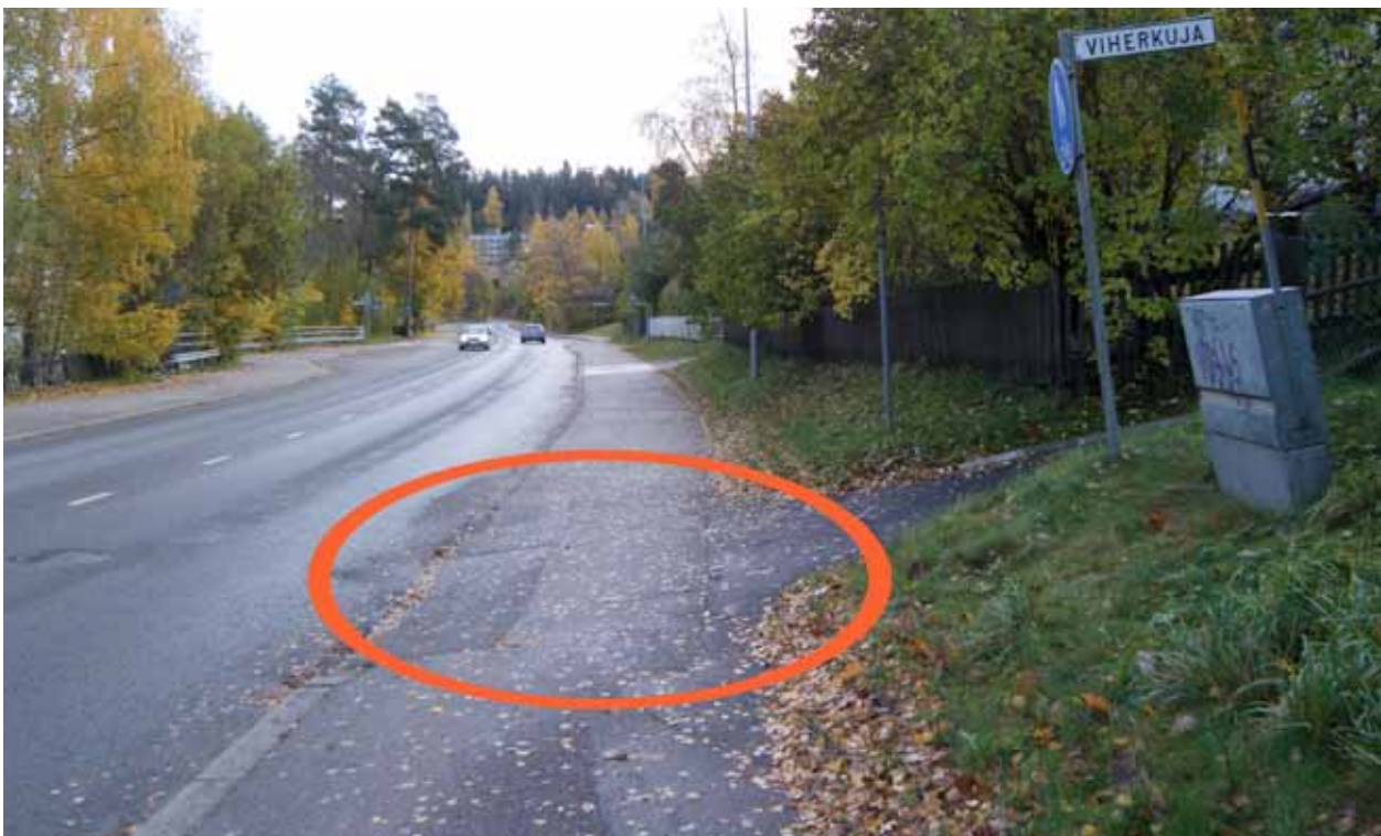
Kuva 156. Pyörätien jatke puuttuu.
