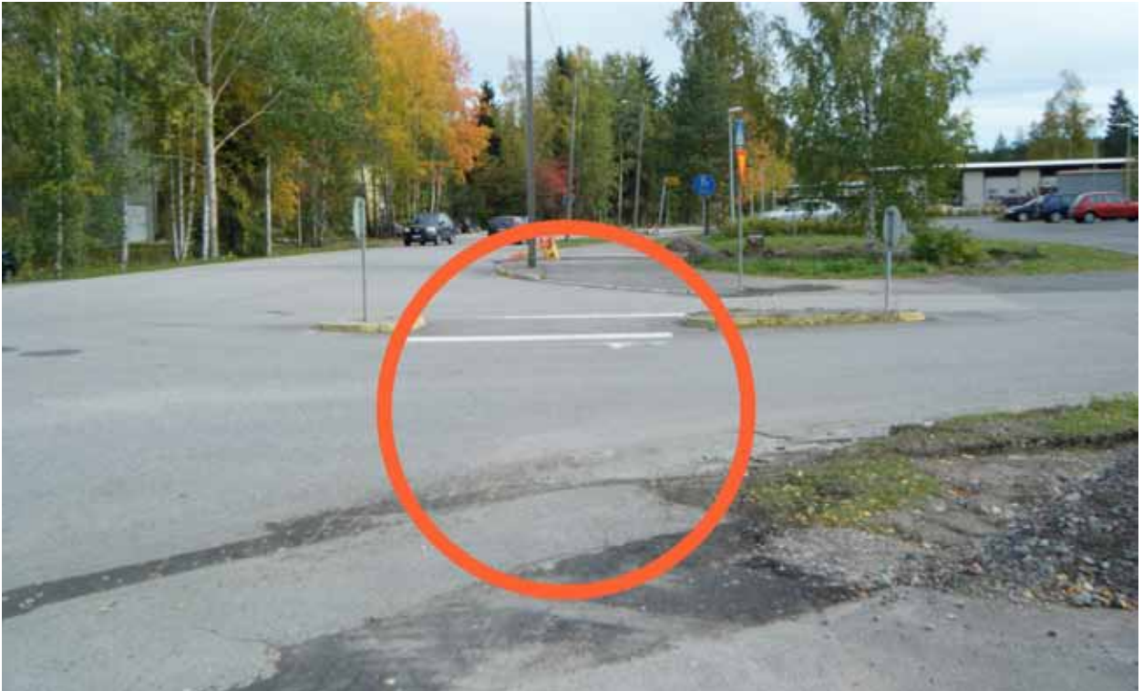
Kuva 117. Pyörätien jatke puuttuu.
