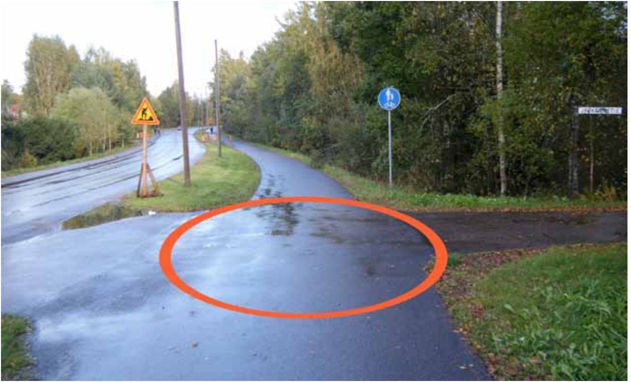
Kuva 89. Pyörätien jatke puuttuu.
