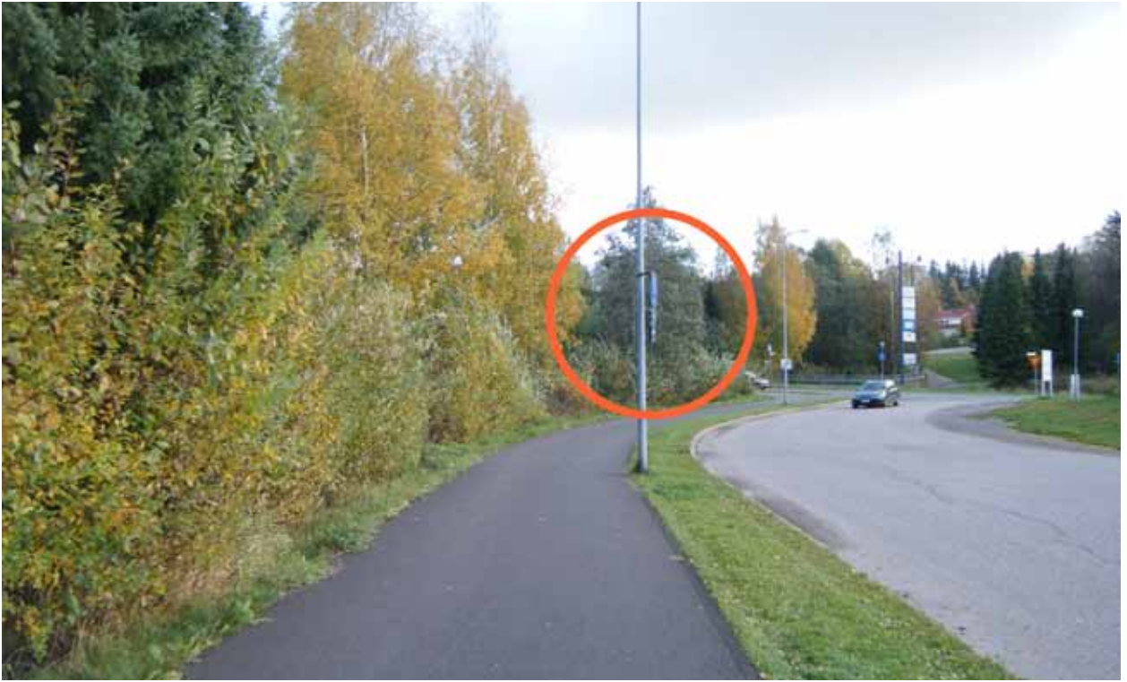
Kuva 145. Yhdistetyn kevyenliikenteenväylän liikennemerkki suunnattu parkkipaikalle, jonne ei ole kevyenliikenteen yhteyttä.
