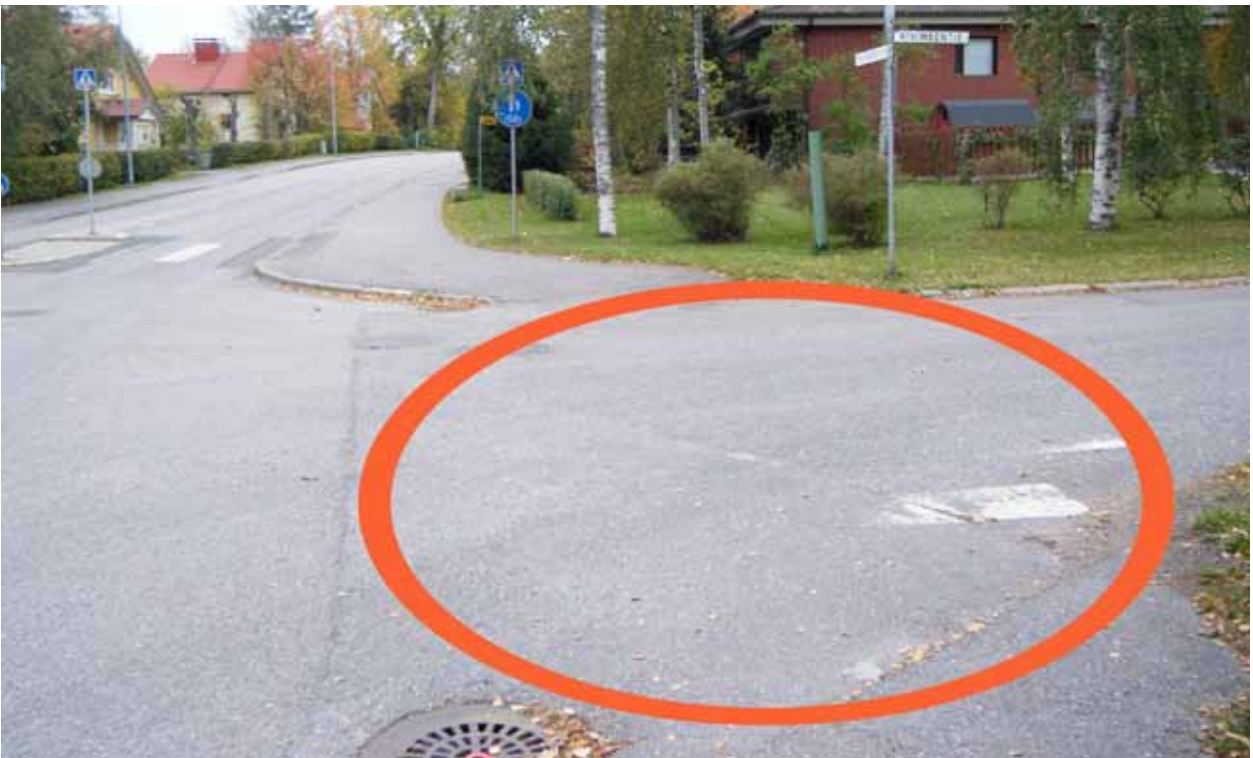
Kuva 124. Pyörätien jatke puuttuu.
