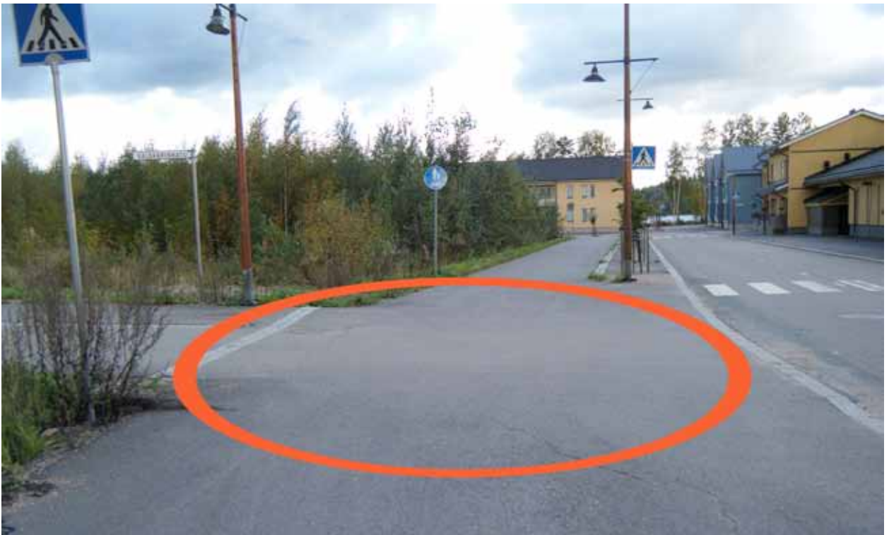
Kuva 78. Pyörätien jatke puuttuu.
