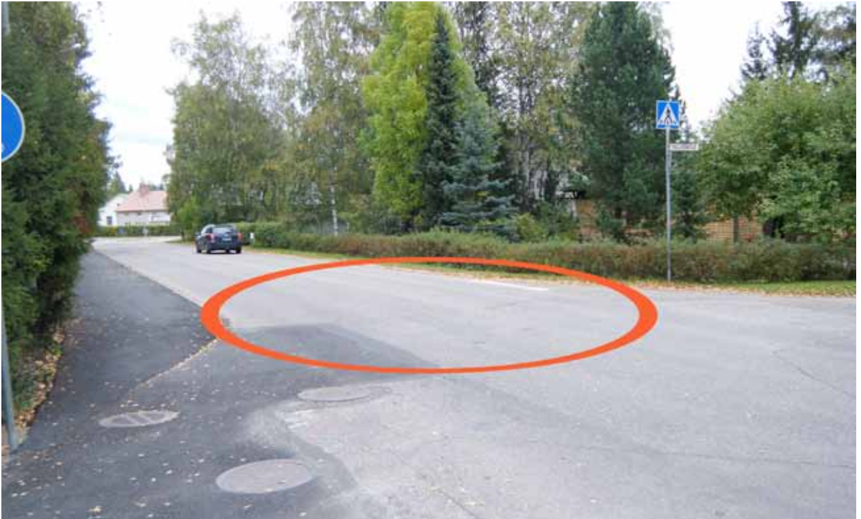
Kuva 45. Pyörätien jatke puuttuu.
