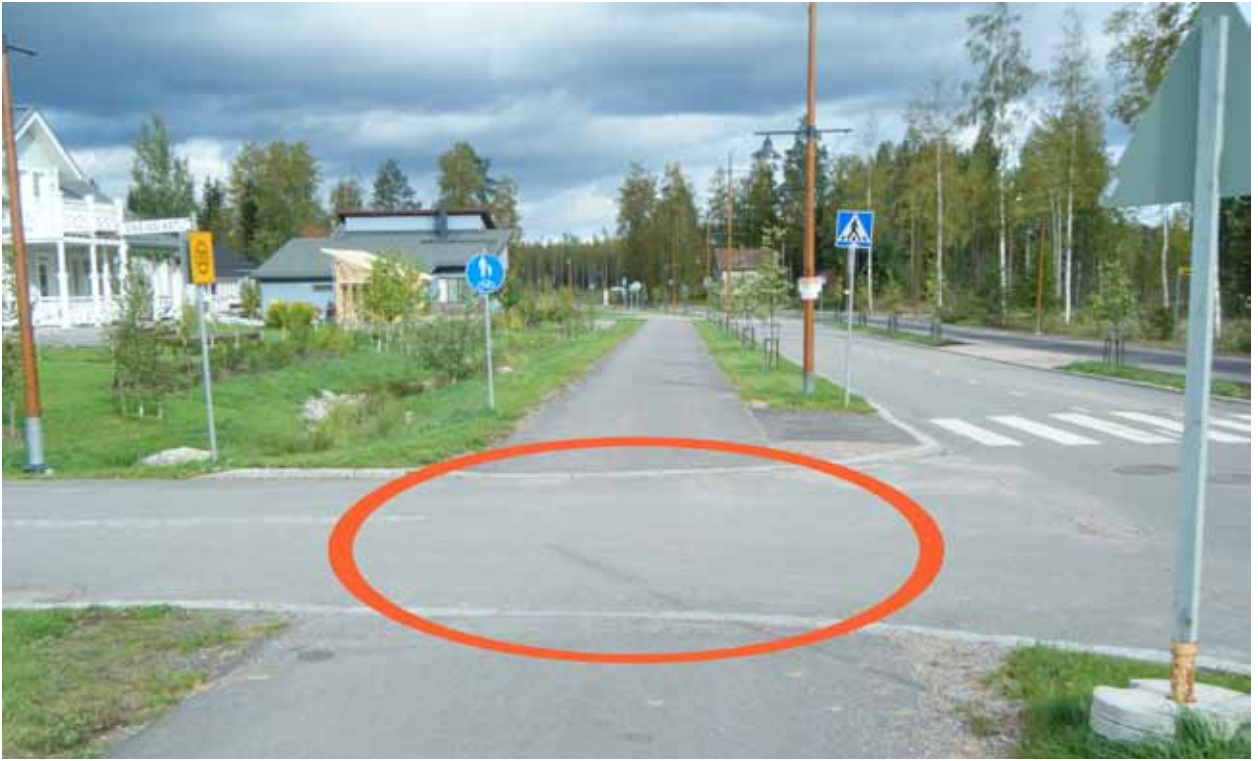
Kuva 73. Pyörätien jatke puuttuu.
