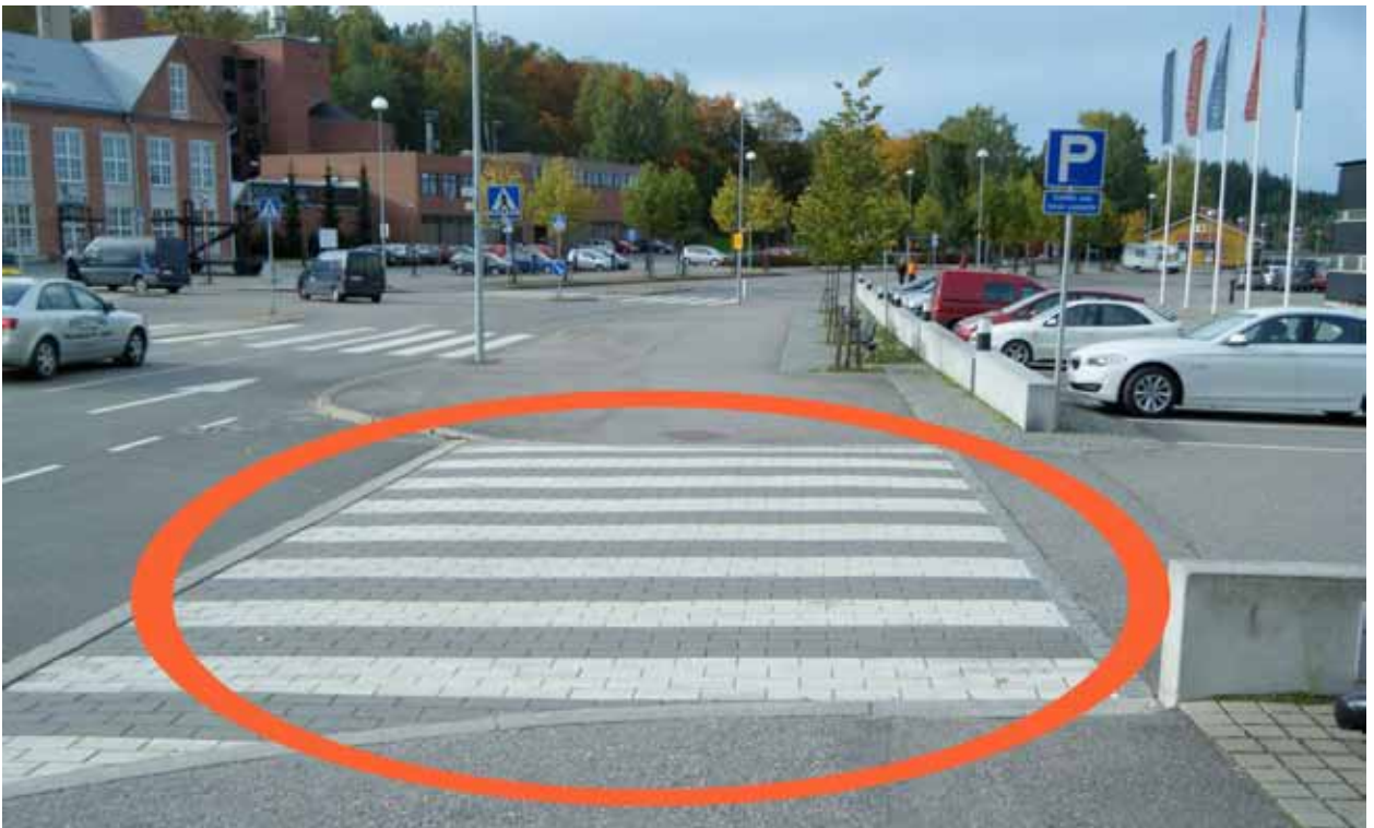
Kuva 130. Pyörätien jatke puuttuu.
