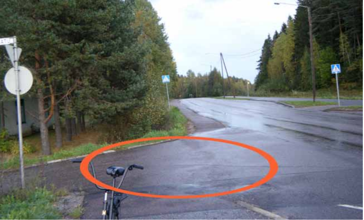
Kuva 88. Pyörätien jatke puuttuu.
