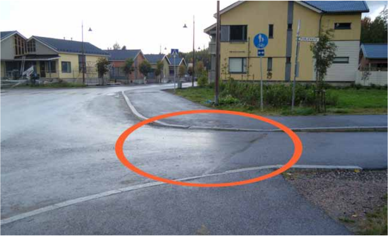
Kuva 79. Pyörätien jatke puuttuu.
