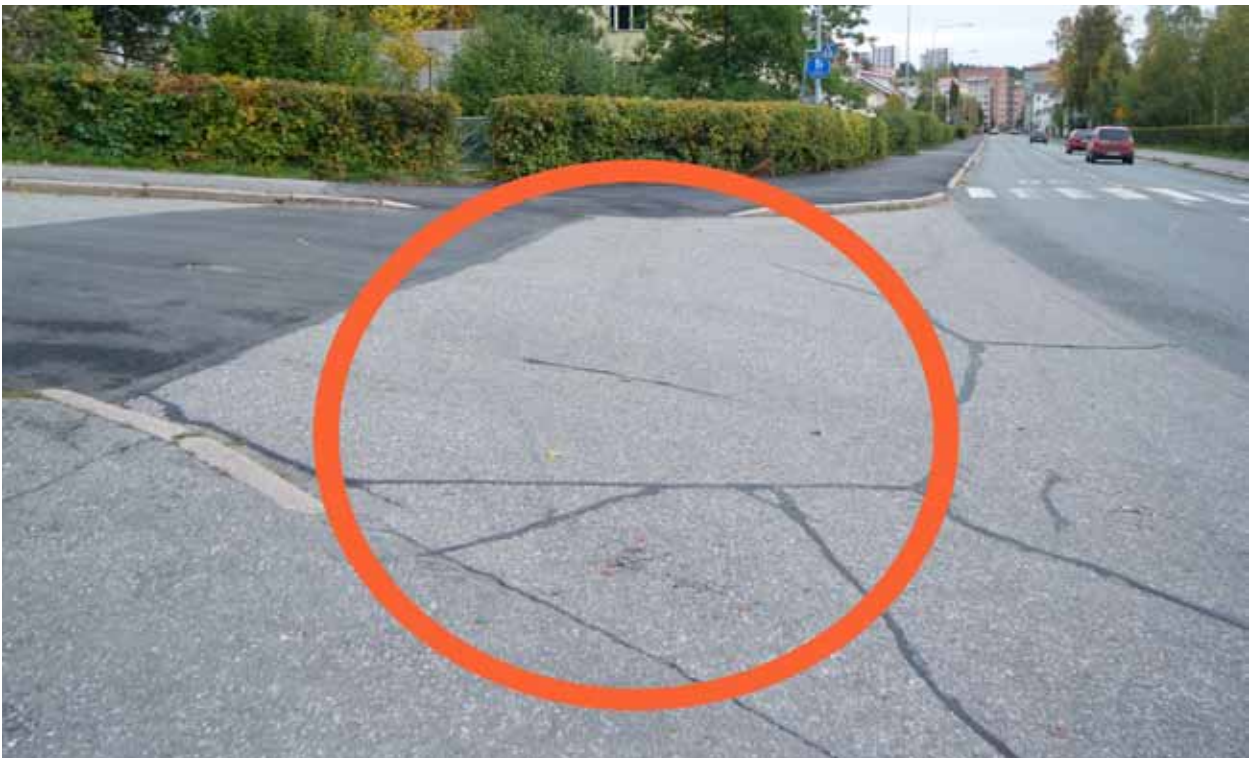
Kuva 134. Pyörätien jatke puuttuu.
