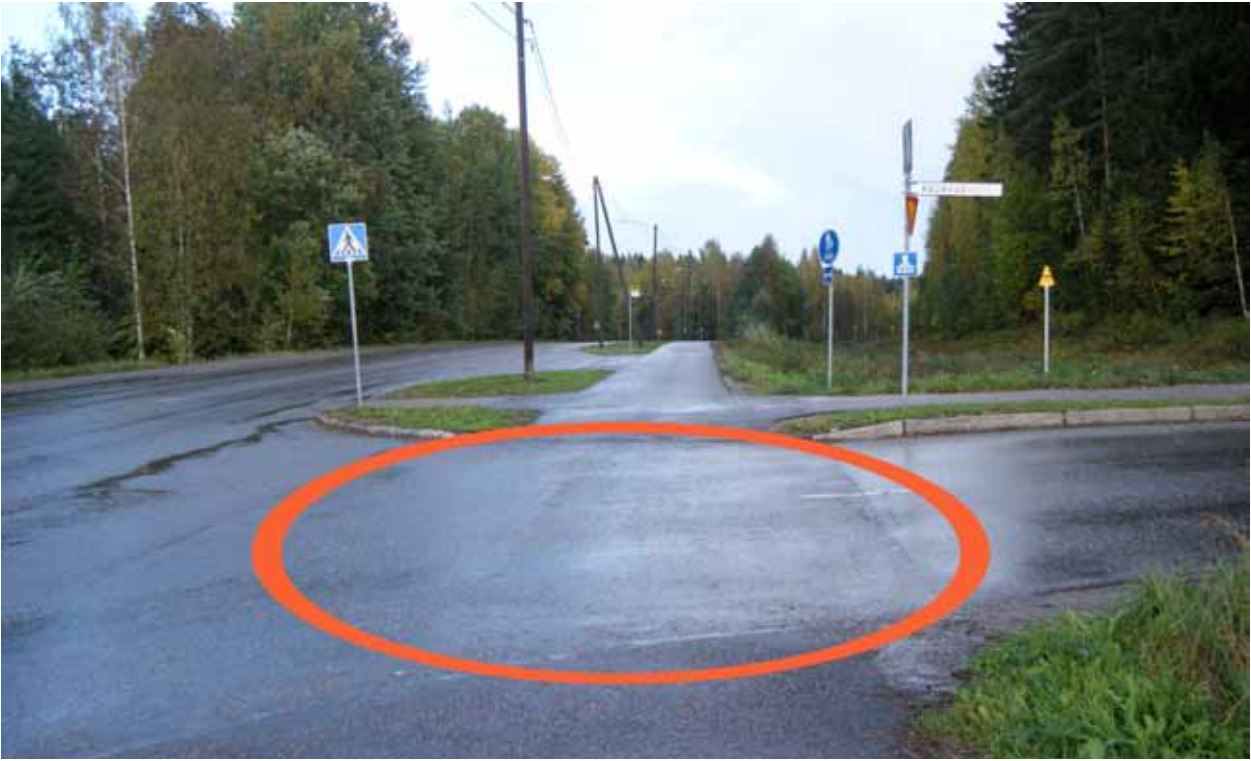
Kuva 87. Pyörätien jatke puuttuu.
