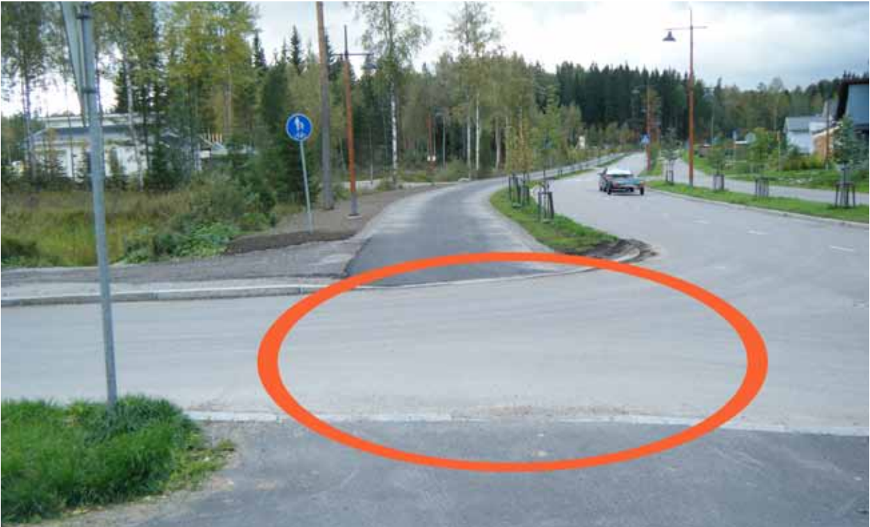
Kuva 75. Pyörätien jatke puuttuu.
