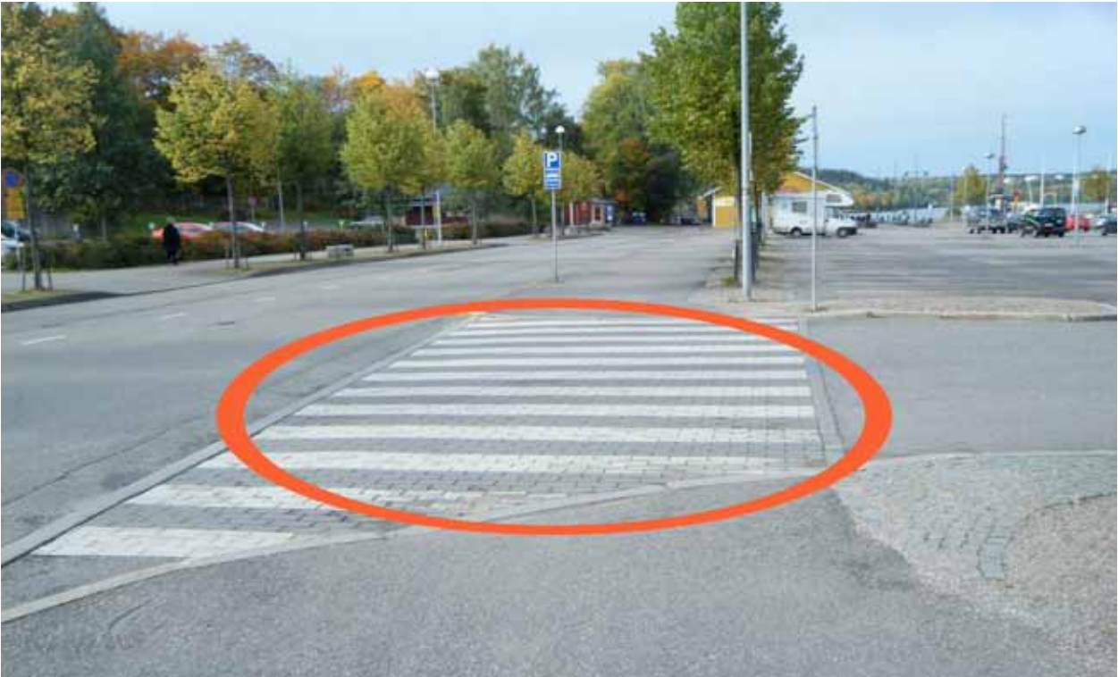
Kuva 131. Pyörätien jatke puuttuu.
