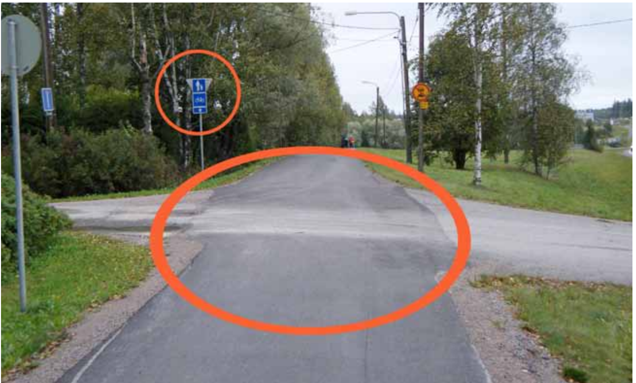
Kuva 38. Poikkeava yhdistetyn kevyenliikenteen liikennemerkki. Pyörätien jatke puuttuu.
