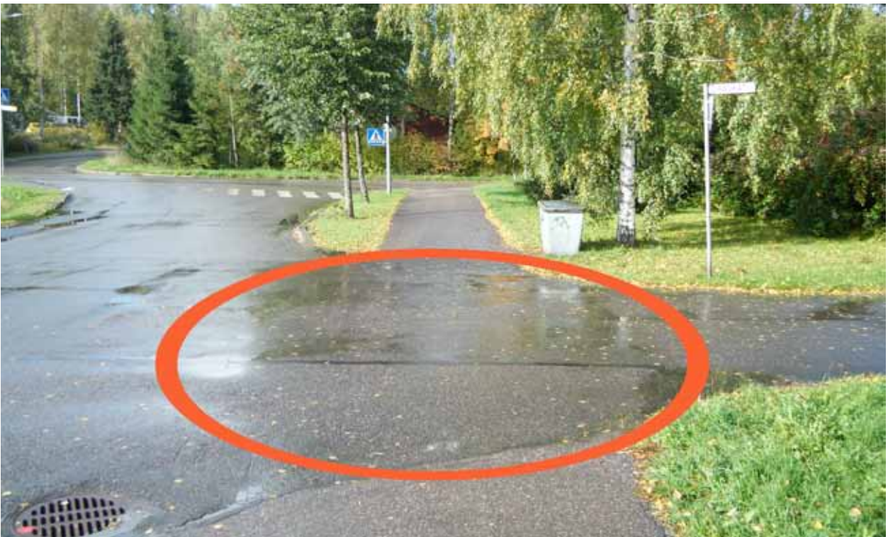
Kuva 84. Pyörätien jatke puuttuu.
