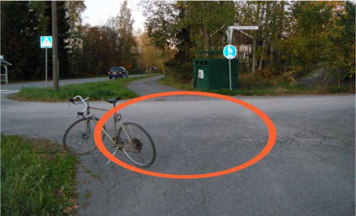
Kuva 142. Pyörätien jatke puuttuu.
