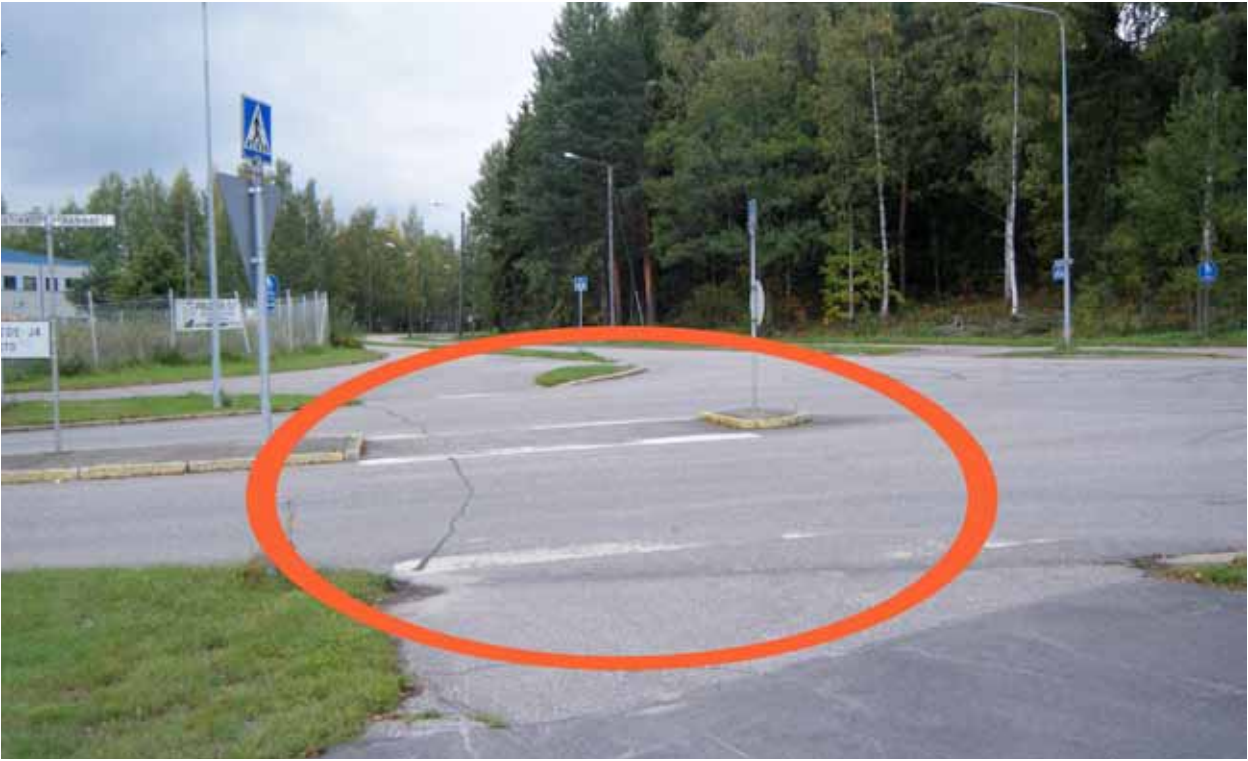
Kuva 55. Pyörätien jatke puuttuu.
