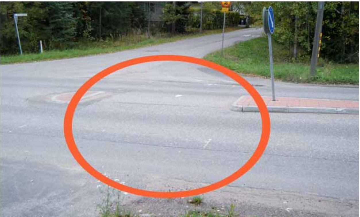
Kuva 120. Pyörätien jatke puuttuu.
