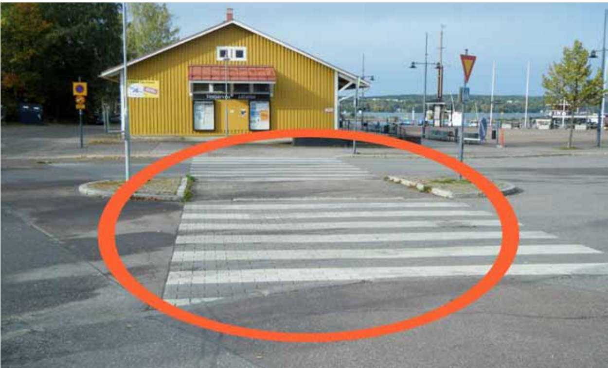
Kuva 132. Pyörätien jatke puuttuu.
