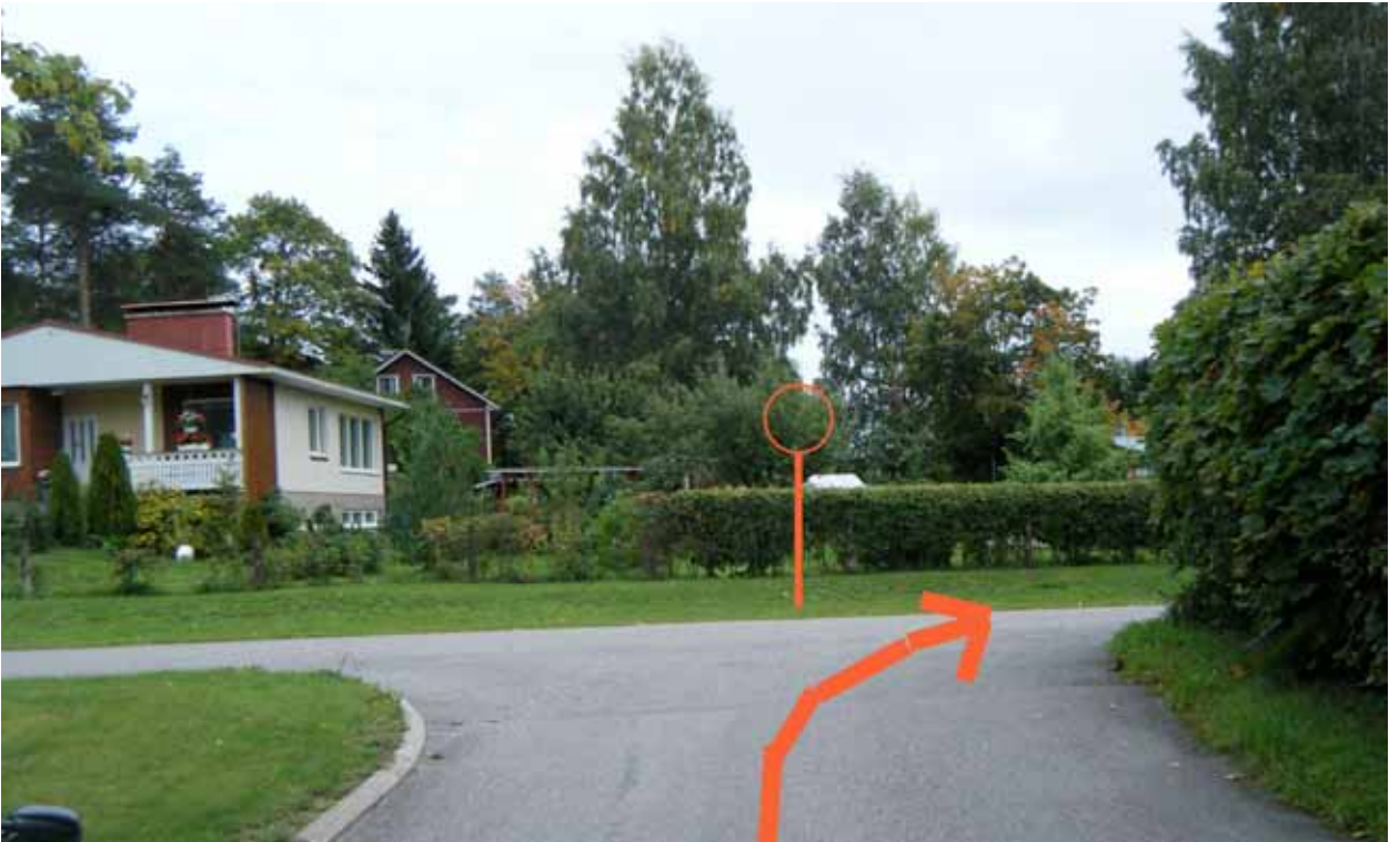
Kuva 15. Yhdistetty kevyenliikenteenväylä jatkuu nuolen osoittamaan suuntaan. Kuva osoittamassa kohdassa olisi hyvä olla yhdistetyn kevyenliikenteenväylä liikennemerkki.
