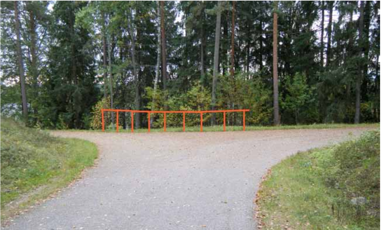
Kuva 7. Väylä haarautuu. Aita estäisi rotkoon putoamisen ja ohjaisi liikenteen väylän suuntaisesti.
