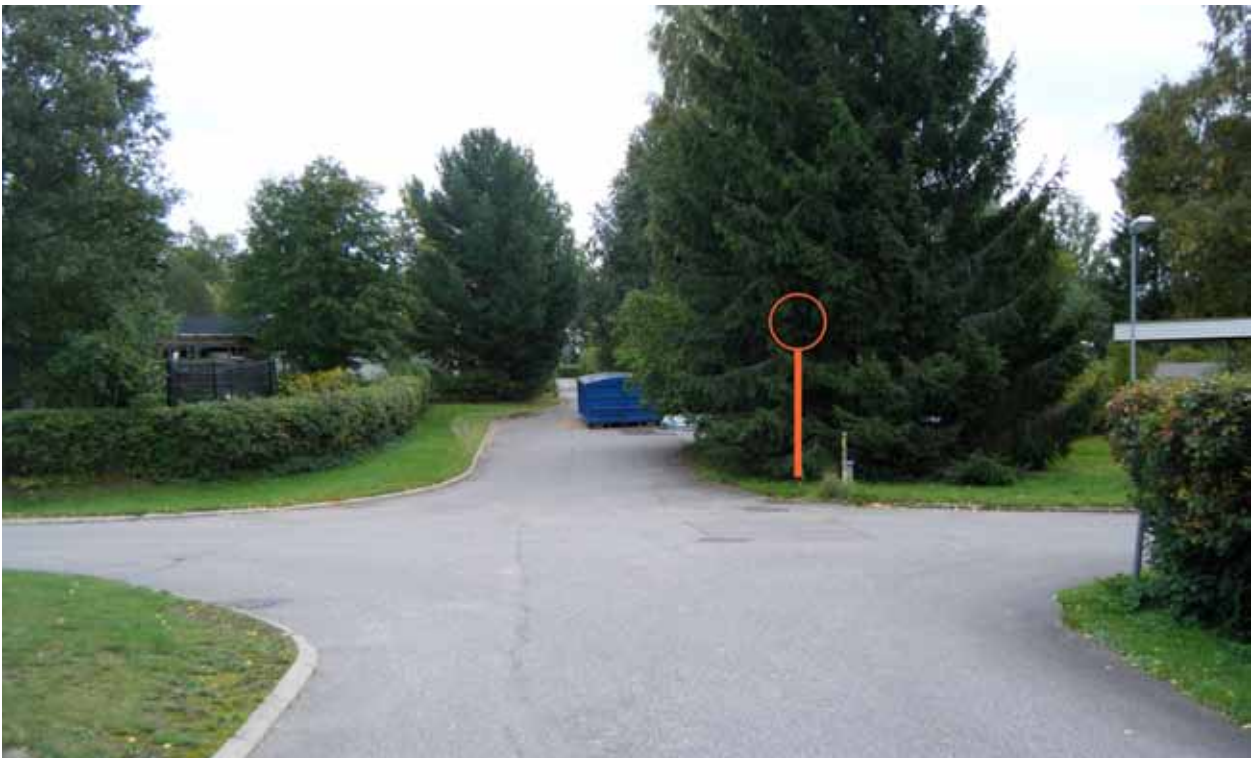
Kuva 14. Kuva osoittamassa kohdassa olisi hyvä olla yhdistetyn kevyenliikenteenväylä liikennemerkki. Kasvillisuus levittäytynyt väylälle.
