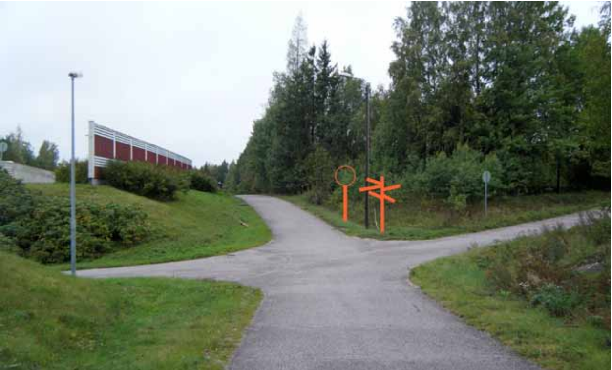
Kuva 27. Kuva osoittamassa kohdassa olisi hyvä olla yhdistetyn kevyenliikenteenväylä liikennemerkki ja opastetolppa.
