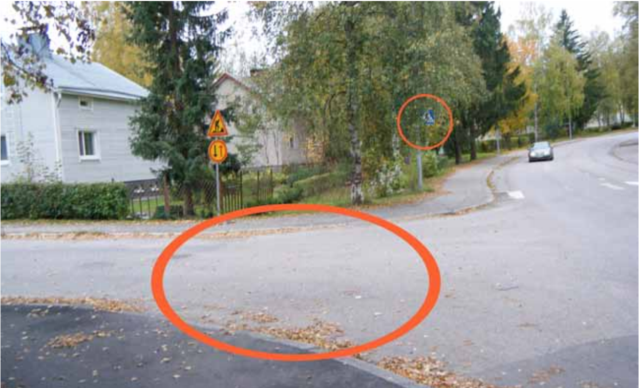
Kuva 127. Pyörätien jatke puuttuu. Kasvillisuus peittää yhdistetyn kevyenliikenteen liikennemerkkin.
