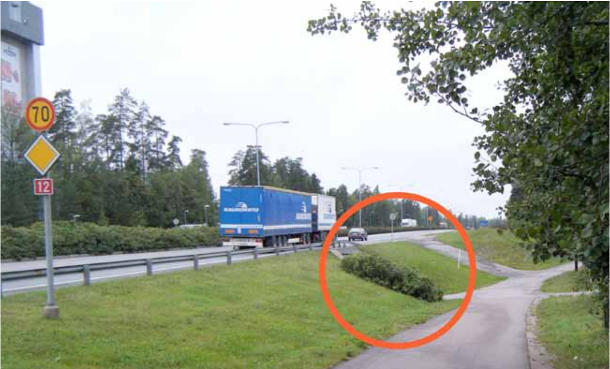
Kuva 23. Alikulcutunnelin suuaukon edessä oleva kasvillisuus peittää näkemäalueen.
