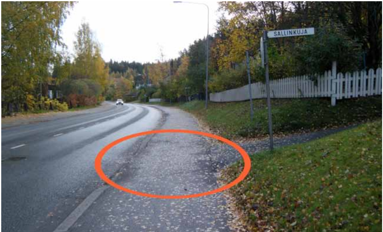
Kuva 157. Pyörätien jatke puuttuu.
