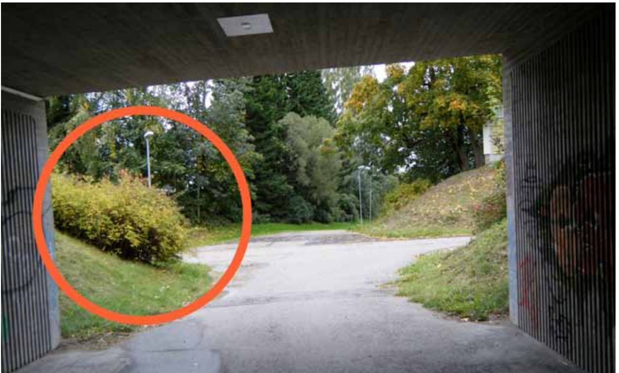
Kuva 34. Alikulkutunnelin suuaukon edessä oleva kasvillisuus peittää näkemäalueen
