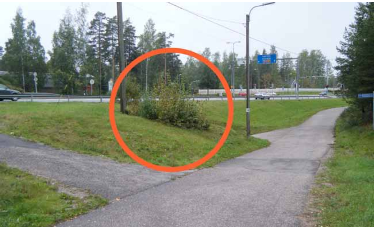
Kuva 24. Alikulcutunnelin suuaukon edessä oleva kasvillisuus ja pinnanmuotoilu peittää näkymäalueen.
