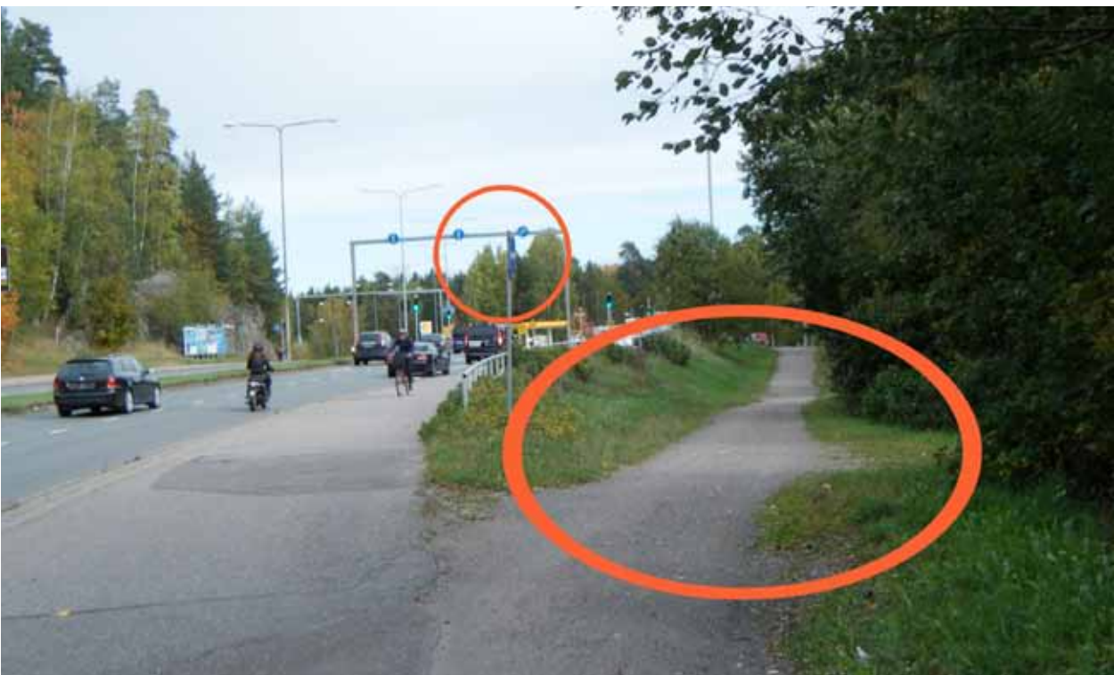
Kuva 116. Mitä kautta pyöräliikenne ohjataan? Yhdistetyn kevyenliikenteenväylän liikenne merkki on suunnattu hiekkatien käyttäjille.
