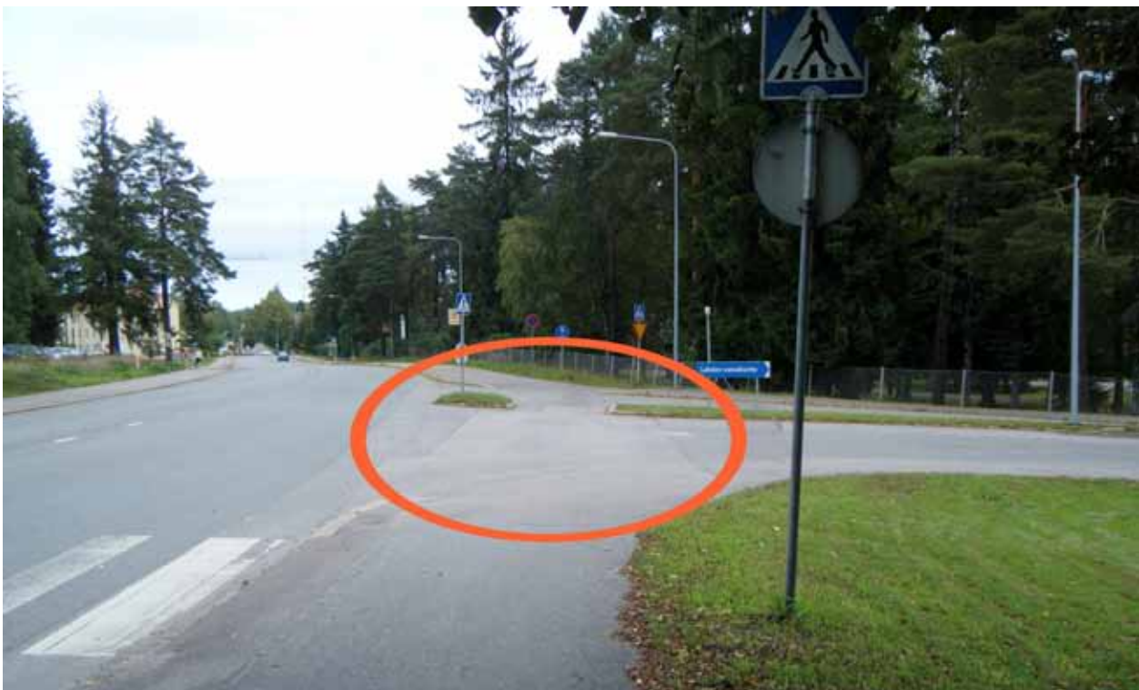
Kuva 16. Pyörätien jatke puuttuu.
