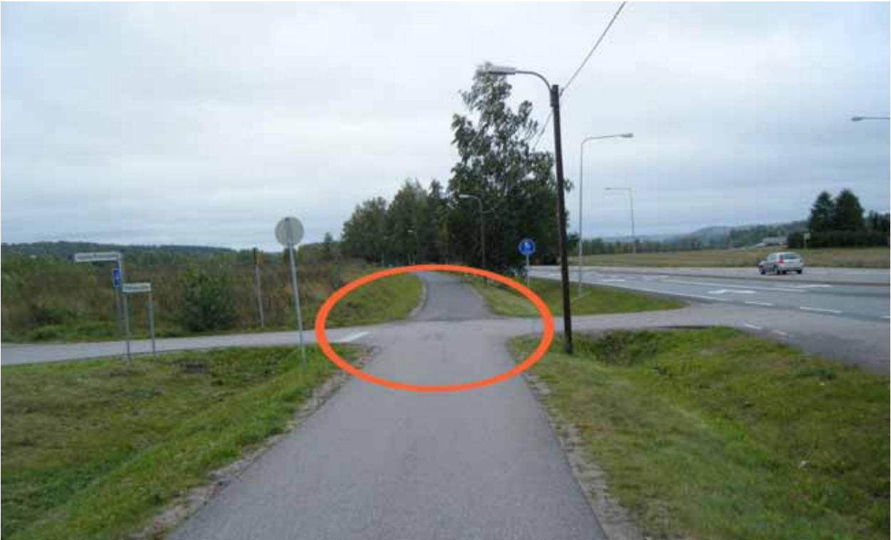
Kuva 35. Pyörätien jatke puuttuu.
