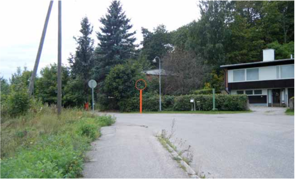
Kuva 19. Kuvan osoittamassa kohdassa olisi hyvä olla yhdistetyn kevyenliikenteenväylän merkintä.
