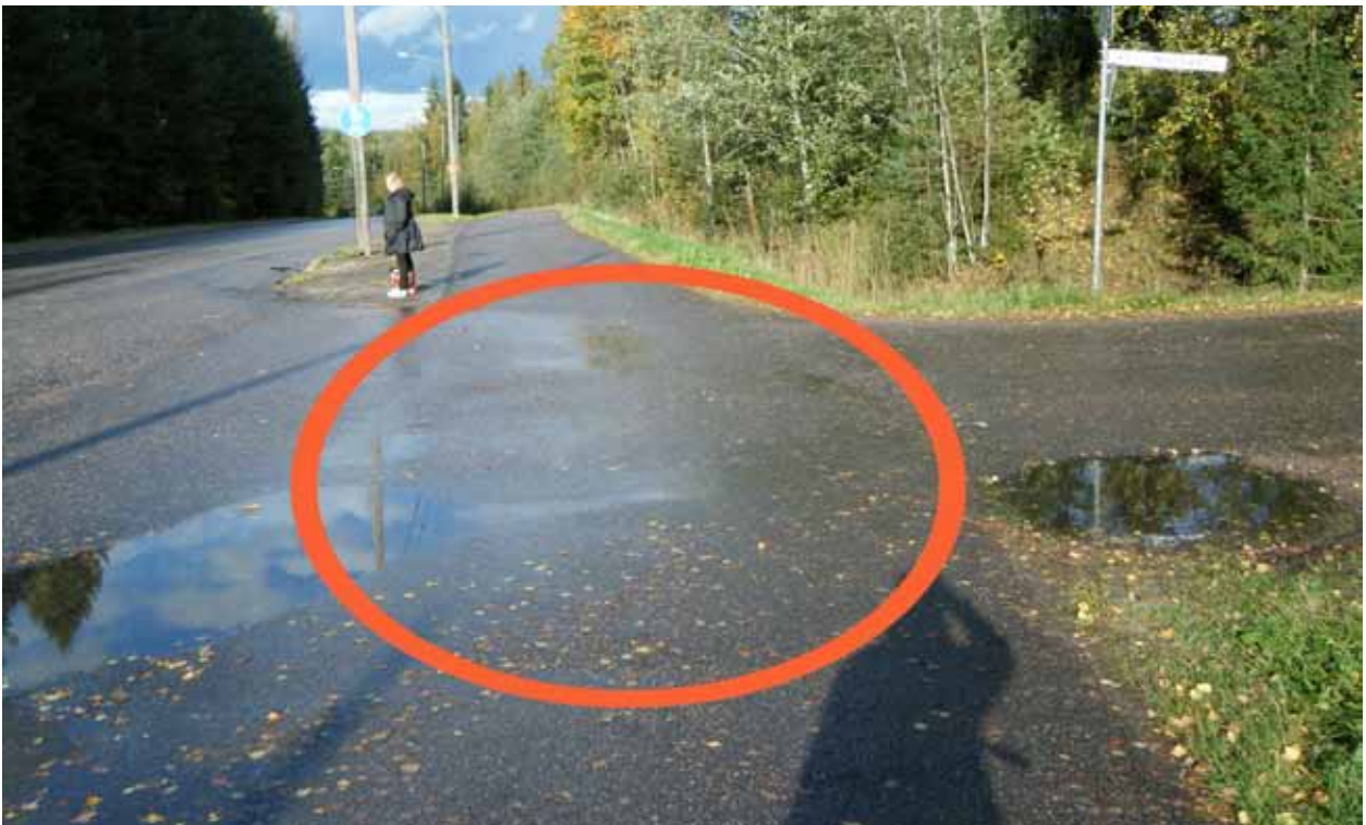
Kuva 102. Pyörätien jatke puuttuu.
