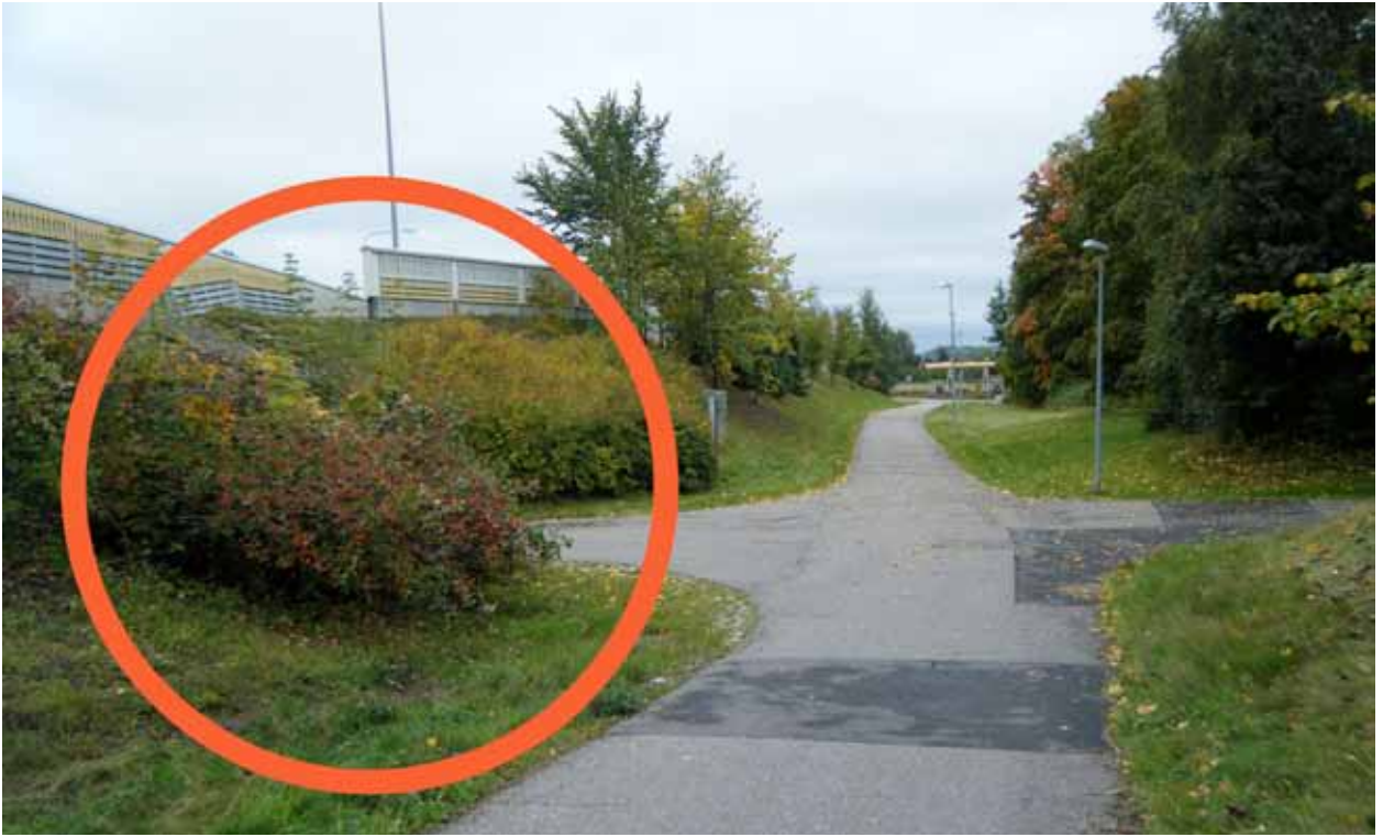
Kuva 33. Alikulkutunnelin suuaukon edessä oleva kasvillisuus peittää näkemäalueen
