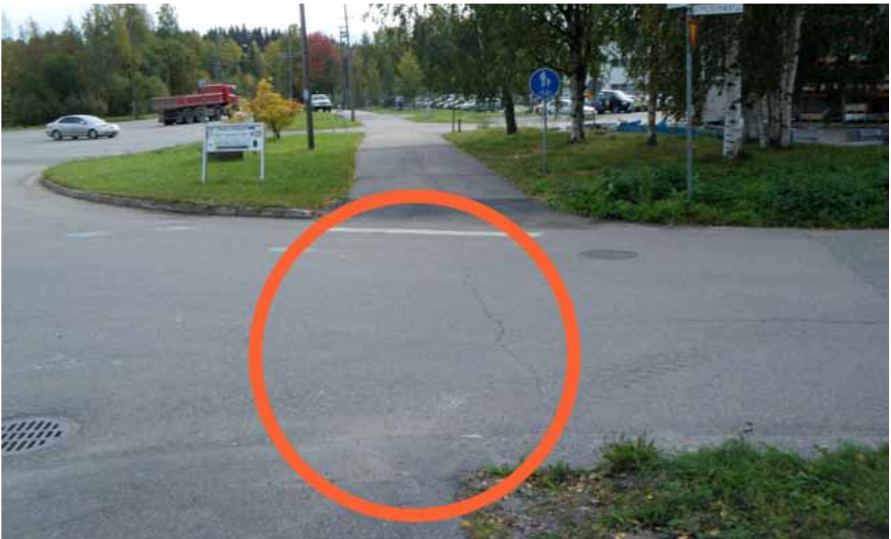
Kuva 118. Pyörätien jatke puuttuu.
