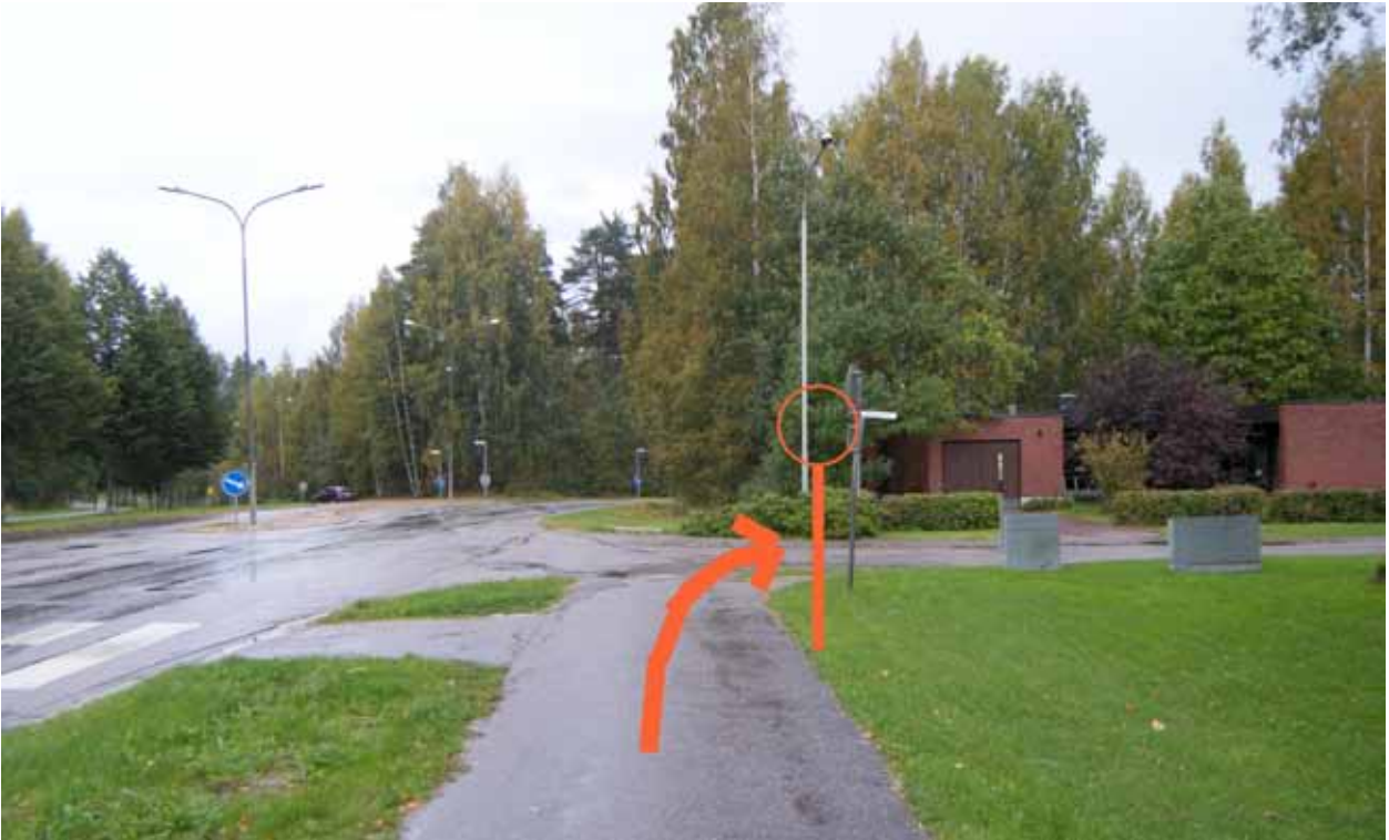
Kuva 59. Yhdistetty kevyenliikenteenväylä jatkuu nuolen osoittamaan suuntaan. Kuvan osoittamassa kohdassa olisi hyvä olla liikennemerkki, joka ilmaisee tämän asian.
