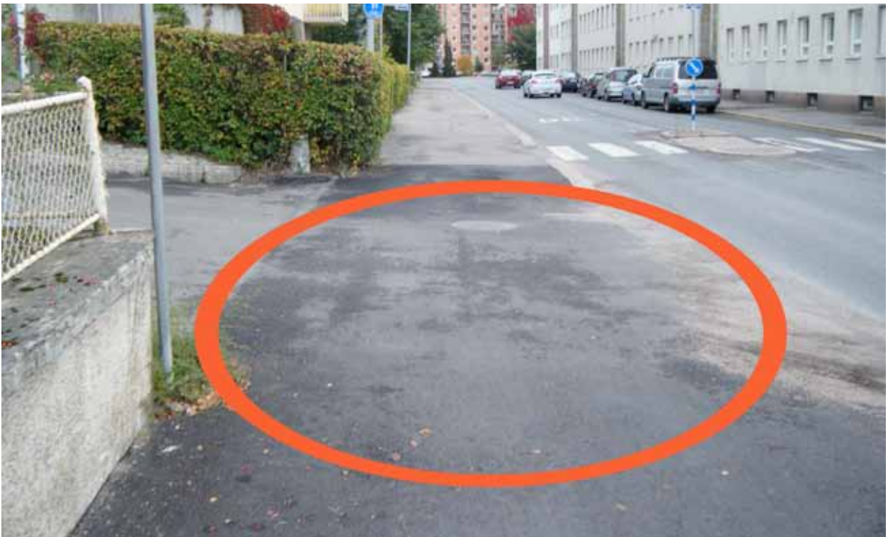
Kuva 138. Pyörätien jatke puuttuu.
