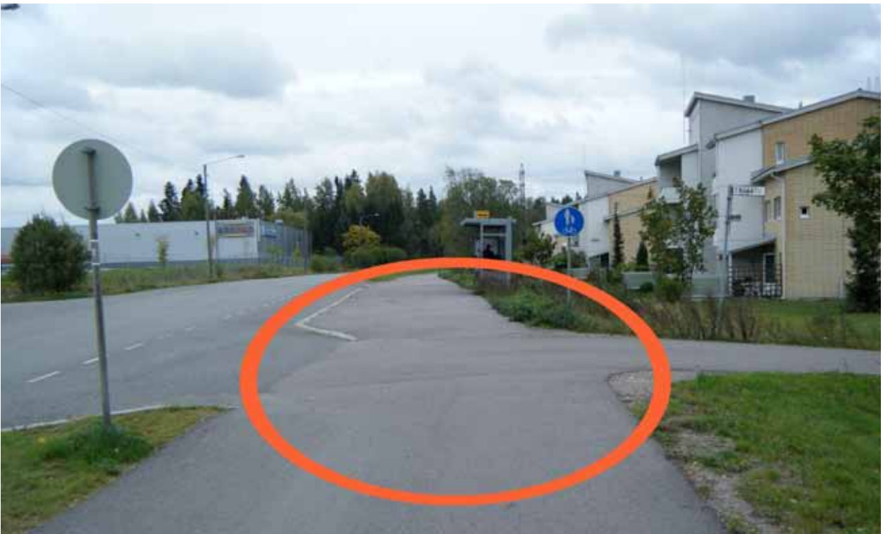
Kuva 52. Pyörätien jatke puuttuu.
