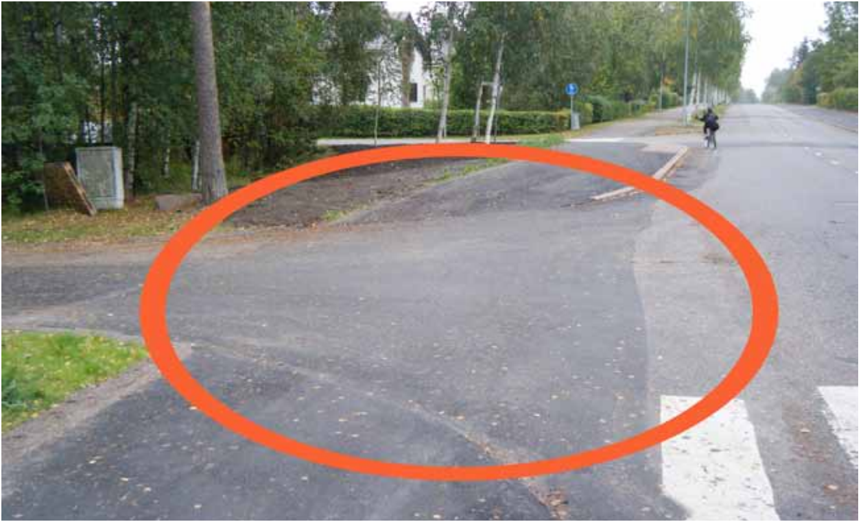
Kuva 41. Pyörätien jatke puuttuu.
