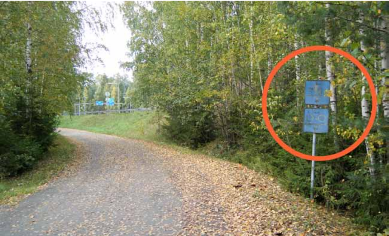
Kuva 67. Huonokuntoinen ja poikkeava yhdistetyn kevyenliikenteenväylän liikennemerkki.
