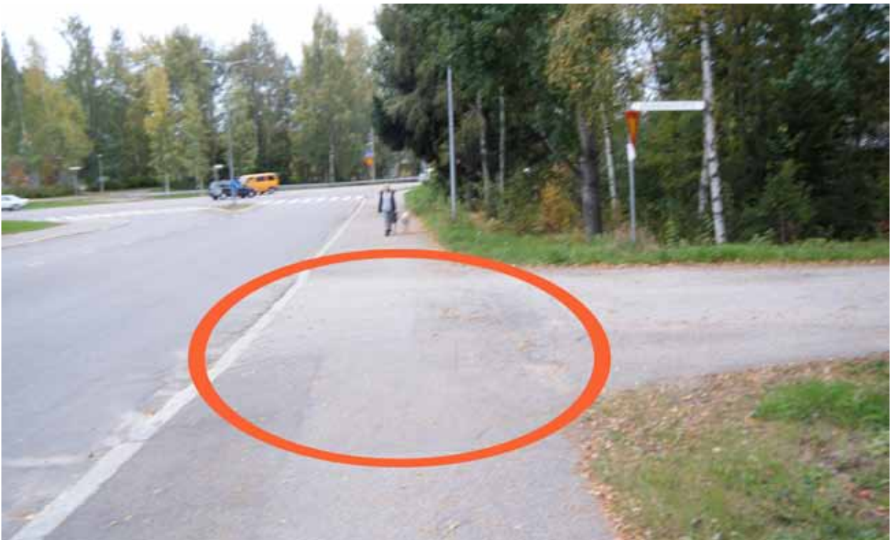
Kuva 122. Pyörätien jatke puuttuu.
