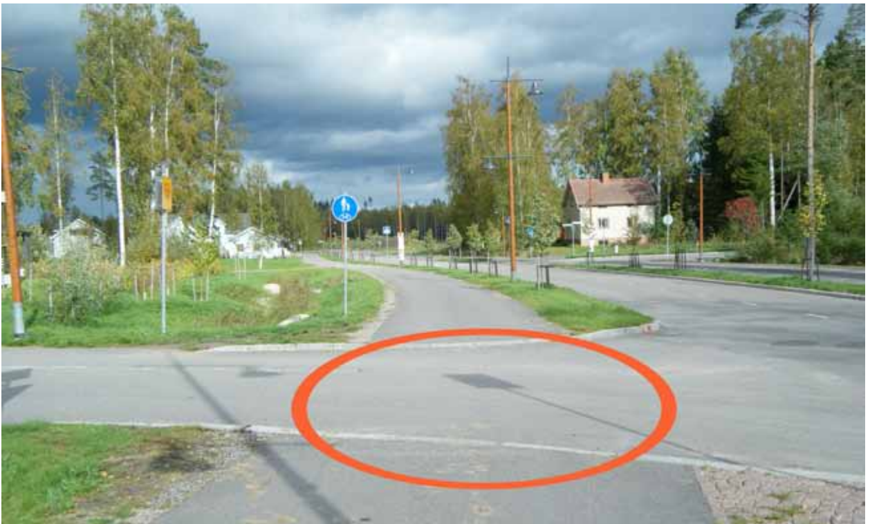
Kuva 74. Pyörätien jatke puuttuu.
