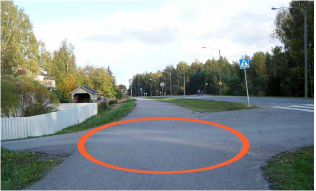
Kuva 105. Pyörätien jatke puuttuu.
