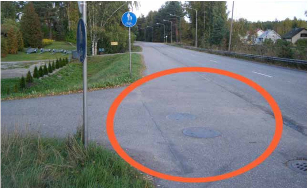
Kuva 110. Pyörätien jatke puuttuu.
