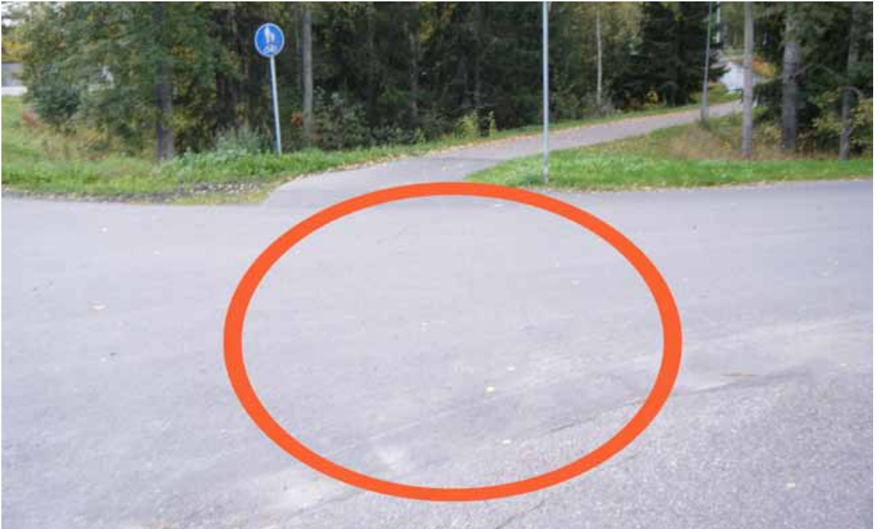
Kuva 121. Pyörätien jatke puuttuu.
