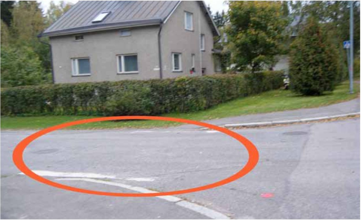
Kuva 123. Pyörätien jatke puuttuu.
