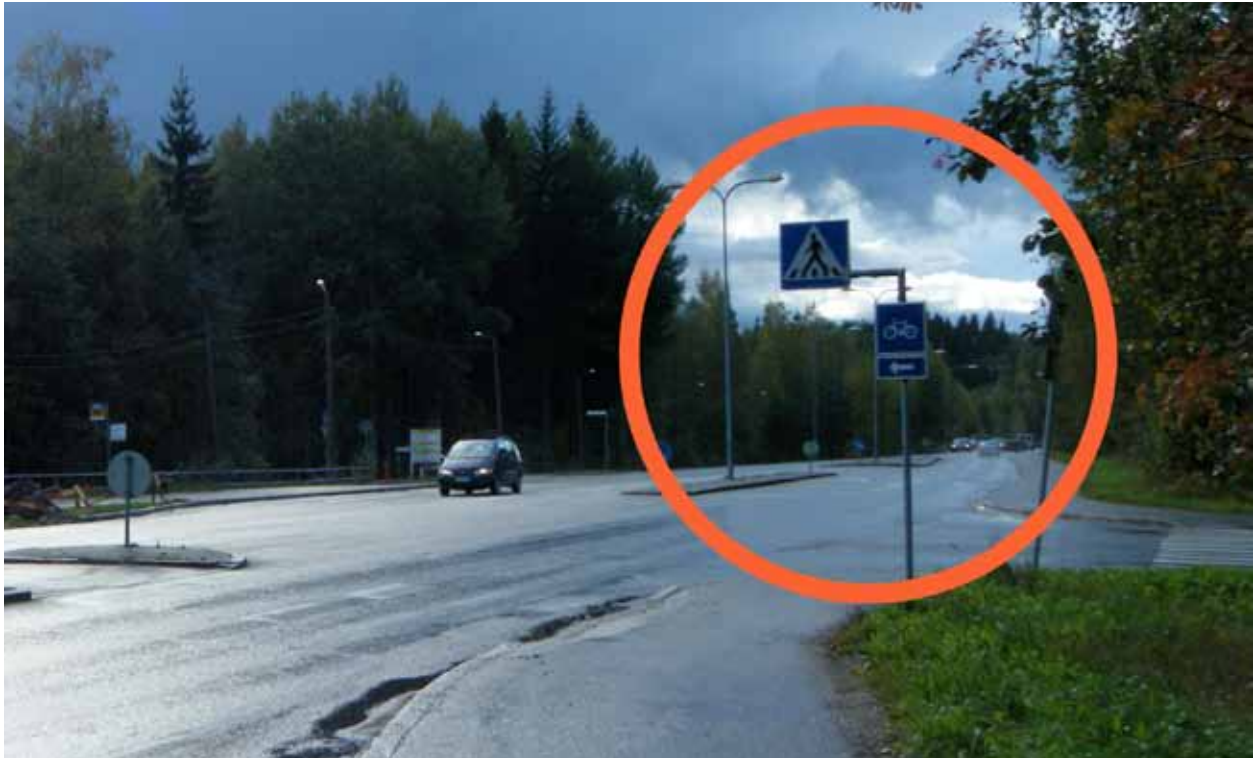
Kuva 85. Pyörätie siirtyy autotien toiselle puolelle. Jalankulkuväylä merkintä puuttuu.
