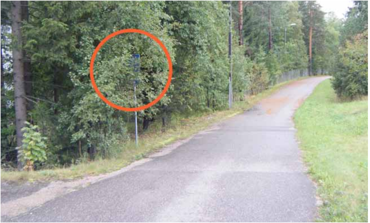
Kuva 25. Kasvillisuus peittää yhdistetyn kevyenliikenteenväylän liikennemerkkin.
