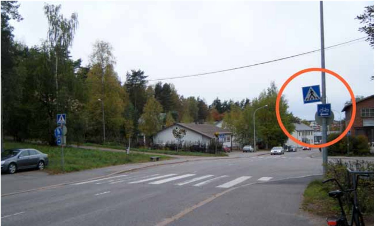
Kuva 129. Pyörätie siirtyy autotien toiselle puolelle. Jalankulkuväylä merkintä puuttuu.
