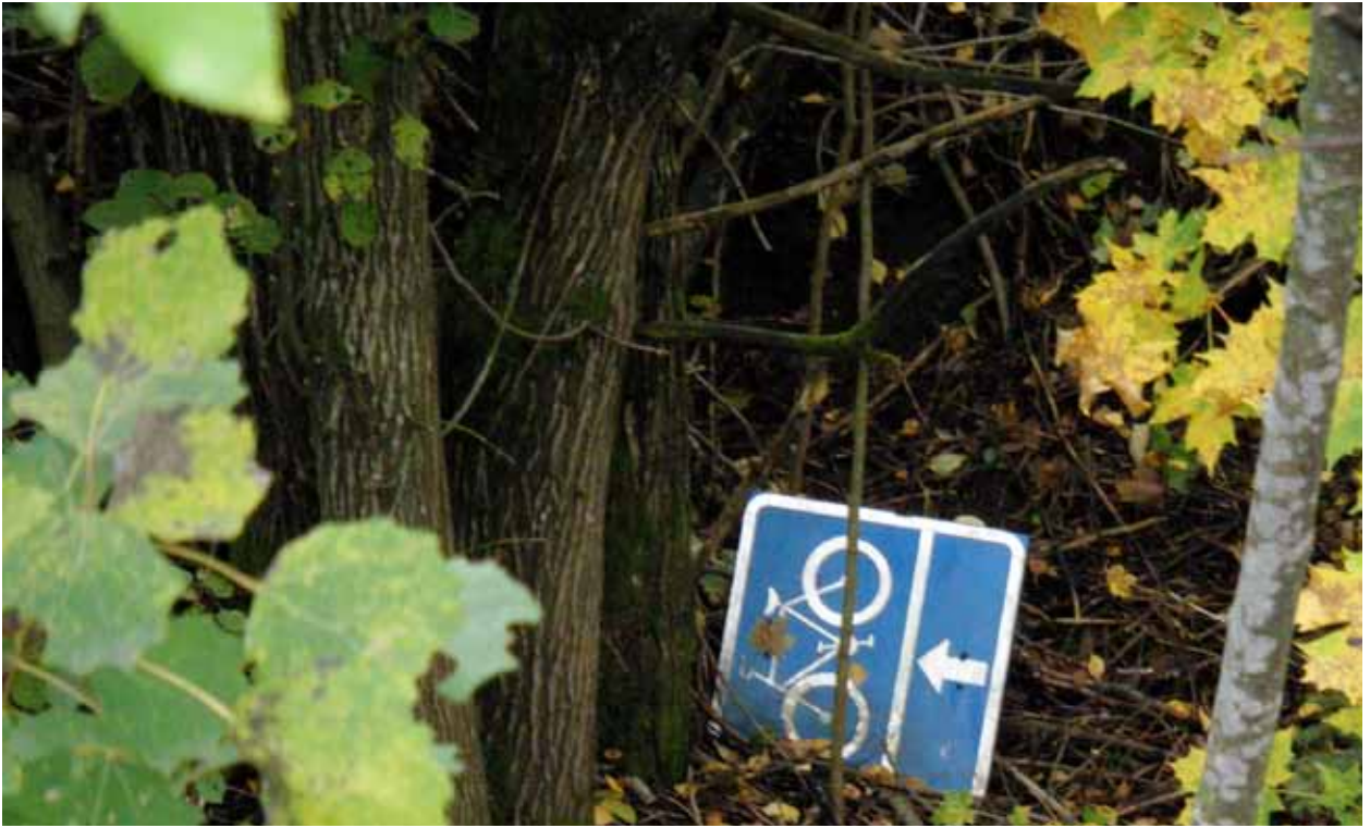
Kuva 65. Huonokuntoinen ja poikkeava yhdistetyn kevyenliikenteenväylän liikennemerkki.
