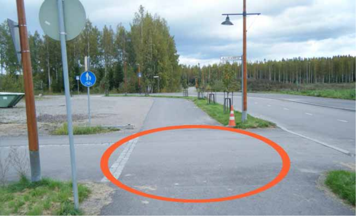
Kuva 76. Pyörätien jatke puuttuu.
