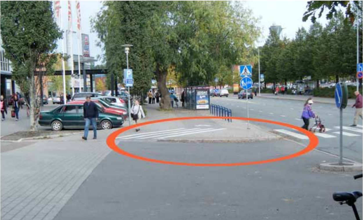
Kuva 115. Pyöräkaistan päässä korkea reunakiveys. Vaarallinen pyöräilijöille.
