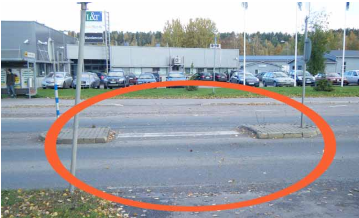
Kuva 148. Pyörätien jatke puuttuu.
