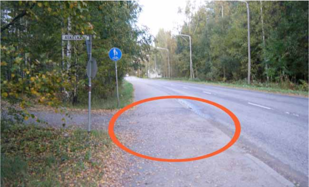
Kuva 111. Pyörätien jatke puuttuu.
