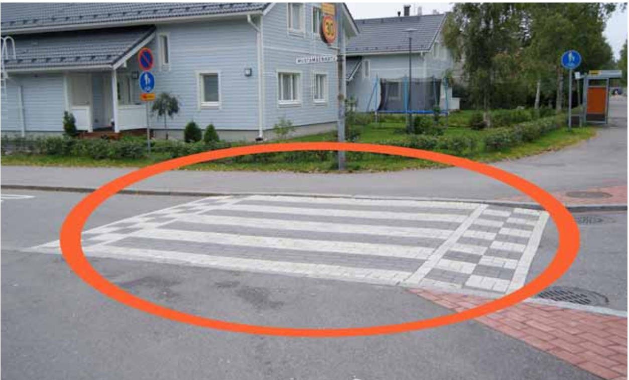
Kuva 40. Pyörätien jatke puuttuu.
