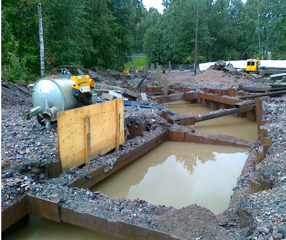
Kuva 24. Vesisade täytti kaivannot usein.
