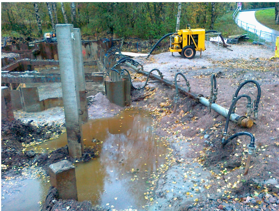
Kuva 12. Imuputkia tarvittiin vaikeissa paikoissa monta kappaletta.
