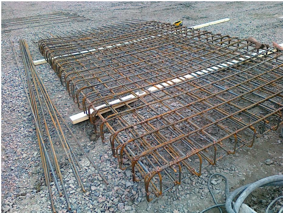
Kuva 23. Teräsbetonilaatan ensimmäinen raudoitus.
