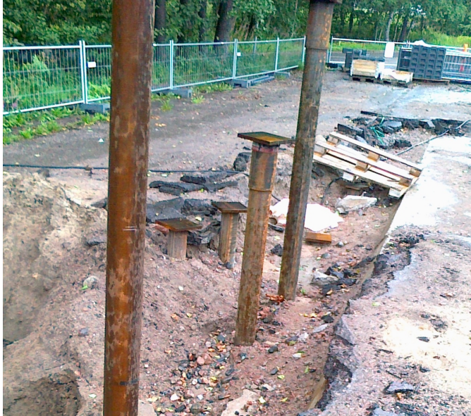
Kuva 20. Paaluhatuilla varustettuja RR-paaluja.
