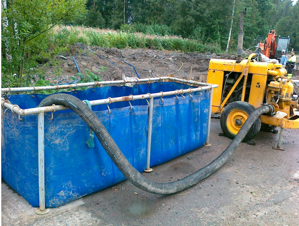
Kuva 8. Vesihuuhteluun tarvittava allas ja pumppu.
