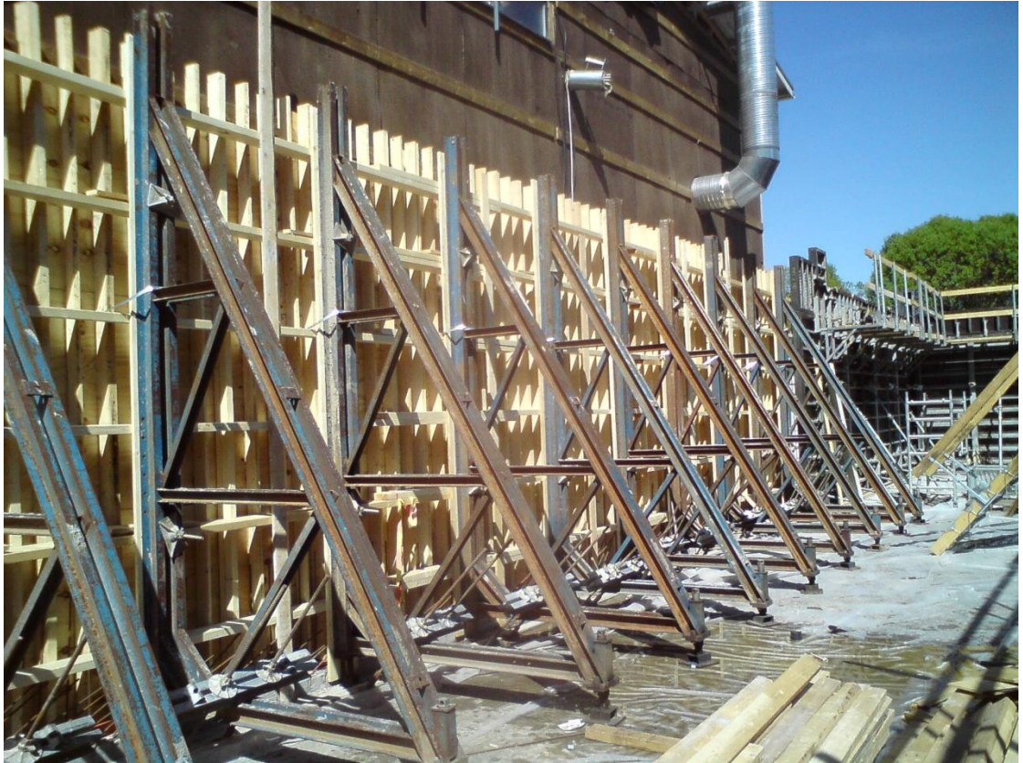
Kuva 7. Kuvassa on toista seinää vasten tehty muotti eli ns. vastavalun muotti, ja sen tuenta teräksisin kolmiojaloin. Taustalla näkyy kasettimuotin valmista kulkusiltaa. Kuva Savo-Karjalan Vesihuolto Oy.
