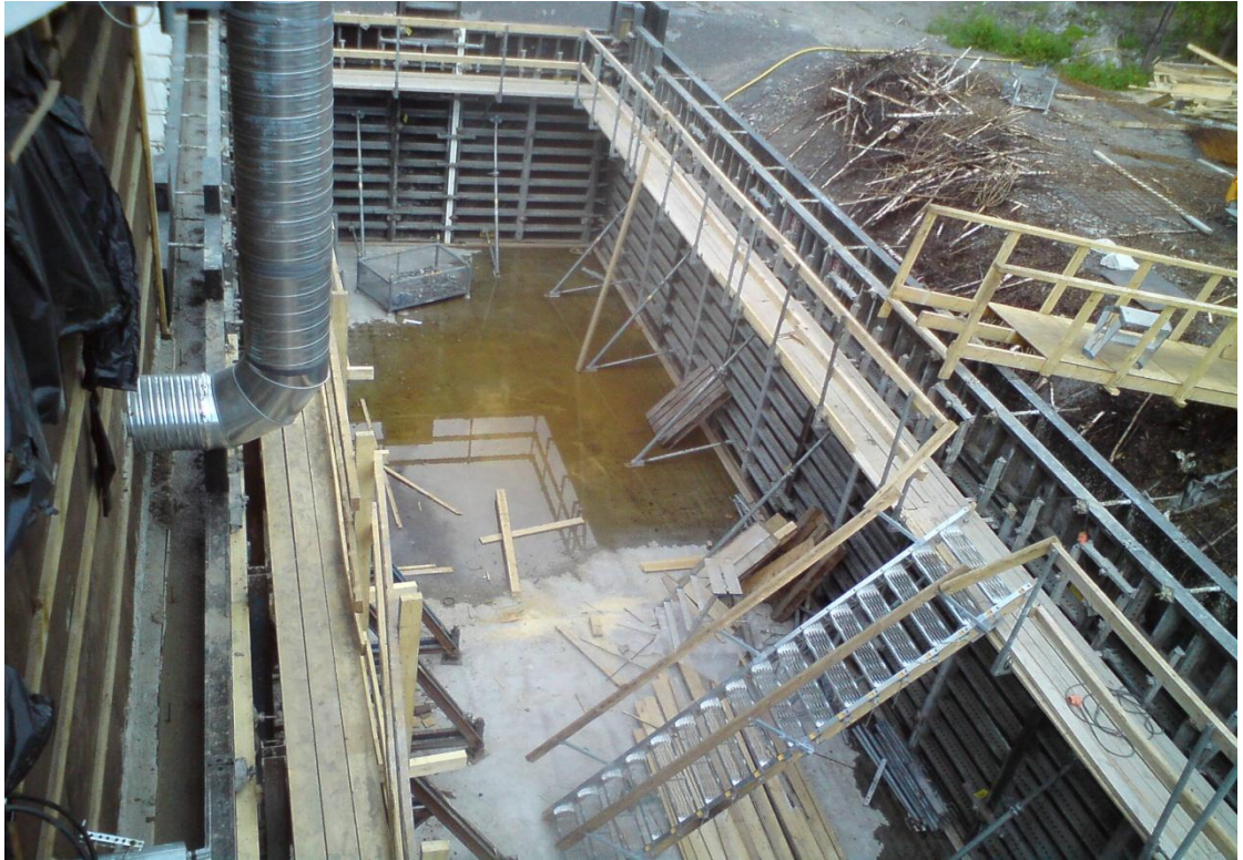
Kuva 14. Kuvassa oikealla kahden muotin välissä näkyy välikeputkia sekä muottisiteitä, jotka menevät muottien läpi. Muottiseinämän alapäässä näkyy lauta, jolla seinämän alapäähän asennustilanteessa syntynyt rako on tukittu. Kuva Savo-Karjalan Vesihuolto Oy
