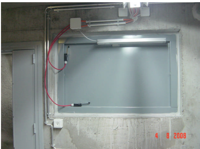
Kuva 3. Korvausilmaluukku (12).
