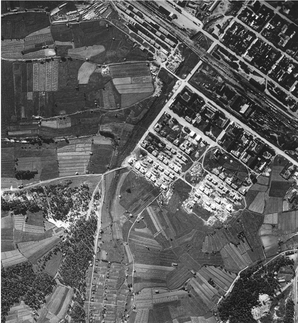
KUVA 2 Ilmakuva, Raksila (Oulun kaupunki, Tekninen keskus, Maa ja Mittaus 21.7.1939)
