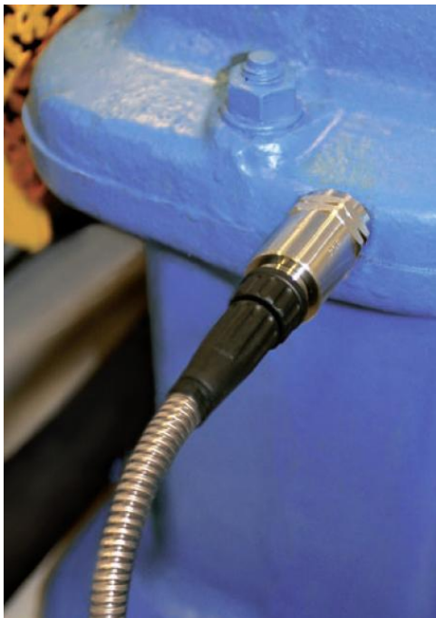
Kuva 10. Tärinämittarin anturi asennettuna koneen kylkeen. [18]
