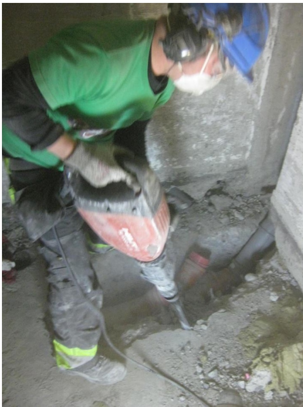
Kuva 6. Piikkausta. Kuva: Timo Soininen
