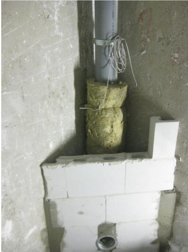
Kuva 4. Kylpyhuoneeseen muurattu hormi.
