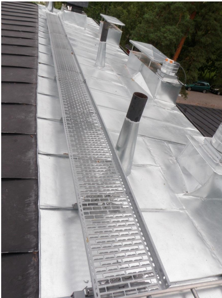
Kuva 1. Rivipeltikatteen läpivientejä, Case 2, kuva Olli Suominen, 2011
