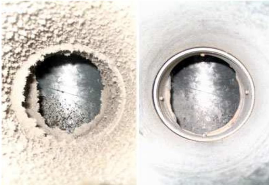
KUVA 2. Puhdistettava kanava ennen ja jälkeen puhdistuksen /7/
