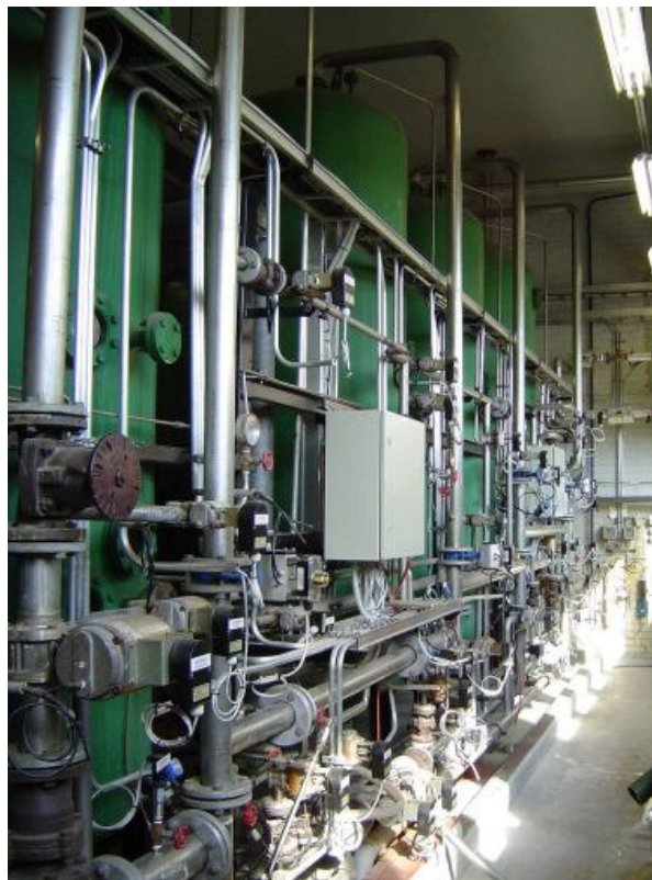
Kuva 13. Suomenojan voimalaitoksen ioninvaihdinsarja
