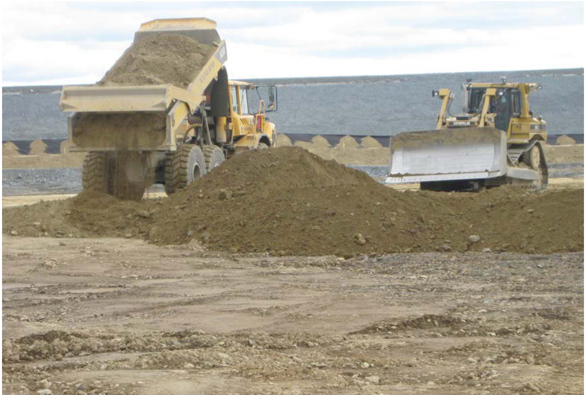
KUVA 1. Mineraalisen tiivistyskerroksen rakentamista pohjamaan päälle NP3-rikastushiekka-altaan työmaalla (Arffman. 2010)
