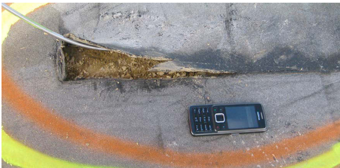
KUVA 27. Kuormakiilan aiheuttama kuljetusvaurio (Nousiainen. 2010)
