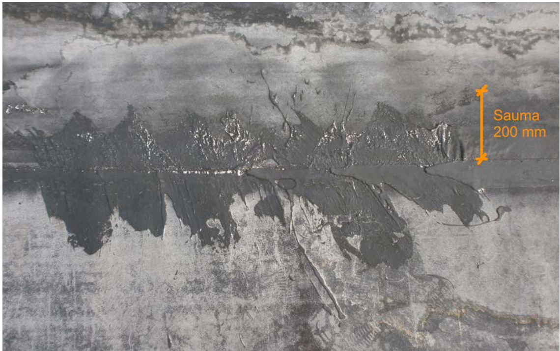
KUVA 33. Geomembraanien välisen sauman paikkaus ilman erillistä paikkalappua (2011)
