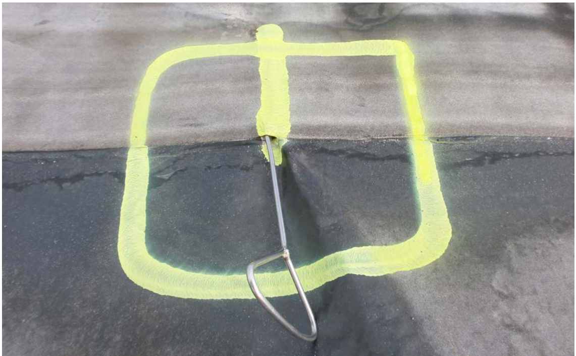
KUVA 26. Koko geomembraanien sauman leveydeltä läpi johtava vekki (2011)
