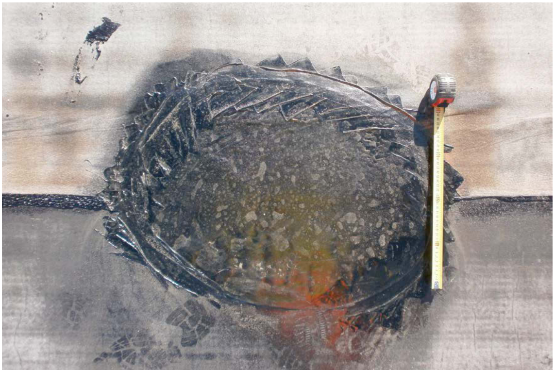
KUVA 32. Paikattu kohta geomembraanien välisessä saumassa (2011)
