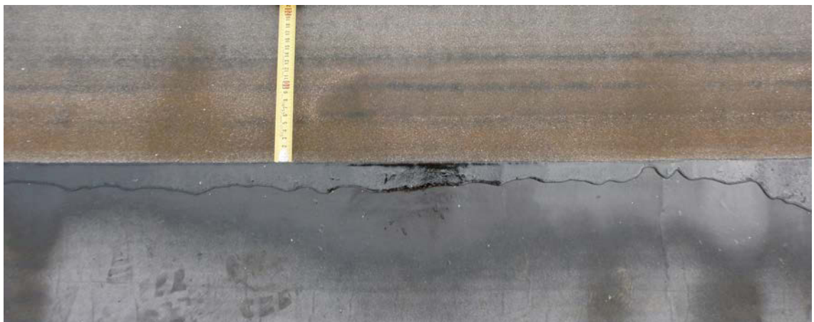
KUVA 14. Asentamisen laatuvaatimukset täyttävä sauma (2011)
