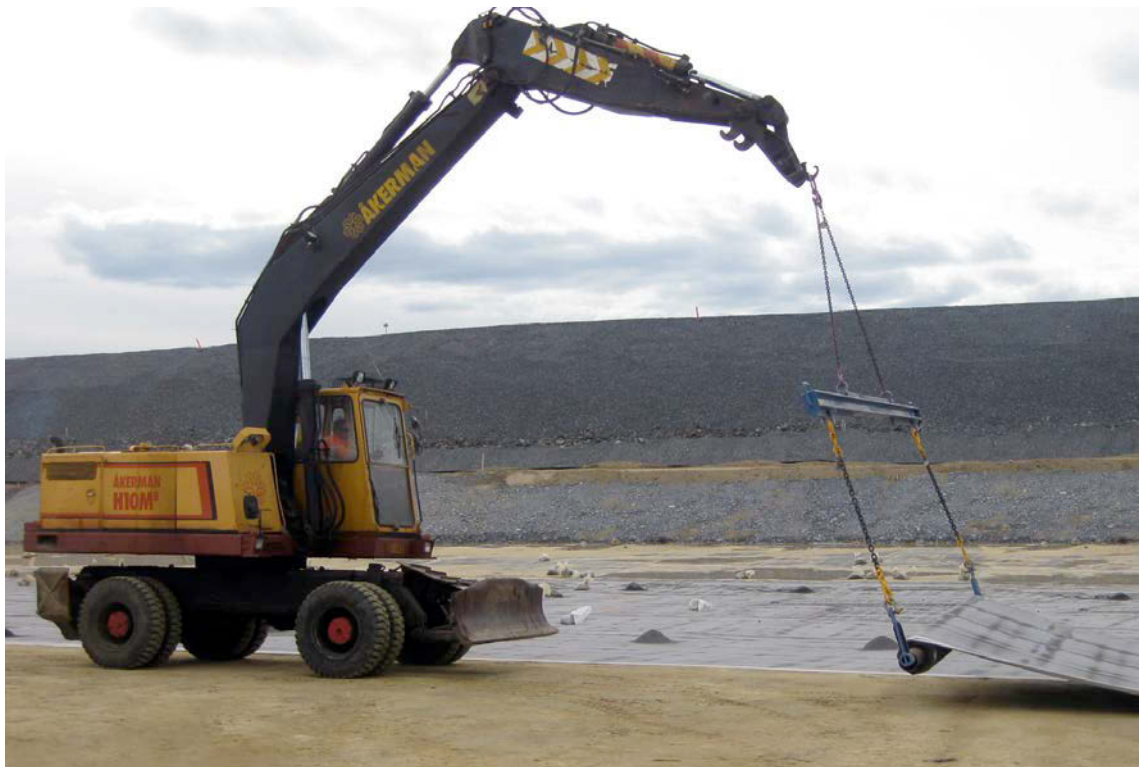
KUVA 7. Teranap 331 TP –kumibitumipohjaisien geomembraanien levitystä NP3-rikastushiekka-altaan työmaalla (Arffman. 2010)
