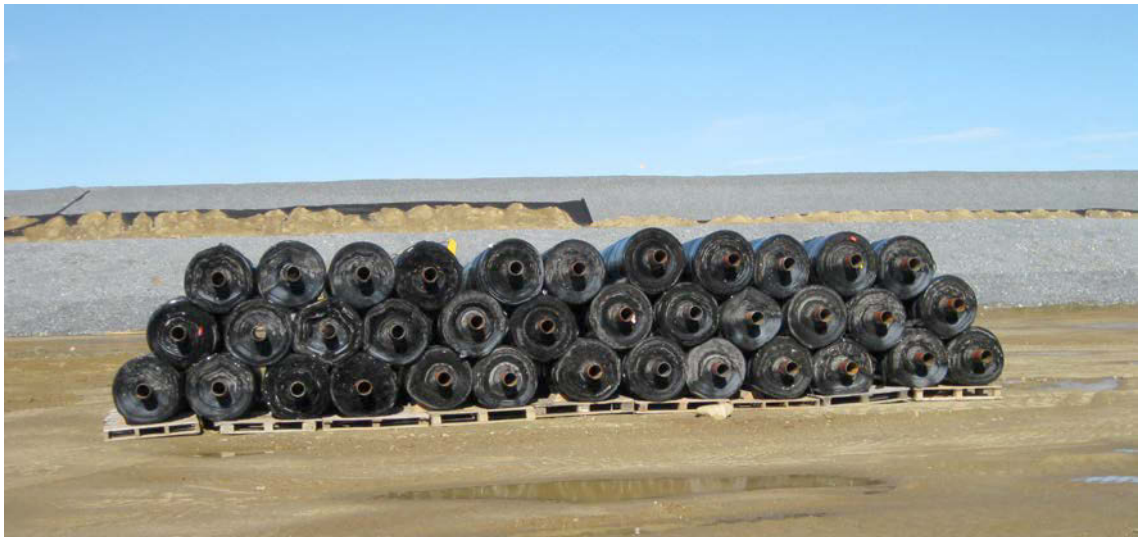
KUVA 6. Teranap 331 TP –kumibitumipohjaiset geomembraanit varastoitiin lastauslavojen päälle NP3-rikastushiekka-altaan työmaalla (Arffman. 2010)
