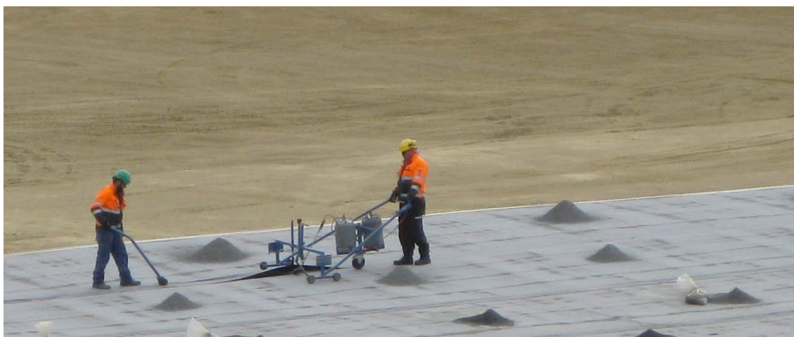
KUVA 10. Teranap 331 TP –kumibitumipohjaisien geomembraanien saumojen hitsaamista NP3-rikastushiekka-altaan työmaalla (Arffman. 2010)
