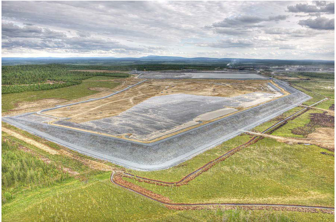
KUVA 3. NP3-rikastushiekka-allas kuvattuna sen rakennusvaiheessa pohjoisesta, takana näkyy myös NP-rikastushiekka-allas (Arffman. 2010)
