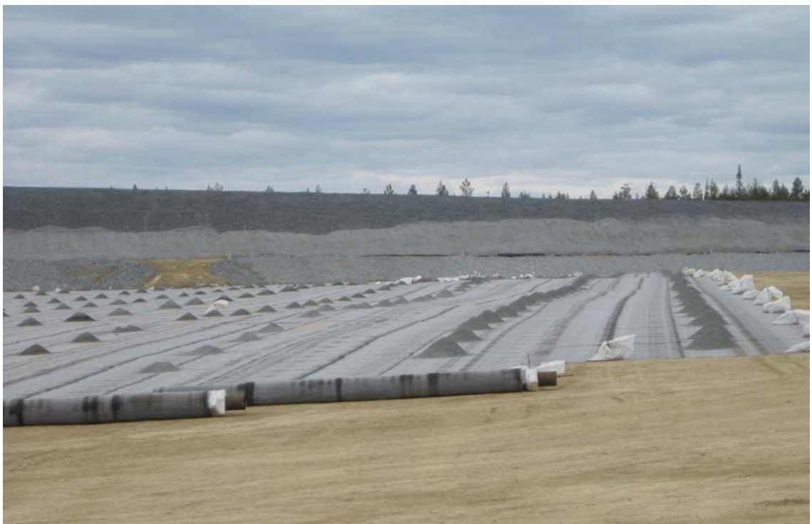
KUVA 9. Teranap 331 TP –kumibitumipohjaisien geomembraanien painotus toteutettiin murskeella ja hiekkasäkeillä NP3-rikastushiekka-altaan työmaalla (Arffman. 2010)
