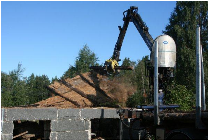
Kuva 2. Kivinavetan välikaton purku.
