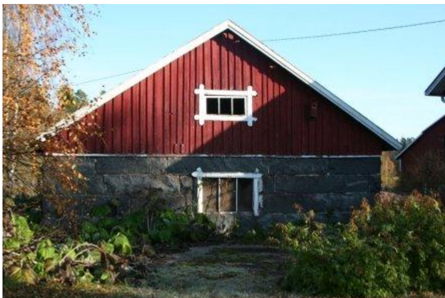
Kuva 1. Kivinavetta ennen muutostöiden aloittamista
