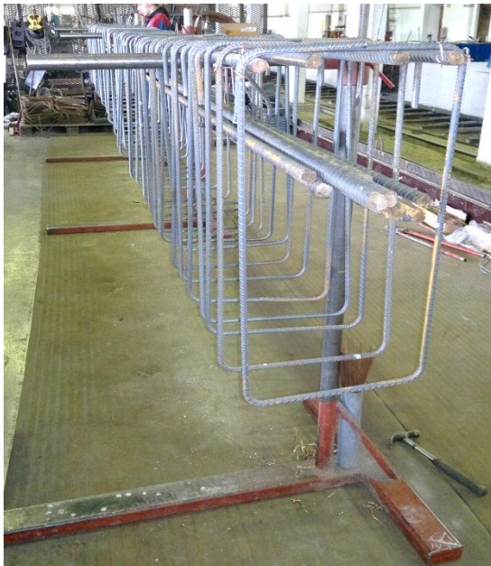
Kuva 2.9a. Pääterästen asennusvaihe (vas.) Kuva 2.9b. Työläs pilarin pään raudoite (oik.)
