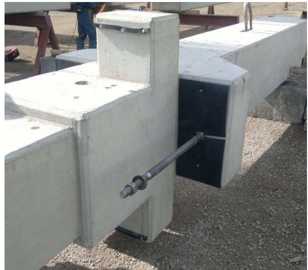
Kuva 3.3a. HALFEN HSC-konsolinraudoite (vas.) (Halfen.fi a.) Kuva 3.3b. Useita konsoleita samassa pilarin poikkileikkauksessa (oik.)
