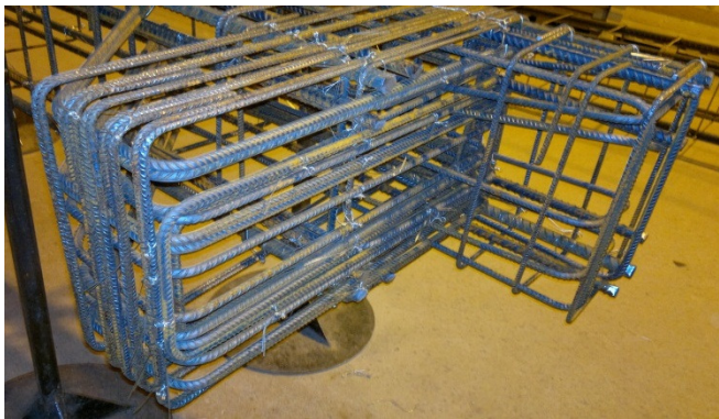
Kuva 3.4a. Ahdas konsolinraudoite (vas.) Kuva 3.4b. Jännitetty betonikonsoli (oik.) (Peem Ltd.)
