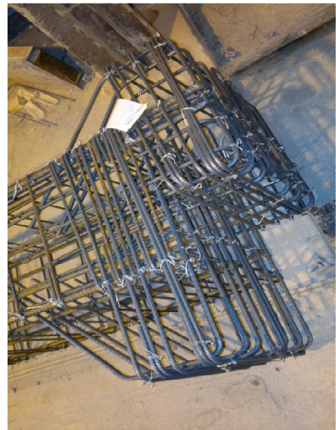
Kuva 2.9a. Pääterästen asennusvaihe (vas.) Kuva 2.9b. Työläs pilarin pään raudoite (oik.)
