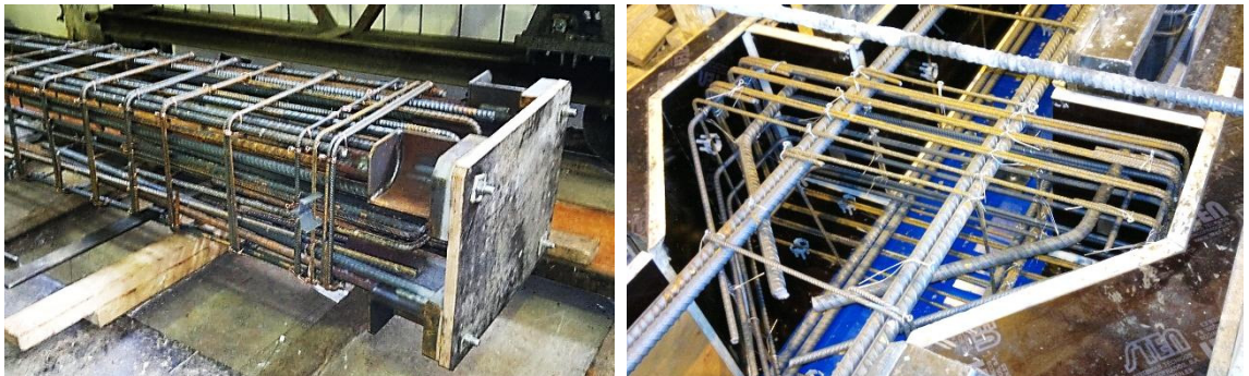
Kuva 2.10a. Raskas pilarin alapään raudoite (vas.) Kuva 2.10b. Muotin sisälle asetettu valmis pilarin raudoite (oik.)
