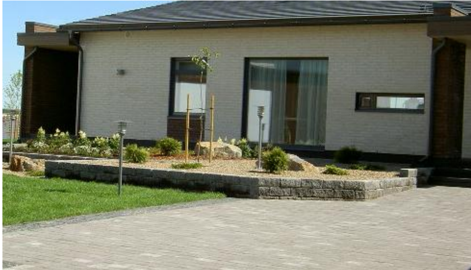
Kuva 3. Merilokinkaarella autopiha päällystetään betonikivillä.
